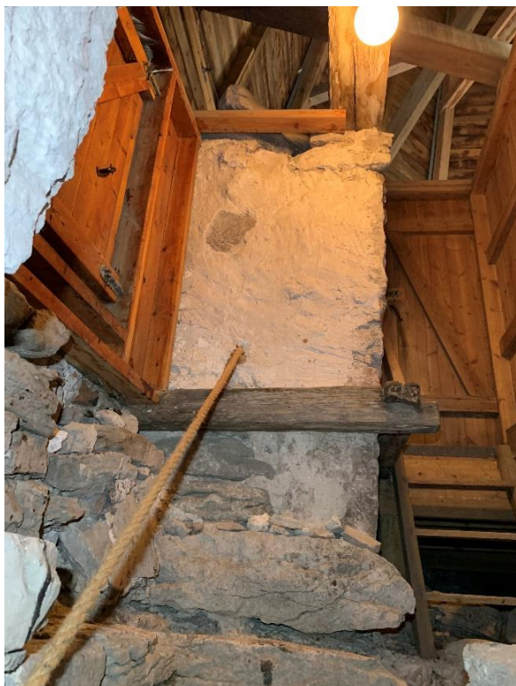
Murtrappans mynning i den norra av de två östra ljudgluggarna, sett mot söder, nu tillsluten av en lucka. Till höger detalj av trappans övre del, som visar att den förefaller ombyggd och sannolikt fortsatt ytterligare ett stycke. Foto JL 2021.
