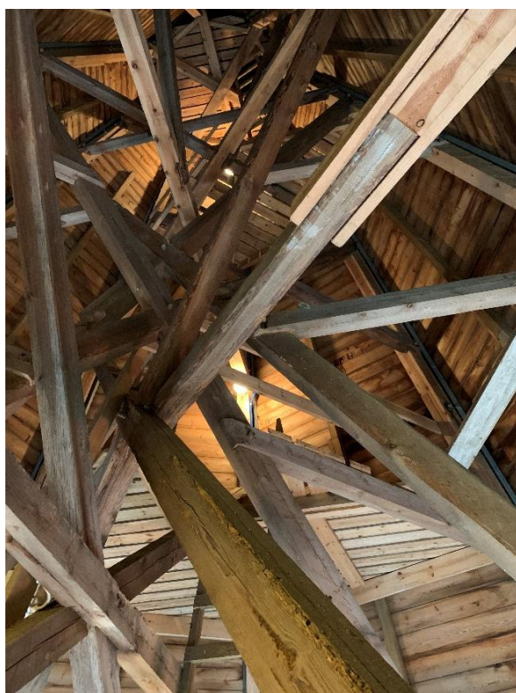
Del av tornets murkrön och remstycken till tornhuven. Till höger tornhuven sedd underifrån och uppåt. Foto JL 2021.
