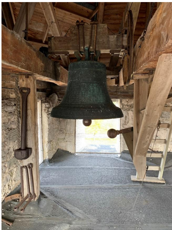
Klockans upphängning mellan två bjälkar. Till höger bockförstärkning av klockans bärande bjälkar. Foto JL 2021.
