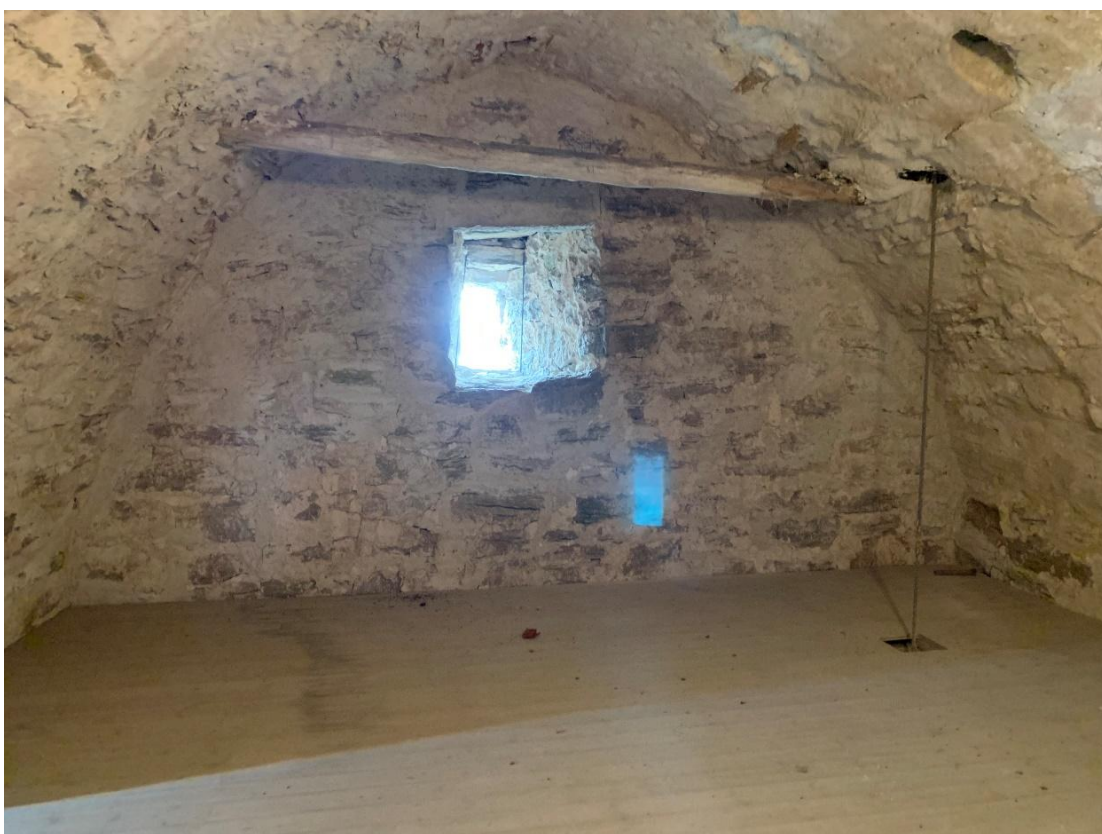
Tornets tredje övervåning mot söder. Foto JL 2021.
