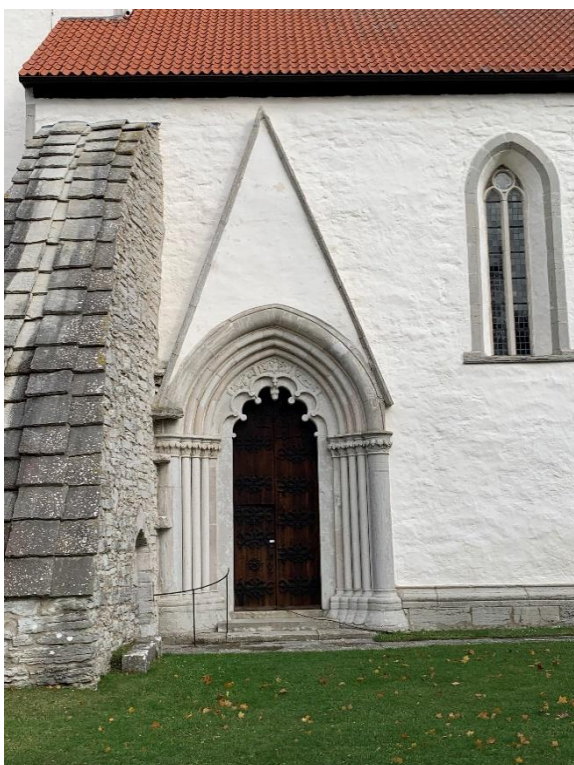
Långhusets södra portal och strävpelaren. Strävpelarens avtäckning med kalkstenshällar tillkom 1984. Den äldre bilden visar att strävpelaren tidigare varit putsad. Foto JL 2021 respektive Carl R. af Ugglas 1907-10, ATA.
