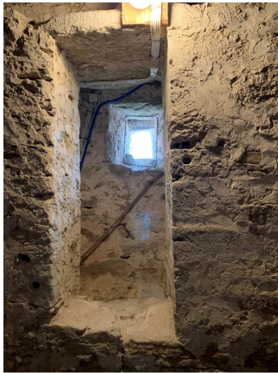
Tornets första övervåning sedd mot öster genom öppningen från murtrappan. Till höger öppningen från murtrappan sedd från öster. I omfattningen finns håltagningar för en dörr med låsanordning. Foto JL 2021.
