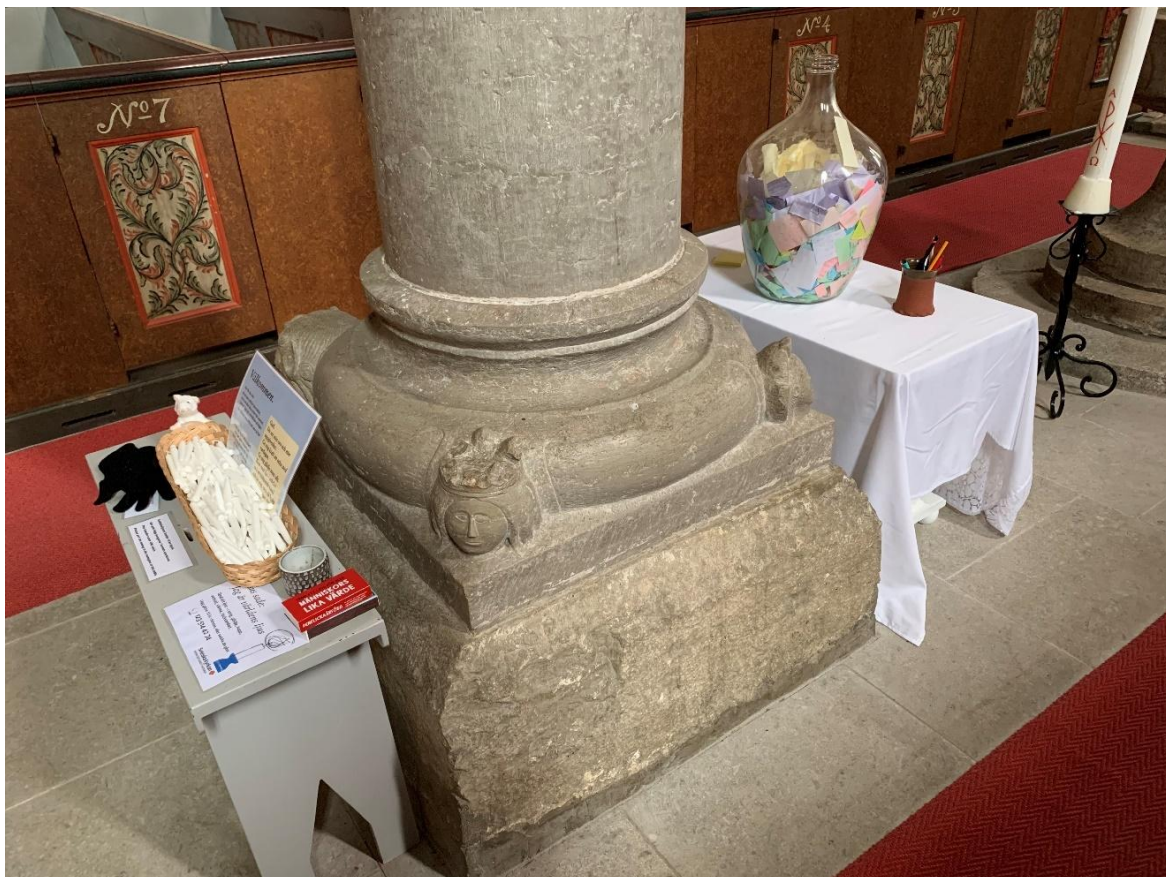
Östra långhuskolonns bas sedd från sydväst. Foto JL 2021.
