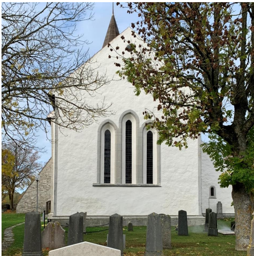
Korets östfasad. Foto JL 2021.
