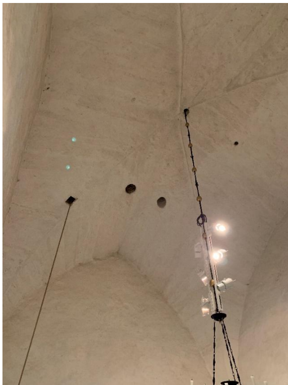
Ringkammarens valv sett mot nordväst med hål för klocklinor. Till höger valvet och tornbågens övre del sett mot öster. Muren och bågen är i efterhand inbyggda under valvet. Foto JL 2021.
