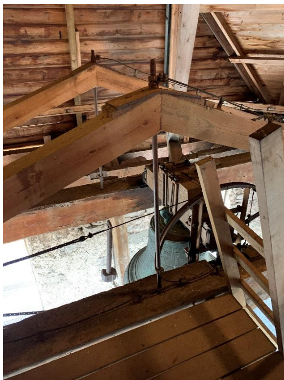
Klockans upphängning mellan två bjälkar. Till höger bockförstärkning av klockans bärande bjälkar. Foto JL 2021.
