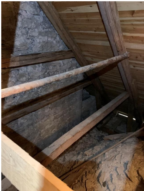
Långhusvindens nordvästra hörn med tornets nordöstra hörnkedja synlig. Till höger långhusvindens nordöstra hörn med ett stycke av långhusets gavelmur, sannolikt byggd vid takens sänkning 1857. Foto JL 2021.
