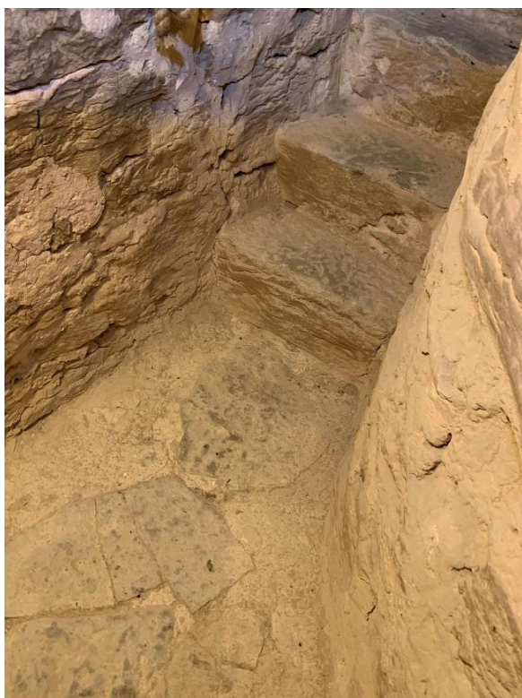
Murtrappans vilplan i tornets sydvästra hörn. Till höger murtrappan i tornets västra mur, sedd uppåt mot norr. Foto JL 2021.
