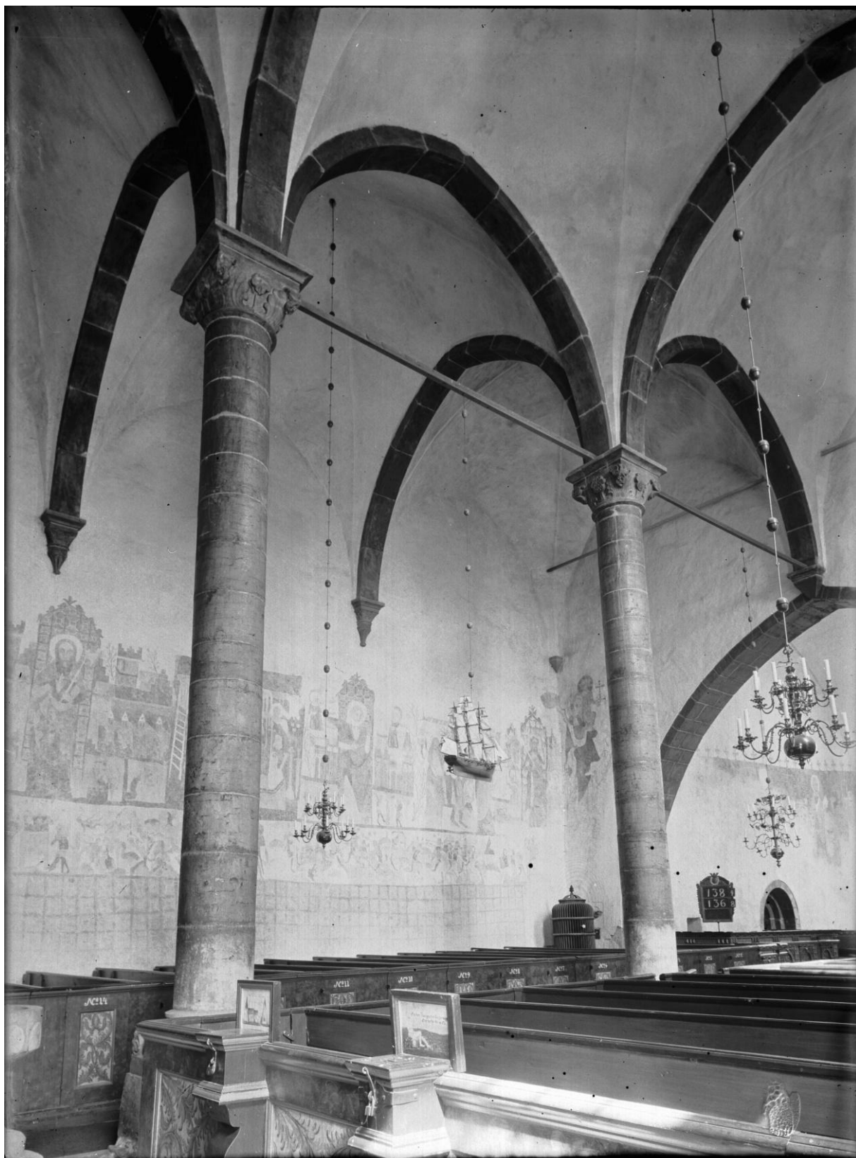
Interiör mot sydöst efter restaureringen 1916-18. Kalkmålningarna har tagits fram av konservator Carl Wilhelm Peterson liksom inredningens äldre färgsättning. Huggstensytorna ännu bemålade, utom kring baserna. Dopfunten uppställd i långhusets västra del. Foto Alfred Edle ca 1930, ATA.
