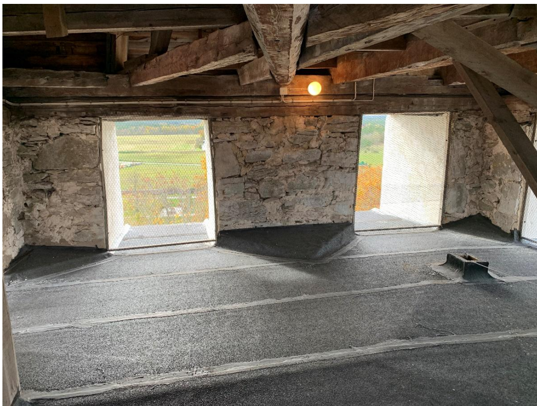
Klockvåningen mot söder. Murverket mellan ljudgluggarna är mer oregelbundet än i tornets nedre delar. Foto JL 2021.
