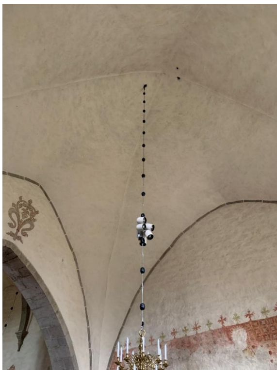
Korvalvet sett mot nordväst och öster. Hålen i valvets hjässa är sannolikt för ljuskronan. Det större, längre ned i högra bilden, rakt ovanför altaret är sannolikt en så kallad ljudkruka för akustikens skull. Foto JL 2021.
