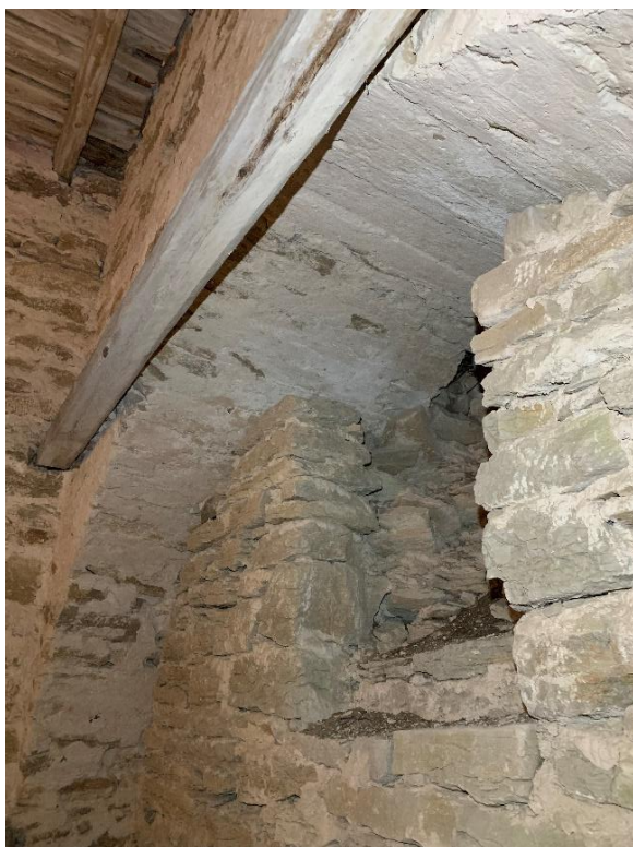
Båge och tidigare öppning i tornets första övervåning mot nordöst och öster. Bågen från tornets byggnadstid bär östra tornmuren och tillslöts på östra sidan sannolikt av det äldre långhusets murade västgavel. När det romanska långhuset skulle rivas tillkom utfyllnadsmuren för att ge stadga åt valvet över ringkammaren. En öppning sparades i öster. När det nya långhuset välvdes minskades öppningen till en trång passage uppåt till vinden. Denna igensattes, sannolikt när ny vindspassage togs upp i våningen ovanför. Foto JL 2021.
