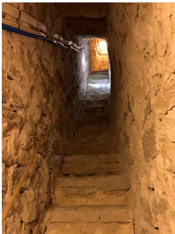
Öppning i ringkammarens sydöstra hörn till tornuppgången. Till höger trappan i tornets södra mur sedd uppåt mot väster. Foto JL 2021.
