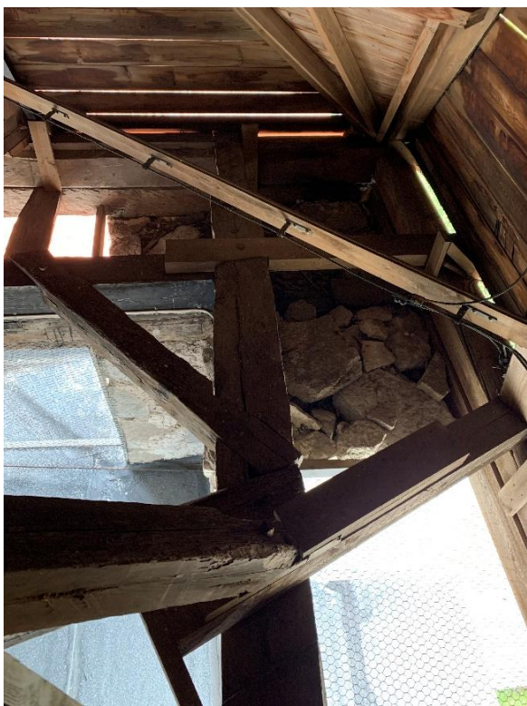
Del av tornets murkrön och remstycken till tornhuven. Till höger tornhuven sedd underifrån och uppåt. Foto JL 2021.
