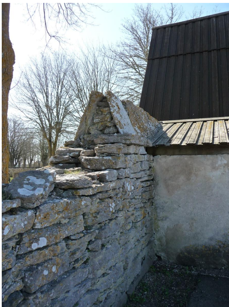
Den västra mursträckningen vid den tidigare stallbyggnaden. Över muren finns sadeltaksformade täckstenar över en horisontellt liggande täcksten. Foto ES 2021.
