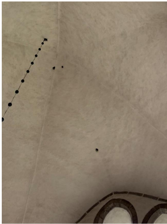
Korvalvet sett mot nordväst och öster. Hålen i valvets hjässa är sannolikt för ljuskronan. Det större, längre ned i högra bilden, rakt ovanför altaret är sannolikt en så kallad ljudkruka för akustikens skull. Foto JL 2021.
