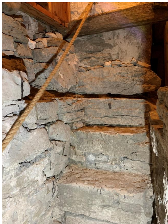
Murtrappans mynning i den norra av de två östra ljudgluggarna, sett mot söder, nu tillsluten av en lucka. Till höger detalj av trappans övre del, som visar att den förefaller ombyggd och sannolikt fortsatt ytterligare ett stycke. Foto JL 2021.
