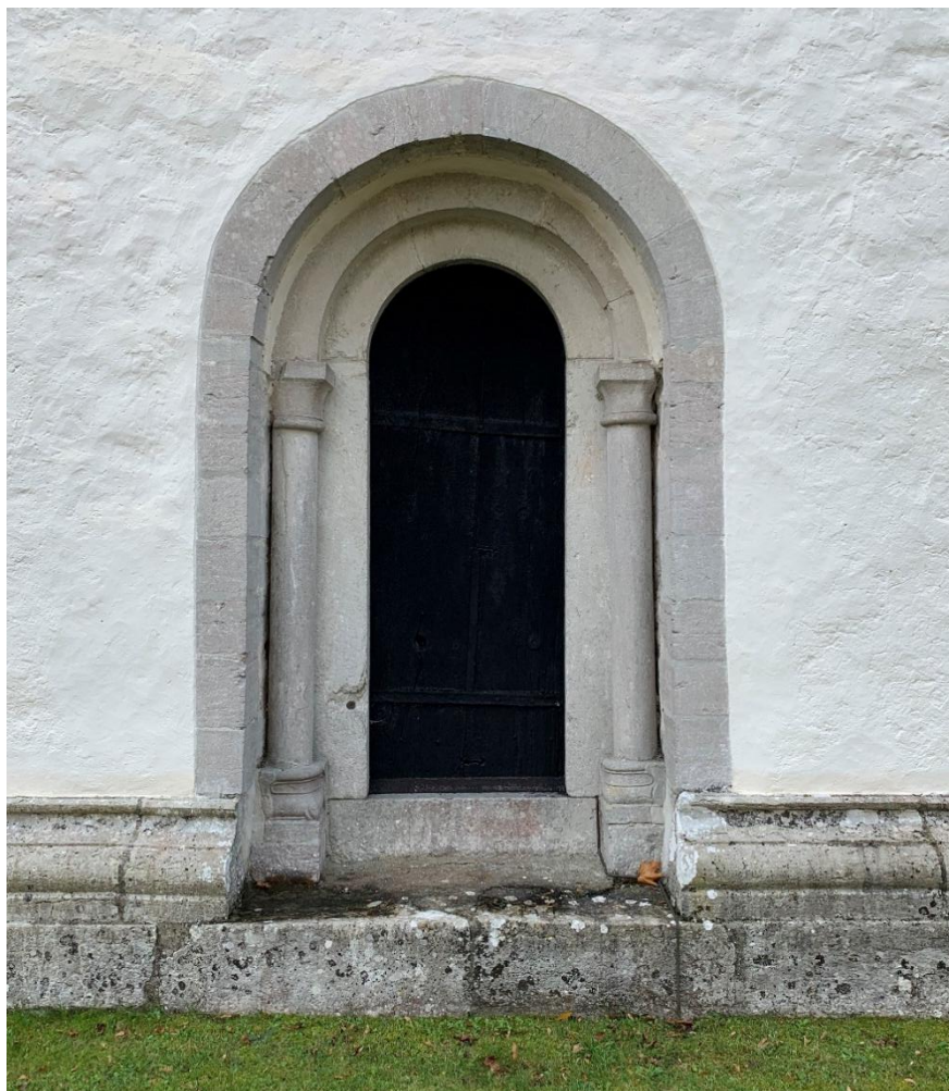
Långhusets nordportal, sannolikt tidigare sydportal i det rivna romanska långhuset. Foto JL 2021.
