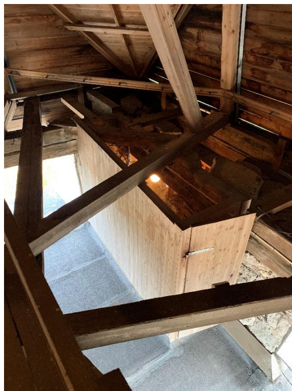
Trappans mynning i klockvåningen med bevarad sida av en murad karm som visar att öppningen till klockvåningen tidigare sett annorlunda ut än nu och sannolikt inte mynnat i en ljudglugg. Till höger inbyggnad av trä kring trappans mynning i klockvåningens nordöstra hörn. Foto JL 2021.
