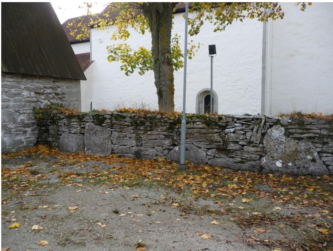
Den norra musträckningen väster om stigluckan. I muren finns flera större stenblock. Vid stigluckan syns spår efter den högre muren. Foto ES 2021.
