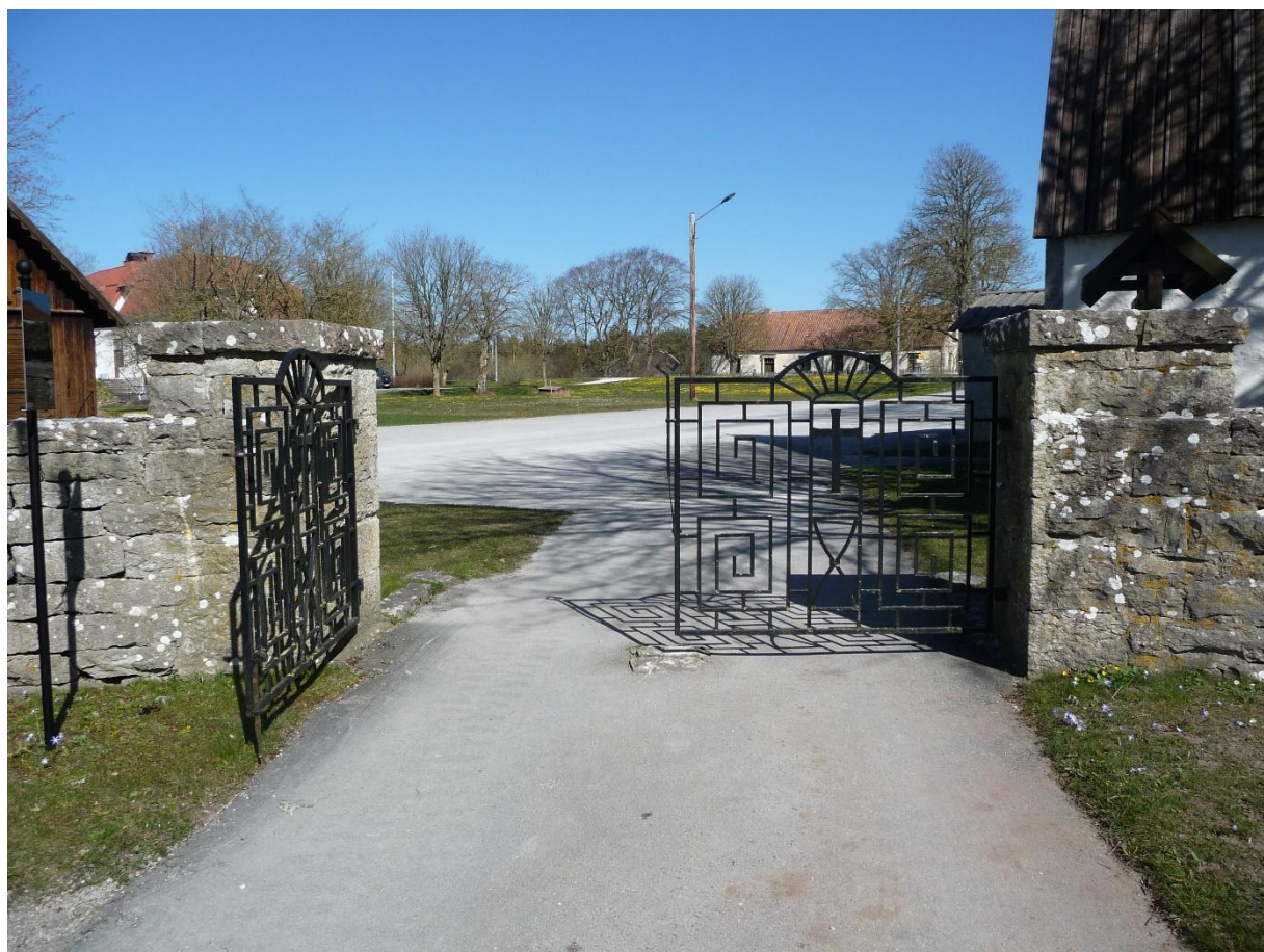
Vid ingången till den yngre kyrkogården finns en dubbel järngrind med fyrkantiga stolpar i bruksmurad kalksten med överliggare. Foto ES 2021.
