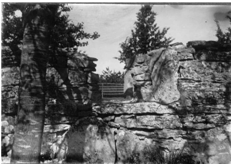
Nisch i kyrkogårdsmurens västra sträckning? Foto C W Pettersson 1917. RAÄ, Kulturmiljöbild.
