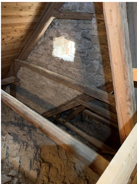
Långhusvindens nordvästra hörn med tornets nordöstra hörnkedja synlig. Till höger långhusvindens nordöstra hörn med ett stycke av långhusets gavelmur, sannolikt byggd vid takens sänkning 1857. Foto JL 2021.
