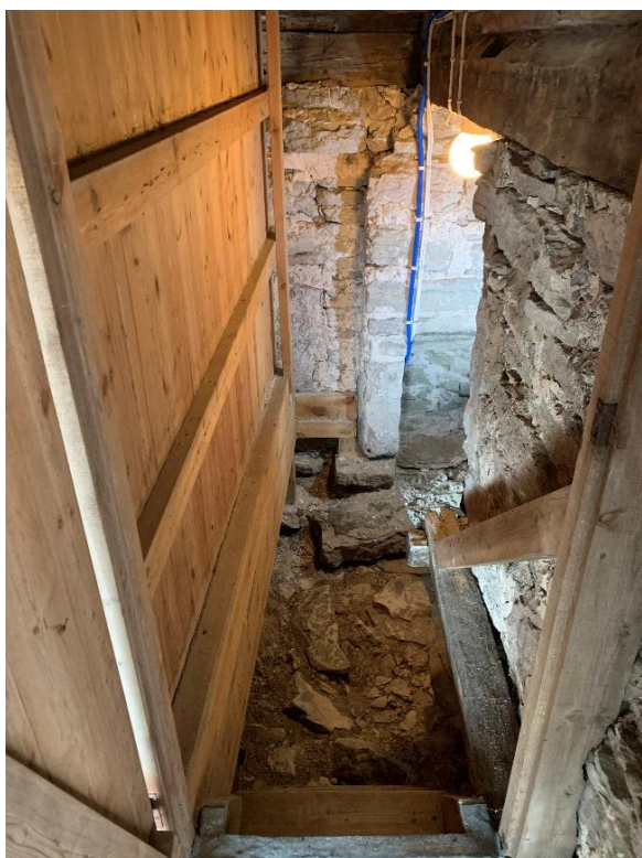
Trappans mynning i klockvåningen med bevarad sida av en murad karm som visar att öppningen till klockvåningen tidigare sett annorlunda ut än nu och sannolikt inte mynnat i en ljudglugg. Till höger inbyggnad av trä kring trappans mynning i klockvåningens nordöstra hörn. Foto JL 2021.
