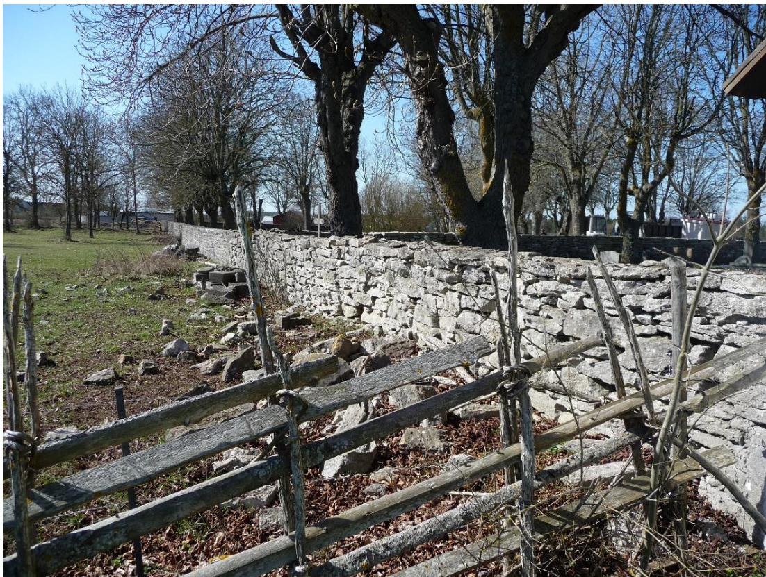
Den östra musträckningen. Foto ES 2021.
