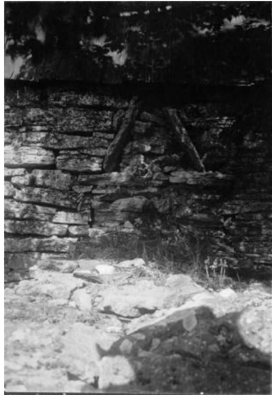
Nisch i kyrkogårdsmurens västra sträckning. Foto C W Pettersson 1917. RAÄ, Kulturmiljöbild.
