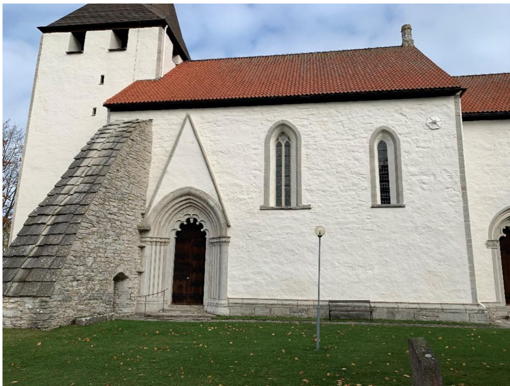
Långhusets södra fasad. Skillnaden på fönstrens form beror sannolikt snarare på en önskan om att göra det mellersta fönstret rikare och större än det andra än på att det skulle markera ett byggnadsuppehåll. Foto JL 2021.
