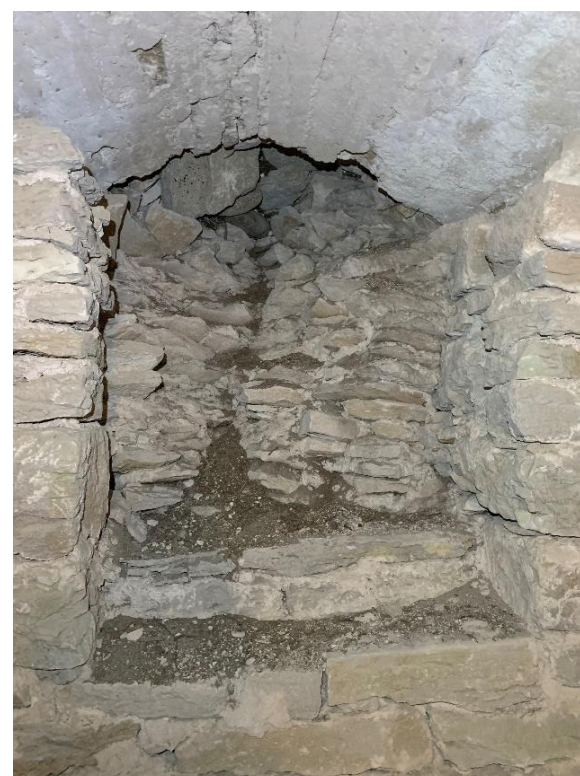
Båge och tidigare öppning i tornets första övervåning mot nordöst och öster. Bågen från tornets byggnadstid bär östra tornmuren och tillslöts på östra sidan sannolikt av det äldre långhusets murade västgavel. När det romanska långhuset skulle rivas tillkom utfyllnadsmuren för att ge stadga åt valvet över ringkammaren. En öppning sparades i öster. När det nya långhuset välvdes minskades öppningen till en trång passage uppåt till vinden. Denna igensattes, sannolikt när ny vindspassage togs upp i våningen ovanför. Foto JL 2021.
