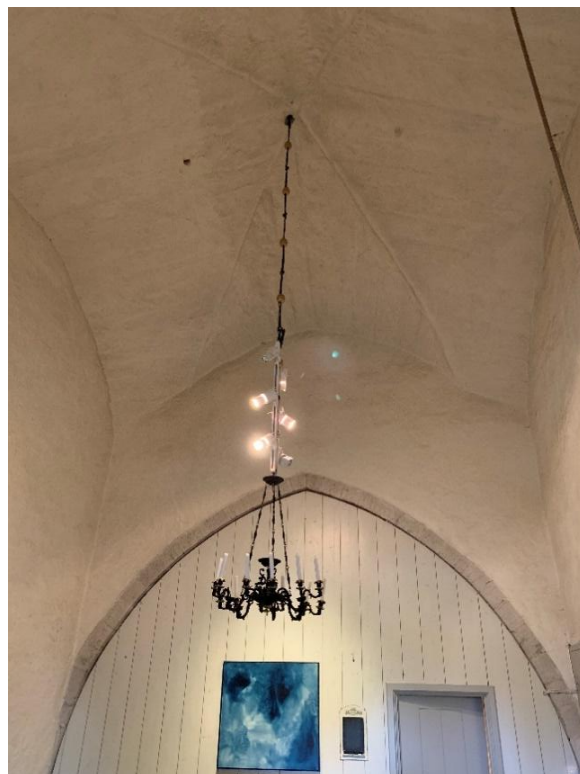
Ringkammarens valv sett mot nordväst med hål för klocklinor. Till höger valvet och tornbågens övre del sett mot öster. Muren och bågen är i efterhand inbyggda under valvet. Foto JL 2021.
