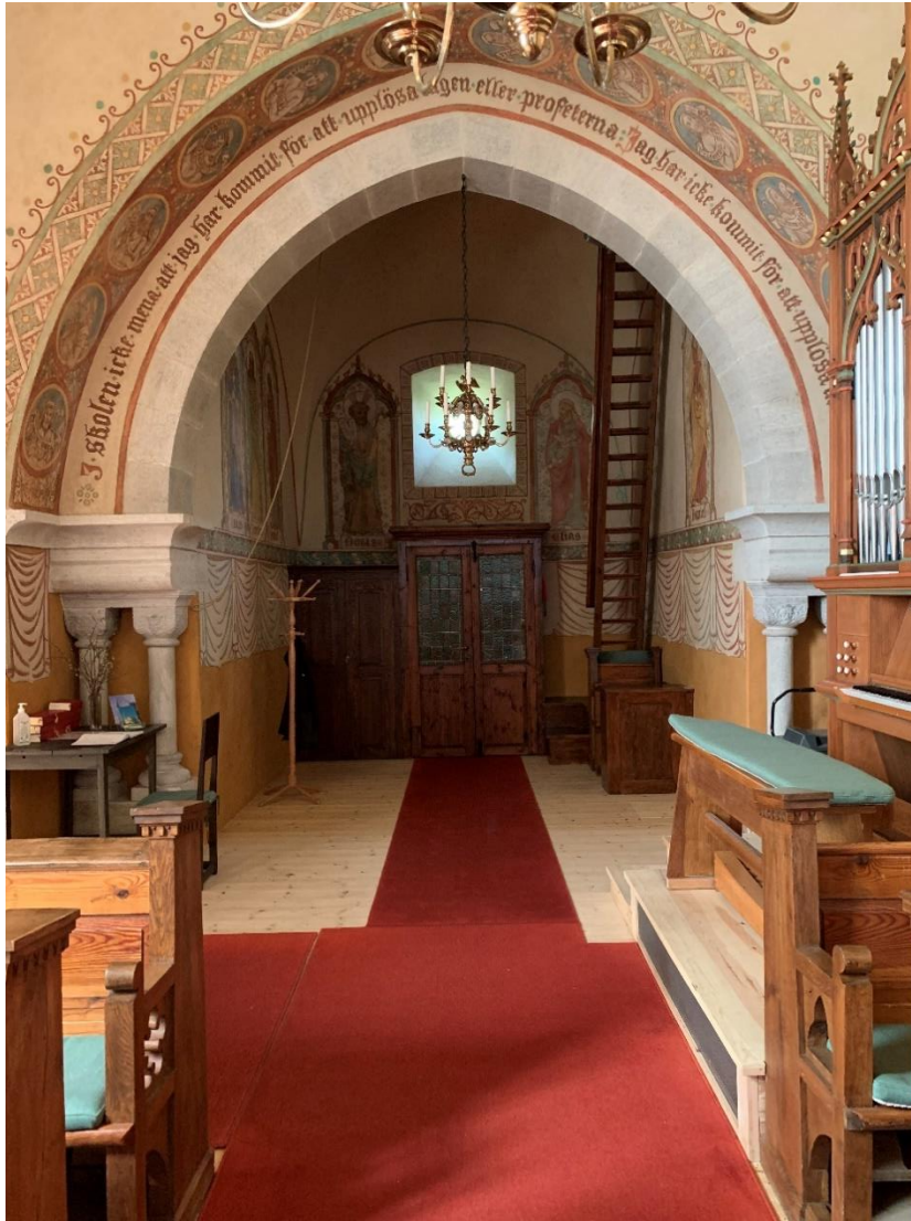
Tornbågen och ringkammaren från öster. Foto JL 2022. Tornbågen förändrades 1900-02 då bland annat bågen och dess vederlag av huggen kalksten tillkom.
