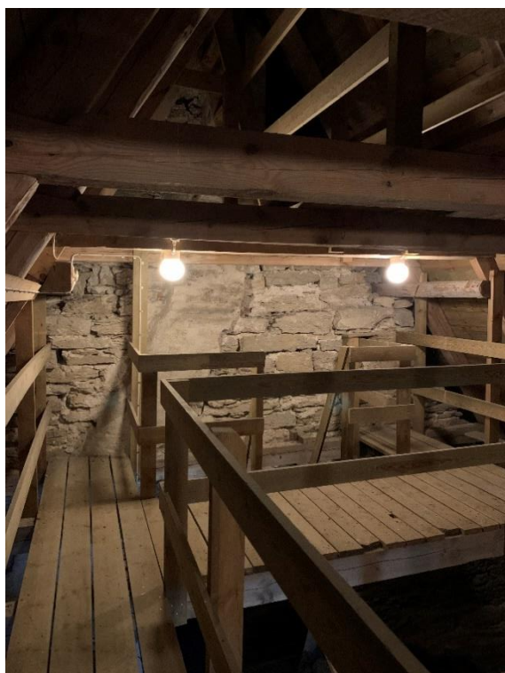
Långhusvinden mot öster på en nivå högre upp från valvet. Avtryck från skorstenen synliga. Till höger kvarsittande brädkonstruktion i den tidigare öppningen mellan kor- och långhusvind. Foto JL 2022.
