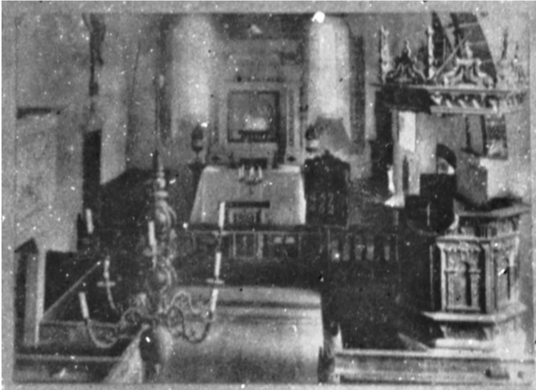
Interiör mot öster före 1900-02, troligen på 1890-talet. Märk det igensatta mittfönstret. Foto Bengt Bergman 1927, ATA, efter fotografi i privat ägo, detalj.
