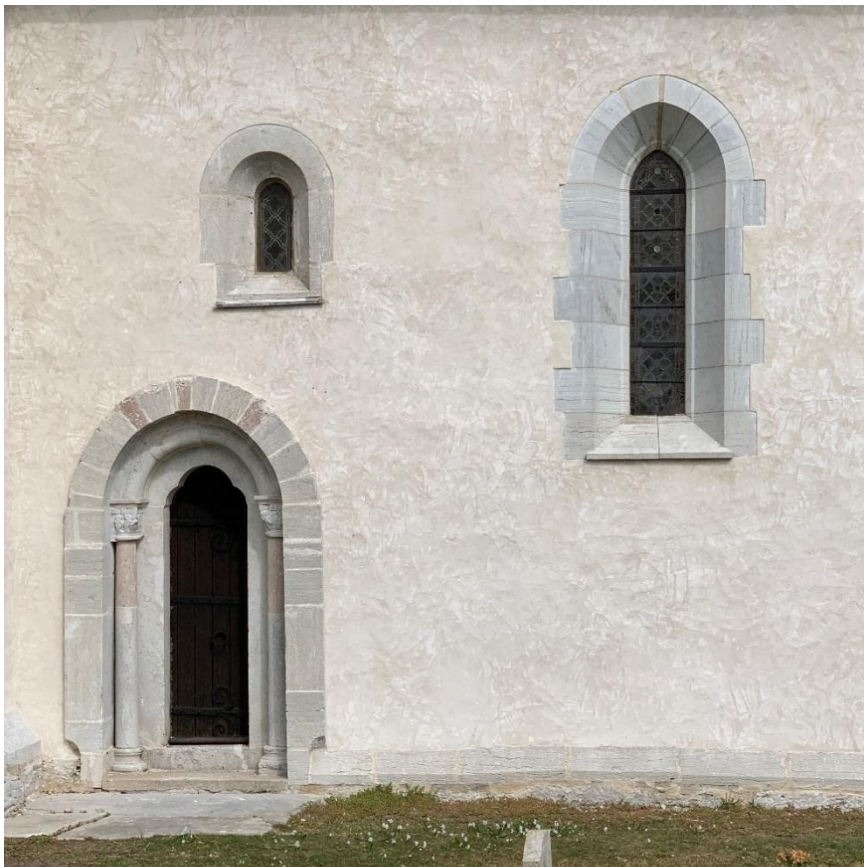
Korets sydfasad med portal och litet fönster, överförda från den äldre kyrkan, samt större fönster med form och omfattning från 1900-02. Foto JL 2022.
