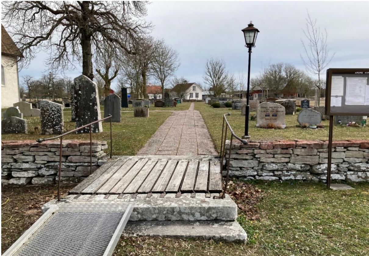
Den västra ingången med en bevarad färäst och järnräcken. Foto ES 2022.
