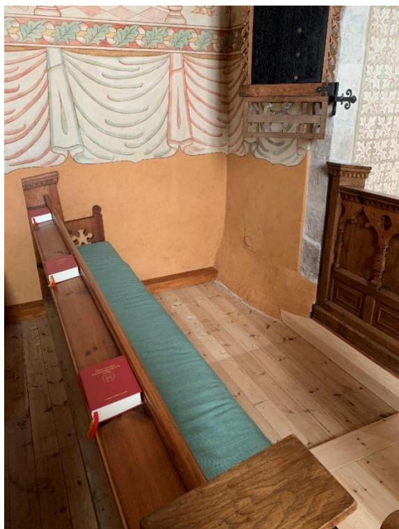
Långhusets nordöstra hörn med murklack, möjligen från ett tidigare sidoaltare. Luckan är från rökröret till den kamin som från 1900-02 till 1933 stod här. Till höger predikstolstrappan. Foto JL 2022.
