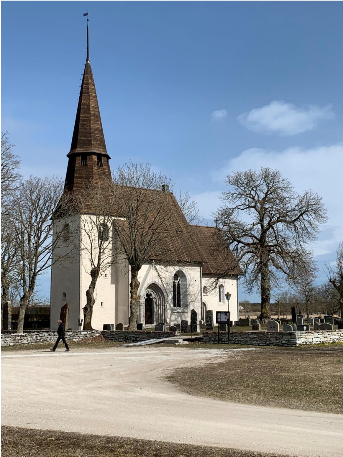
Exteriör från sydväst. Foto JL 2022.
