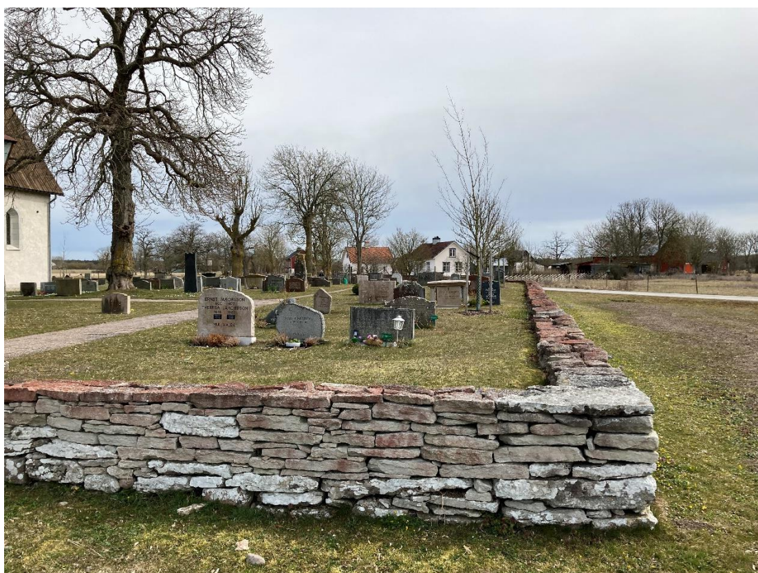
Den södra delen av kyrkogården tillkommen i mitten av 1900-talet, före 1961 omgärdas av en låg kallmurad kalkstensmur. Foto ES 2022.
