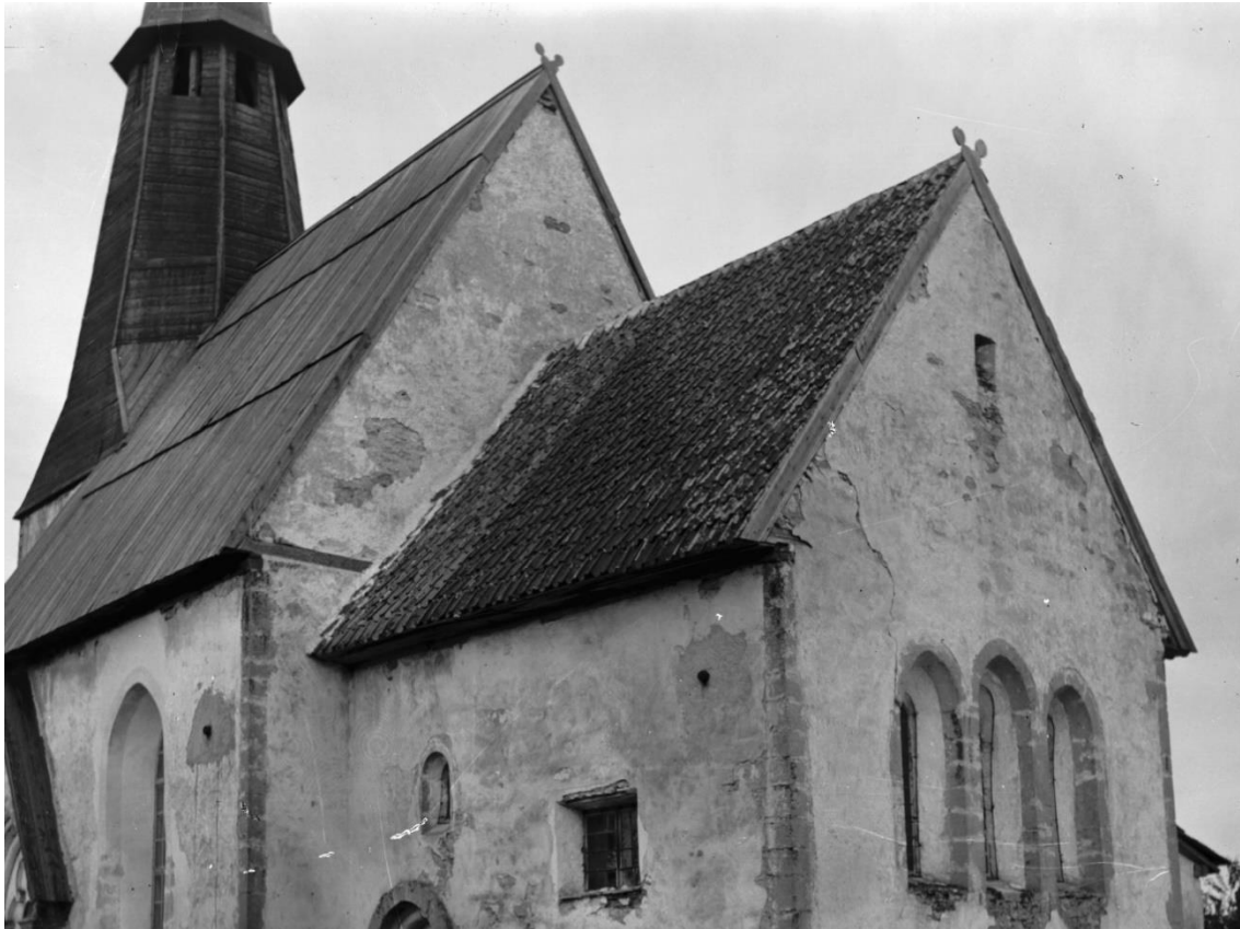
Detalj av foto av Olof Sörling 1889. En svag linje på långhusets östgavel antyder att koret tidigare haft en brantare taklutning, motsvarande den nuvarande, men att den sänkts, sannolikt när taket belades med tegel. Putsen kompletterad kring det utvidgade långhusfönstret och kring ankarslutarna.
