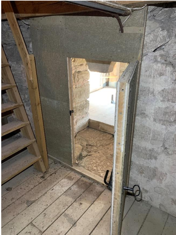
Passage till långhusvinden genom den östra ljudgluggen, sedd från öster. Till höger murparti norr om den östra ljudgluggen med kvarstående puts på tornets östra sida från tiden innan långhusets tillkomst. Foto JL 2022.
