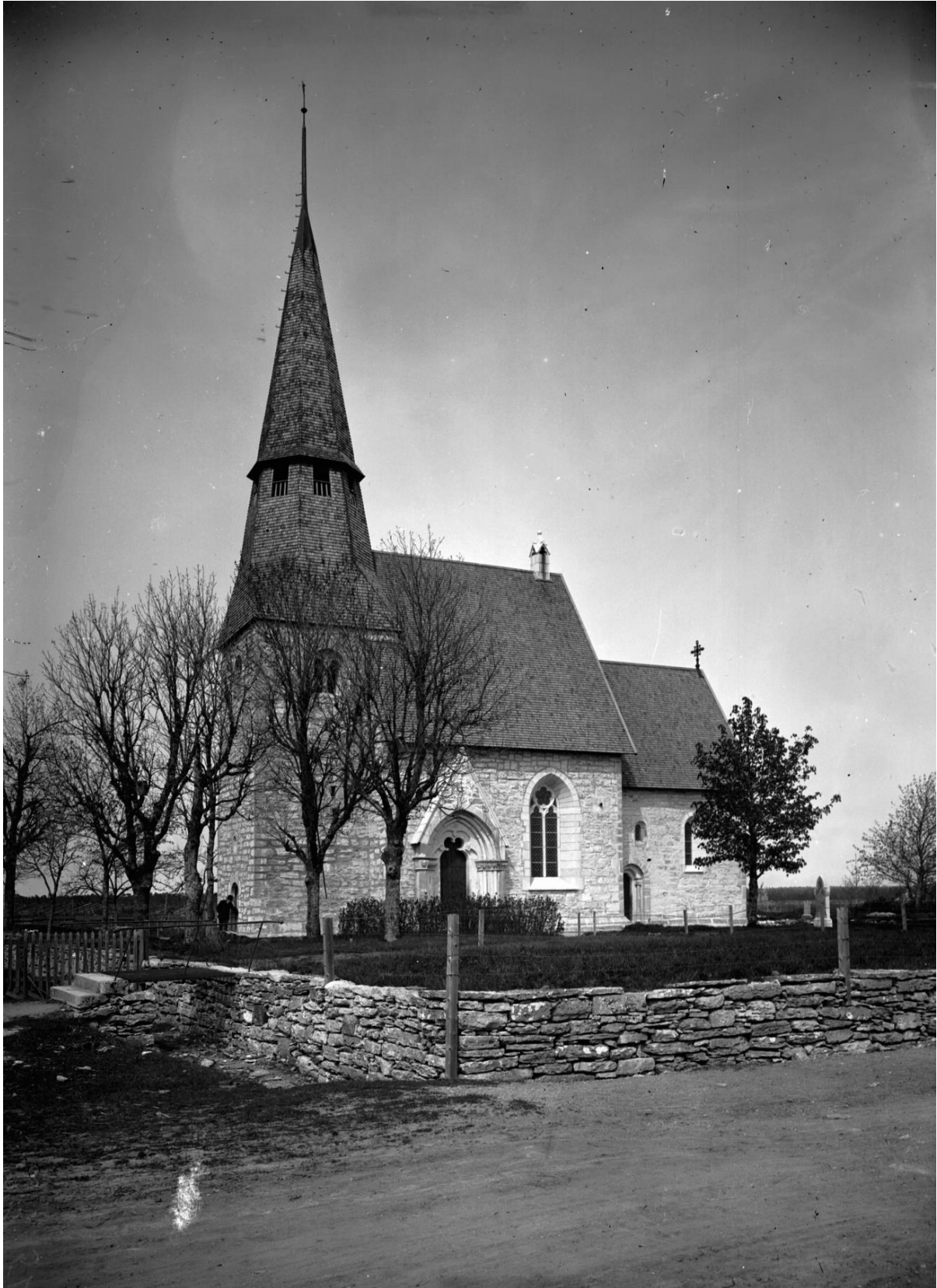
Exteriör från sydväst efter restaureringen 1900-02. Foto J. W. Hamner 1908, ATA. Tornhuven är sänkt, kortaket höjt, två av fasadens fönster har ny form och omfattning, murverket har frilagts och alla tak täckts av spån.
