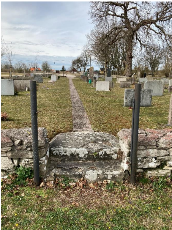
Den östra ingången med en trappa med ett par trappsteg, flankerad av järnstolpar. Mellan den västra och östra ingången finns en smal gång belagd med cementplattor. Foto från öster, ES 2022.
