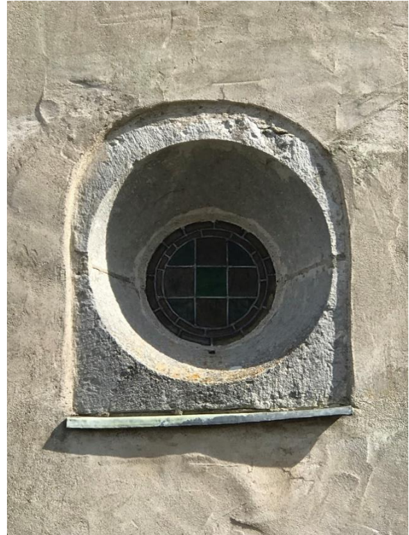
Rundfönster i tornets västfasad, till höger i släpljus som genom skuggan visar att stenarna är rundade, vilket talar för att fönstret tidigare har suttit i den äldre kyrkobyggnadens absid. Foto JL 2022 respektive 2018.
