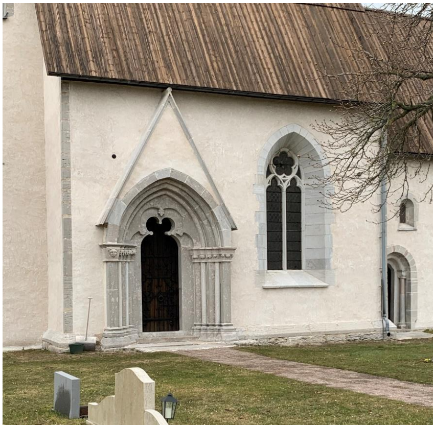
Långhusets sydfasad. Foto JL 2022.
