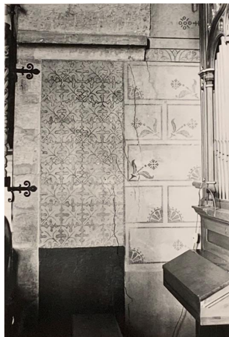
Koret mot norr med orgelns dåvarande placering. Foto Nils Lagergren 1960, ATA. Till höger triumfbågens norra vederlag ett årtionde senare. Orgeln har flyttats längre in mot koret och i murverket har rörelsesprickor frilagts som talar för att koret och långhuset kanske inte är uppförda i ett sammanhang. Foto Lennart Garmfors (?), Restaureringsteknik AB, 1971, Gotlands Museums arkiv (GFF897_166).
