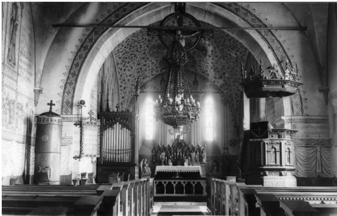
Interiör mot öster sedan den konserverade medeltida altaruppsatsen återplacerats 1923 och innan kaminen avlägsnades 1933 (?). Foto Årland Noréén 1932, ATA. Sot och damm har fastnat i kondens på murarna, men inte på putsen utanpå den inbilade rökkanalen.
