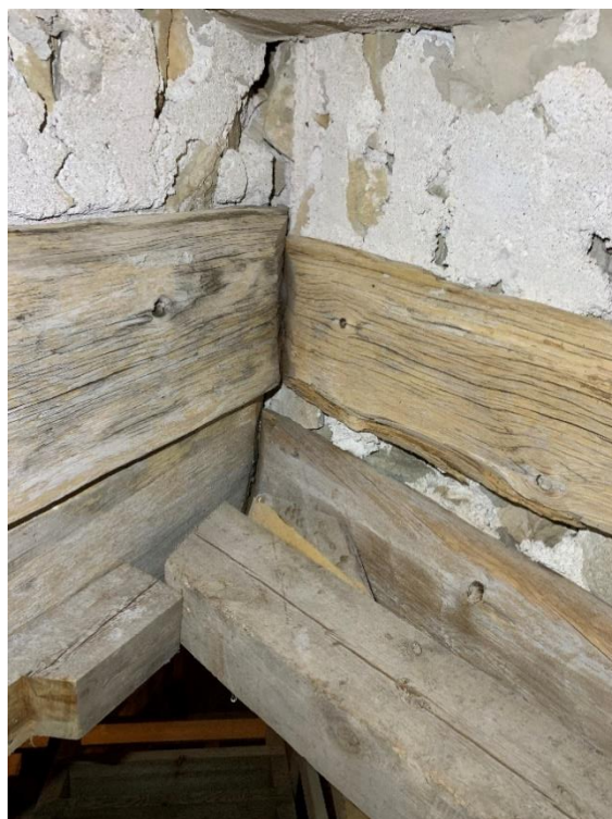
Långhusvinden mot öster på en nivå högre upp från valvet. Avtryck från skorstenen synliga. Till höger kvarsittande brädkonstruktion i den tidigare öppningen mellan kor- och långhusvind. Foto JL 2022.
