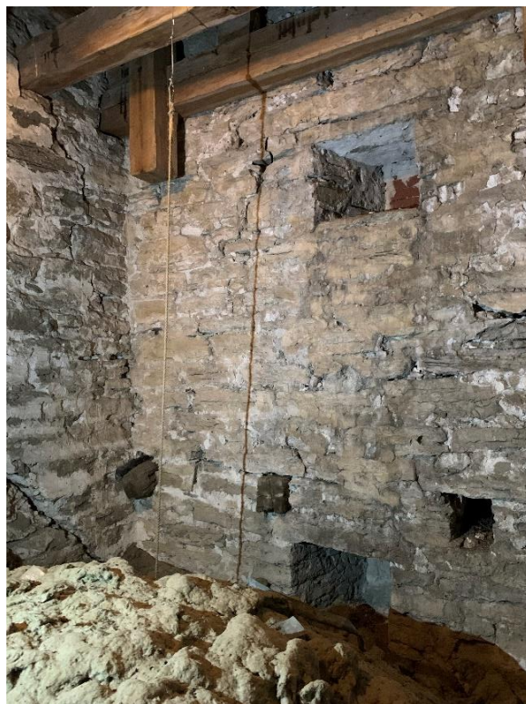
Tornets första övervåning mot nordöst med uppgången genom valvet. Till höger tornets första övervåning mot sydöst. Bjälkarna härrör från tidigare bjälklag mellan den ursprungliga första och andra övervåningen. Ljusgluggarna igenmurades 1973-75. Foto JL 2022.
