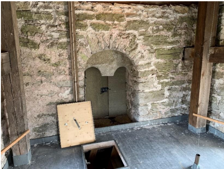
Tornets andra övervåning mot öster. Foto JL 2022.
