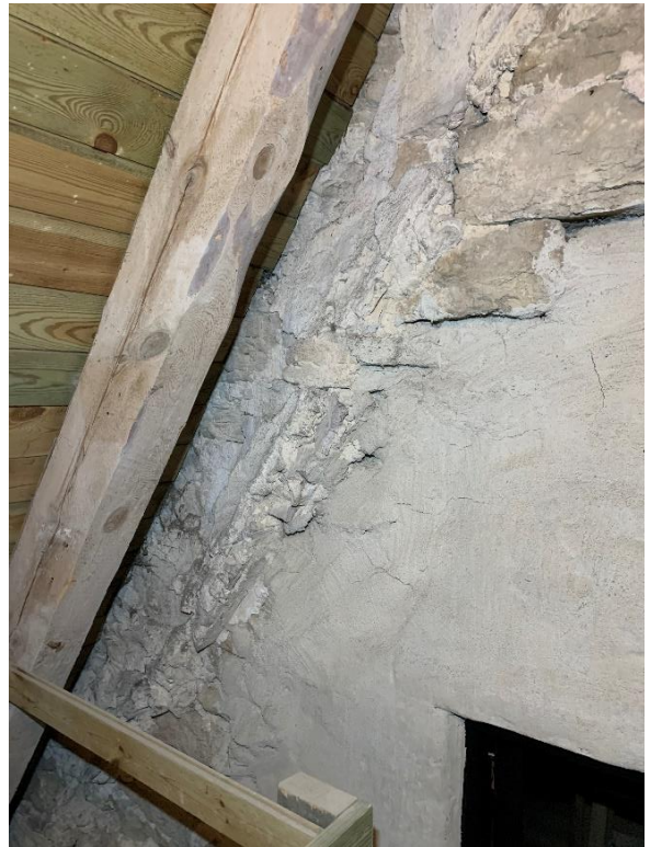
Korvinden mot väster. Till höger spår av kortakets lägre takvinkel före 1900-02. Foto JL 2022.
