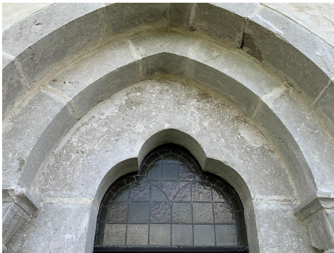
Långhusets nordportal, detalj av tympanon med avtryck av mer rundbågiga arkivolter innan portalen flyttades från långhusets södra sida till den norra när nuvarande sydportal tillkom. Foto JL 2022.
