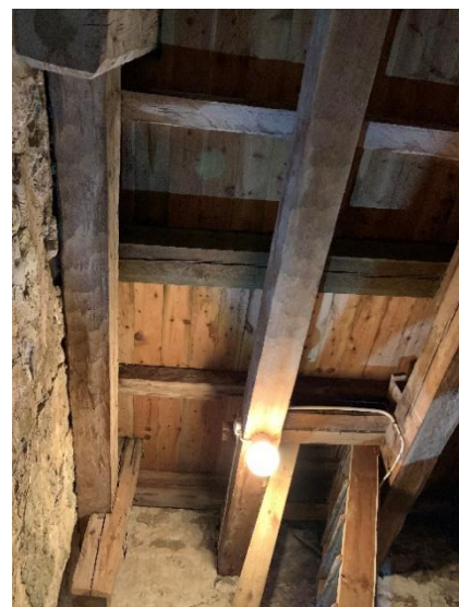
Tornets första övervåning. Nordöstra hörnet med tornets murverk, ställt på det äldre långhusets murade gavelröste med en avhuggen bjälke. Till höger blick uppåt mot öster. Foto JL 2022.
