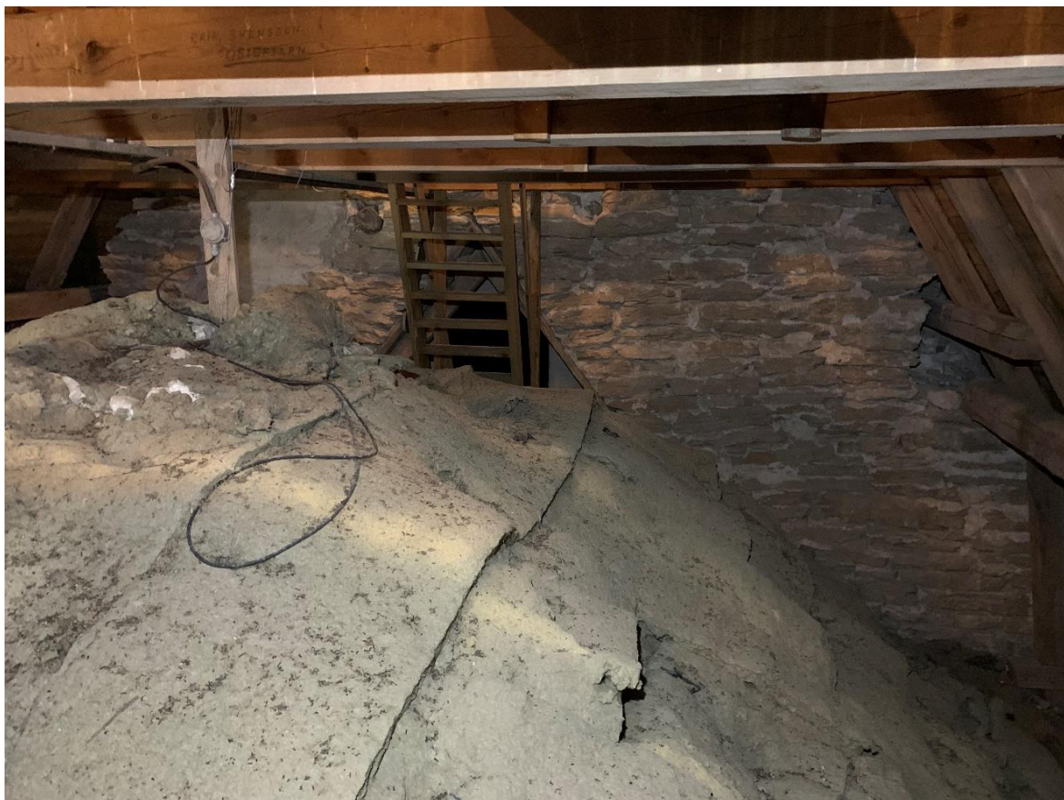
Långhusvinden mot öster med valvets ovansida och öppning mot korvinden. Foto JL 2022.
