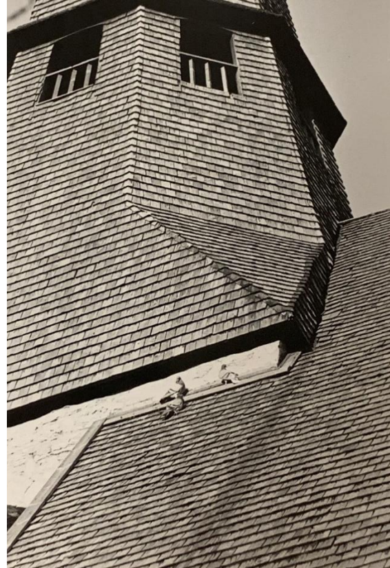
Tornet med fuktangripna cementfogar samt detalj av tornhuvens och långhustakets spånklädsel mellan 1900-02 och 1973-75. Foto Lennart Garmfors (?), Restaureringsteknik AB, 1971, Gotlands Museums arkiv (GFF897_113).
