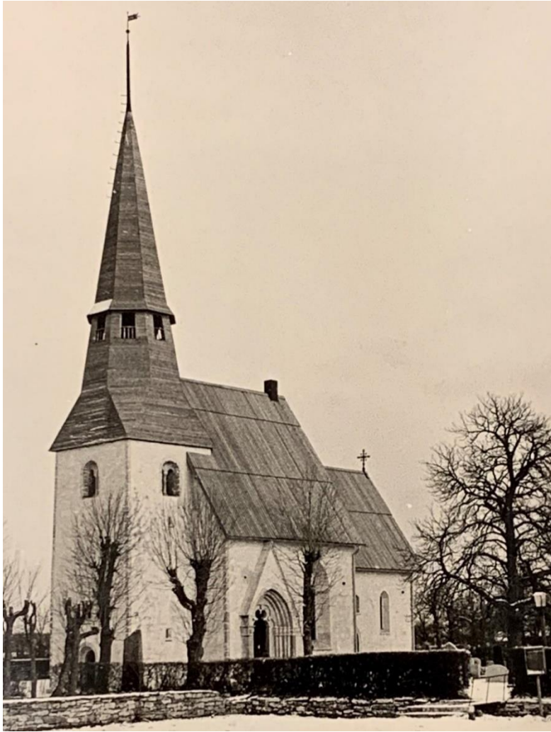
Exteriör från sydväst efter yttre restaureringen 1973-75. Fasaderna har putsats och spåntaken ersatts av faltak och tornpanel. Foto Gunnar Svahnström 1975, Gotlands Museums arkiv (GFF897_34).
