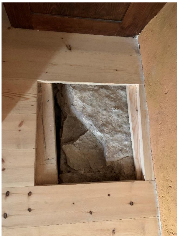
Lucka i golvet med mur, sannolikt visande den norra murens ursprungliga tjocklek. Till höger tornstegens passage genom ringkammarens valv. Foto JL 2022.
