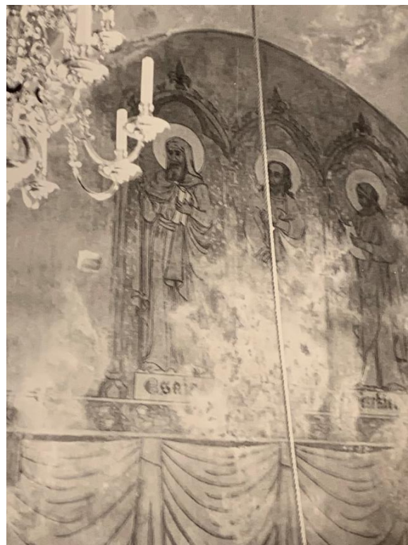
Till höger ringkammaren mot sydväst med målningar från 1900-02, delvis nymålade 1981. Foto JL 2022. Till höger ringkammarens södra mur med fuktgenomslag som visar läget för den på insidan igenmurade nedersta ljusgluggen på tornet sydfasad och som visar dess låga placering. Foto Lennart Garmfors (?), Restaureringsteknik AB, 1971, Gotlands Museums arkiv (GFF897_104).
