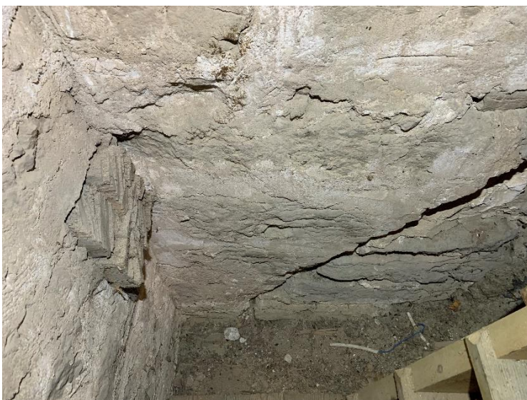
Tornets första övervåning. Nordöstra hörnet med tornets murverk, ställt på det äldre långhusets murade gavelröste med en avhuggen bjälke. Till höger blick uppåt mot öster. Foto JL 2022.
