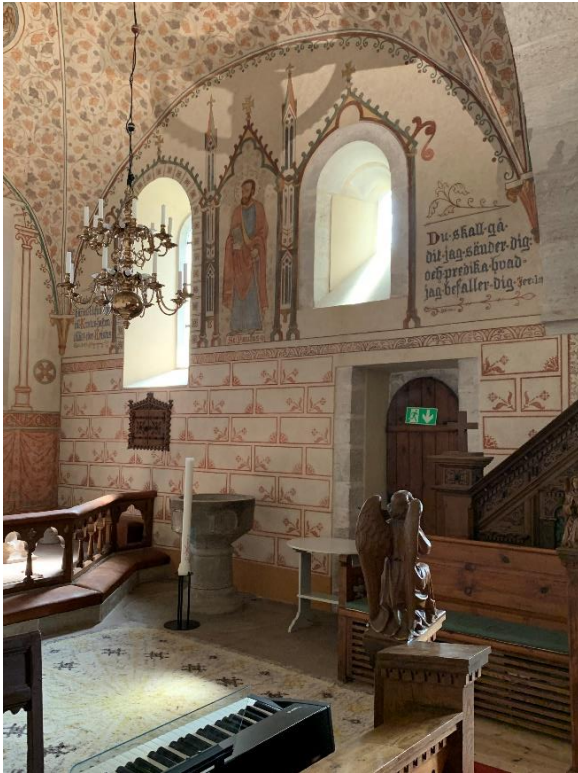
Korets södra mur. Till höger korets västra fönster, sammansatt av bågkrön från fönster i den äldsta kyrkan, möjligen från olika fönsteromfattningar. Foto JL 2022.
