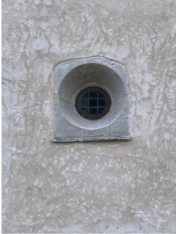
Rundfönster i tornets västfasad, till höger i släpljus som genom skuggan visar att stenarna är rundade, vilket talar för att fönstret tidigare har suttit i den äldre kyrkobyggnadens absid. Foto JL 2022 respektive 2018.
