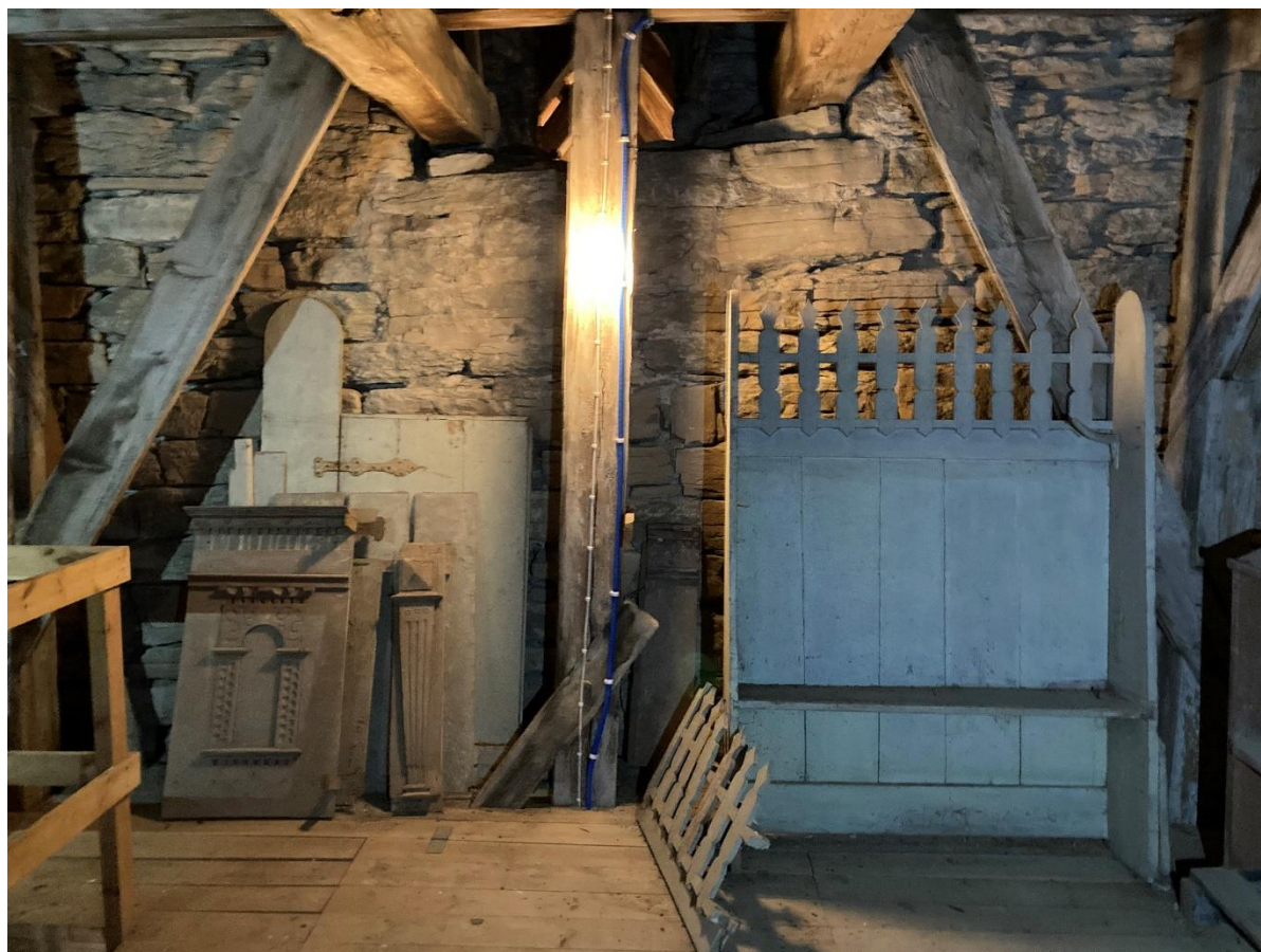
Tornets andra övervåning mot öster med nedre delen av öppning in mot långhusvinden samt äldre inredningsdetaljer. Foto JL 2024.
