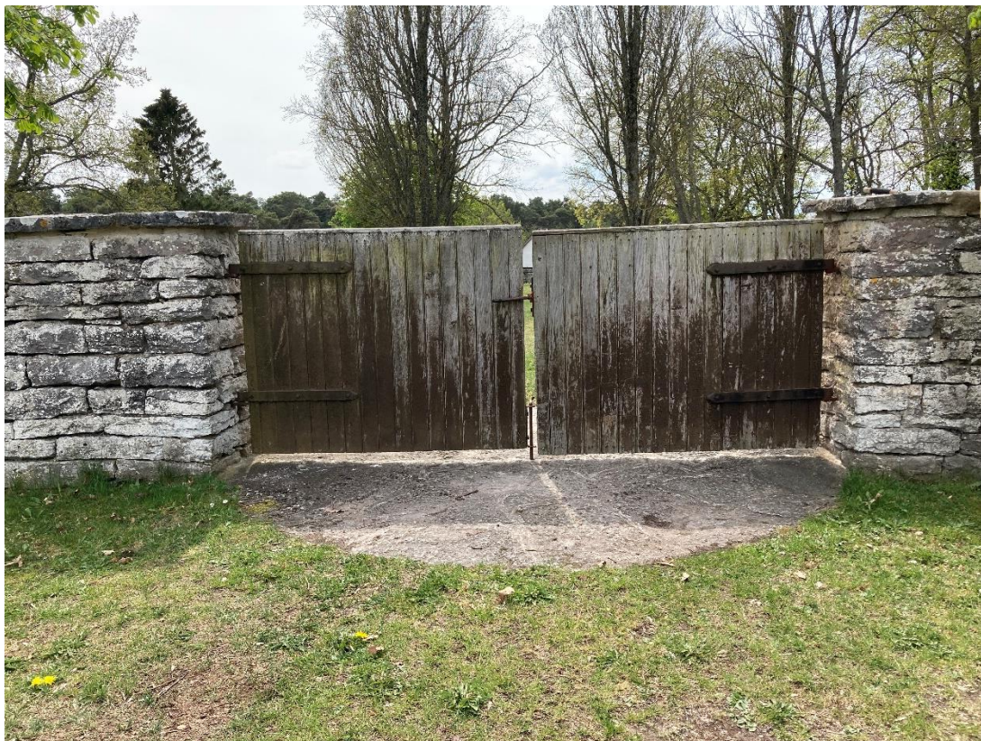
Ingång med trägrindar i den norra mursträckningen. Foto ES 2023.
