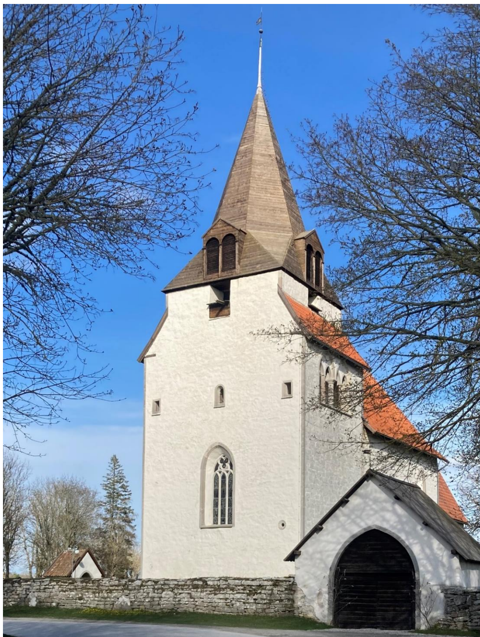
Exteriör från sydväst. Foto JL 2023.
