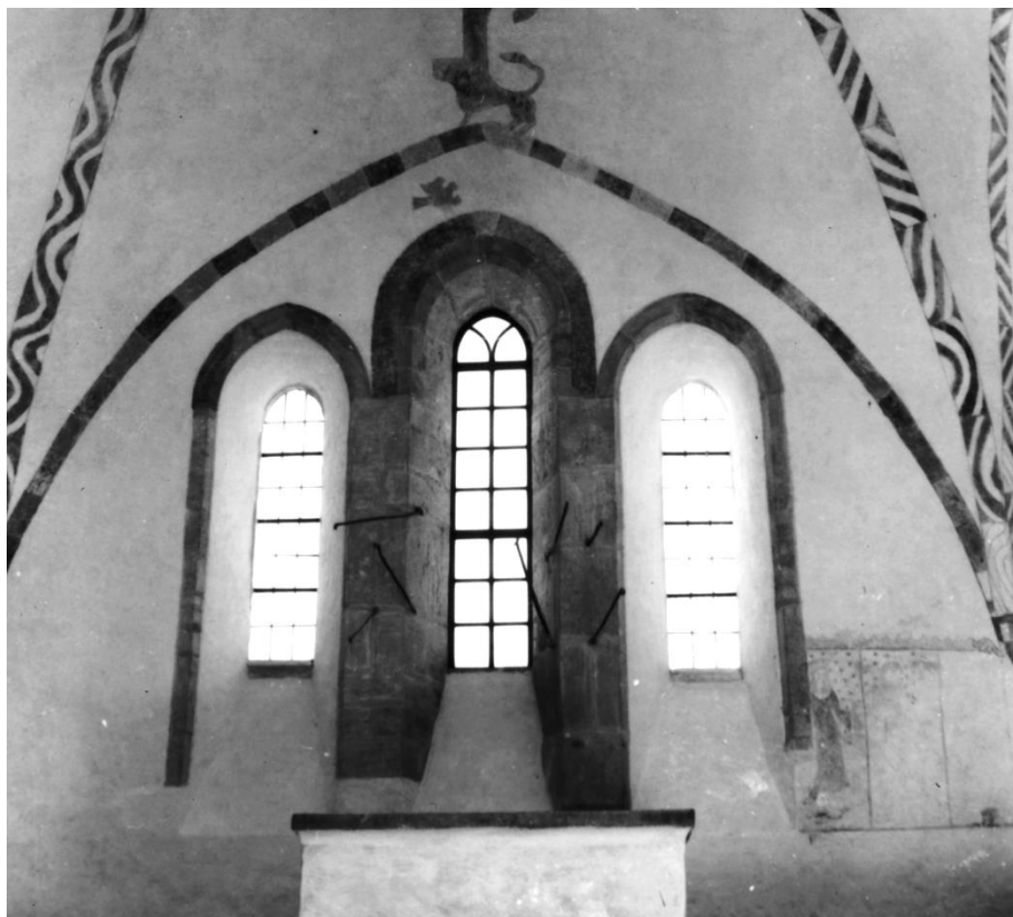
Östfönstren frilagda under restaurering. Skillnaden mellan mittfönstrets stenklädda smyg och de andras putsade framträder. Foto troligen Erik Olsson, Sanda, 1953, ATA.
