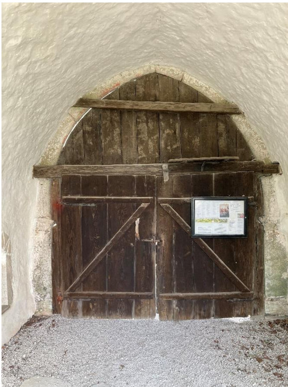
Den västra stigluckans inre fotograferad från öster. Portblad och portalomfattning. Foto ES 2023.
