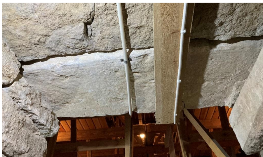
Taket över passagen mellan torn och långhusvind med infogad del av bildsten. Foto JL 2024.
