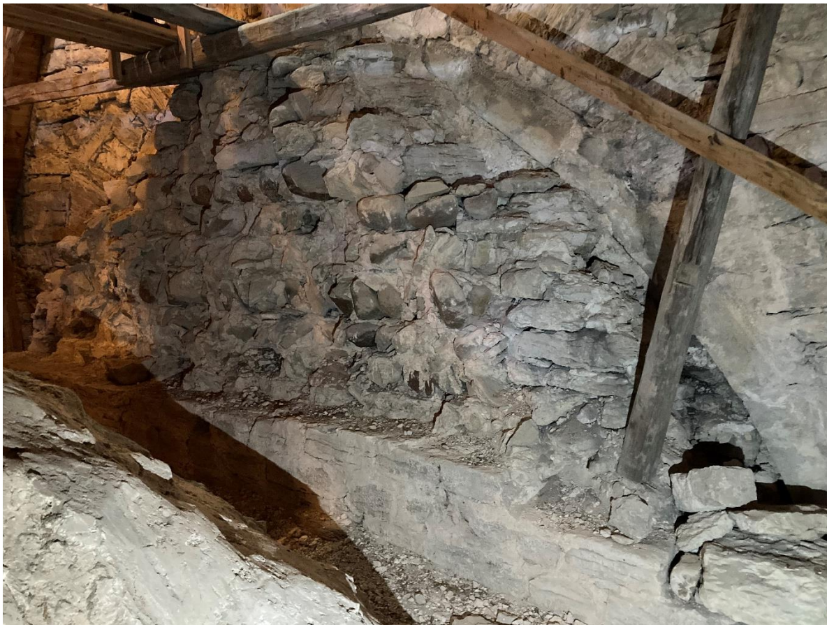
Fyllnadsmur i triumfbågsmuren mot korvinden, sedd från nordöst. Foto JL 2024.
