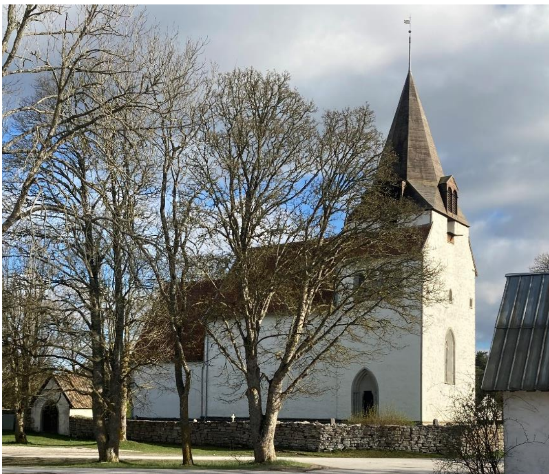
Exteriör från nordväst. Foto JL 2023.
