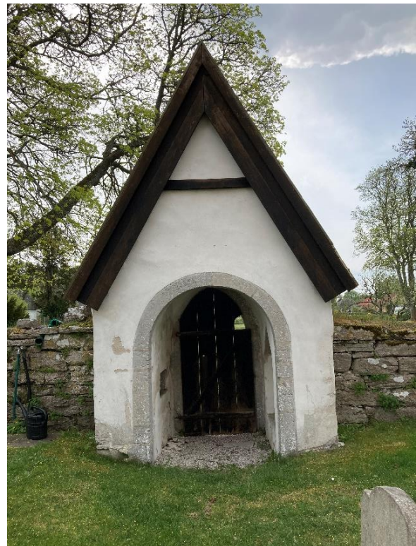
Den södra stigluckan fotograferad från norr. Foto ES 2023.
