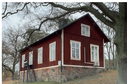
Skolan före renovering
