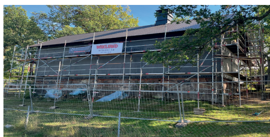
Renovering i full gång
