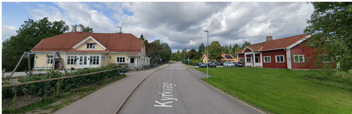
Sjövillan och Västanfors sockenstuga
