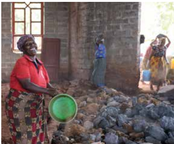
Kyrkan i Kiwalaa har blivit för liten och vi fick vara med en dag för att bokstavligen bygga golvet. Vi bar tillsammans sten och sand.
