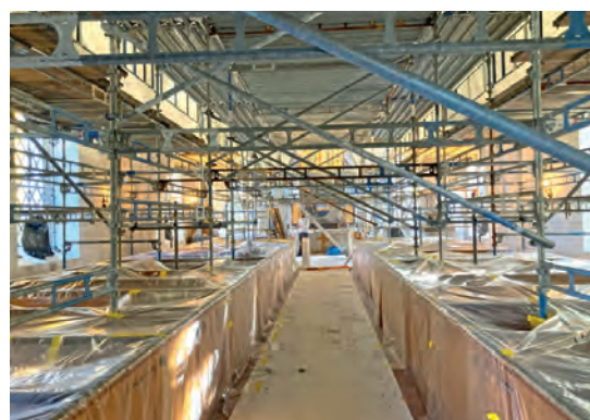
En ny maskinhall uppförs i Välluv och i Frillestads kyrka pågår en invändig renovering.
