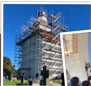
Åskskyddet byts ut i Skummeslövs kyrka.
