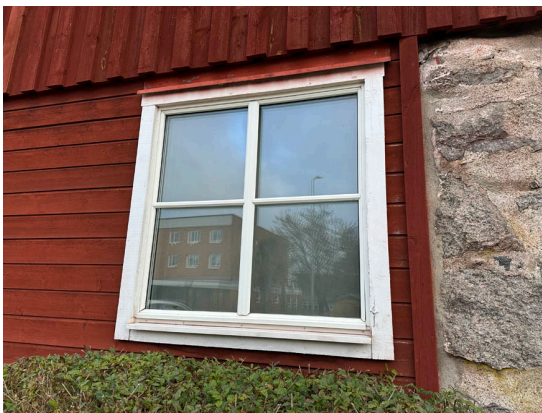
Aluminiumklätt fönster med lösa spröjsar på ekonomibyggnaden väster om kyrkan, på dess gavel mot bygatan.
