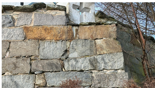
Borttrillat fogbruk i kallmuren vid Hammars gravplats.
