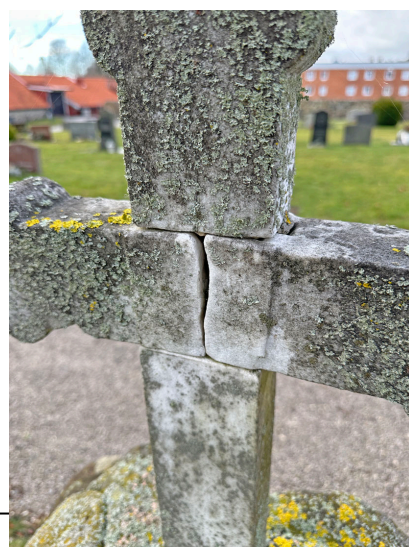
Vänster: Vård av marmor på Björktrasten BC 3, alger/lavar. Ovan: Platta av marmor på Ringtrasten BC 146-148, alger/lavar. Höger: Trasigt krönkors, av marmor Björktrasten (utan gravnr)
