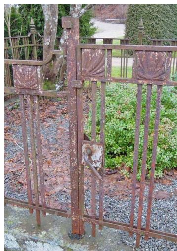
Järnstaketet på trädgården DF 19-22 har kraftiga rostangrepp. Åtgärder bör prioriteras innan skadorna eskalerar. Staketet bör rengöras, lagas, rostskydds- och underhållsmålas med linoljefärg.
