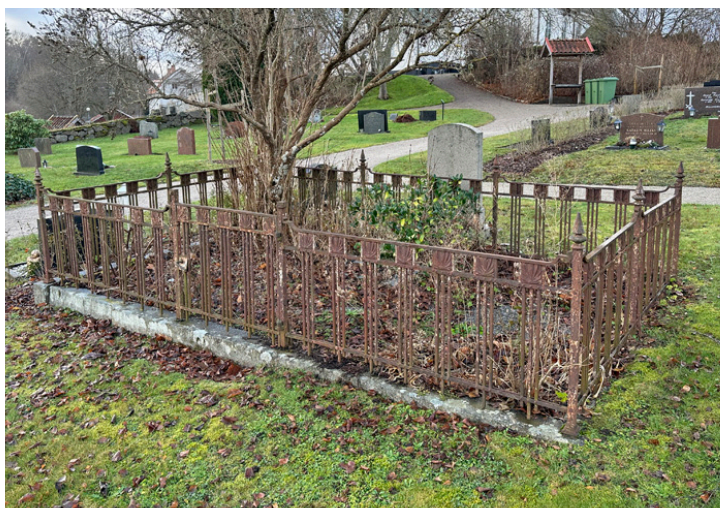
Järnstaketet på trädgården DF 19-22 har kraftiga rostangrepp. Åtgärder bör prioriteras innan skadorna eskalerar. Staketet bör rengöras, lagas, rostskydds- och underhållsmålas med linoljefärg.
