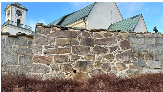
Mursträcka som förefaller ålderdomlig med hög andel obearbetade naturstenar och rik skolning.
