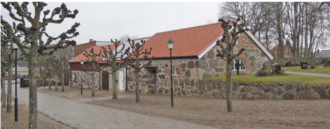
Gravkapell och ekonomibygnad med stenfasader samt mellanliggande garagedel med putsad fasad.
