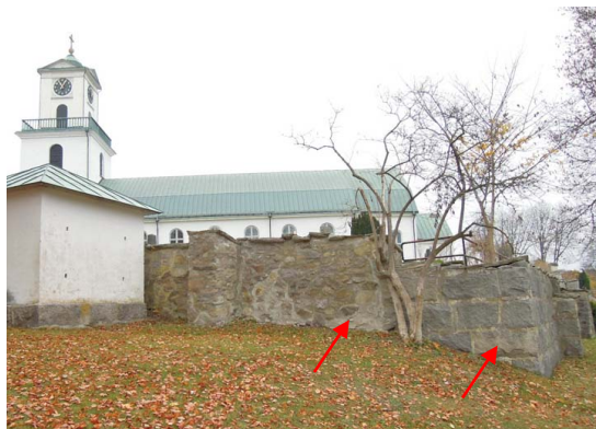
Muren i sydöst har olika karaktär.
