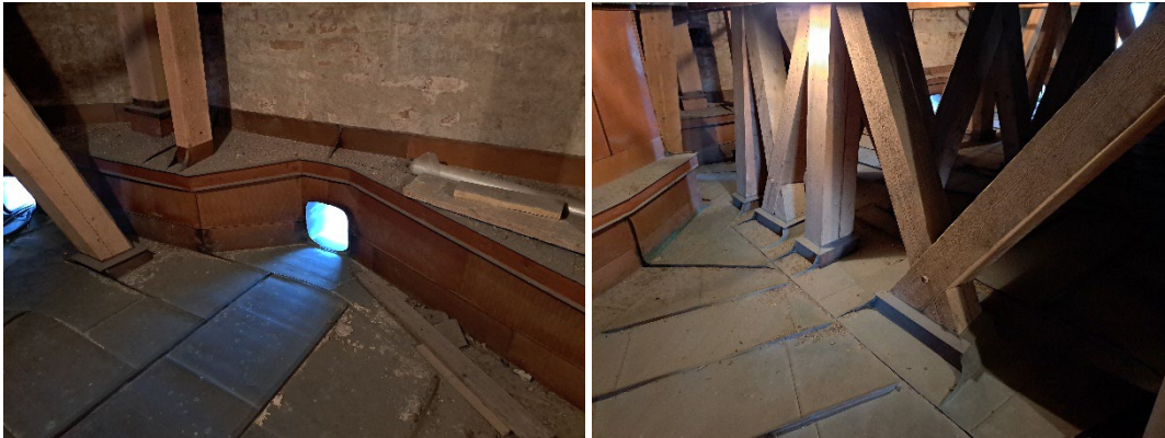
Figur 74 Invändigt falsat plåttak på ett våningsplan i kyrktornet som förhindrar vatten från att tränga ned i byggnaden. Foto: Magnus Arvidson, RISE.
