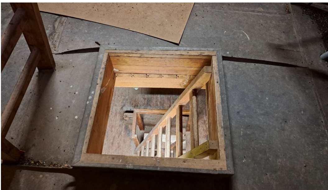
Figur 76 Invändigt tätskikt av falsad stålplåt som troligen byggts för avledning av regnvatten i ett kyrktorn. Öppningen har en lucka med motsvarande tätskikt. Kyrkan har ett traditionellt sprinklersystem. Foto: Magnus Arvidson, RISE.
