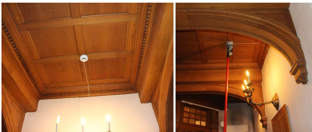
Figur 81 Rökdetektor i en större kyrka och provning från golvnivå av denna detektor med utrustning som imiterar brandrök. Foto: Magnus Arvidson, RISE.
