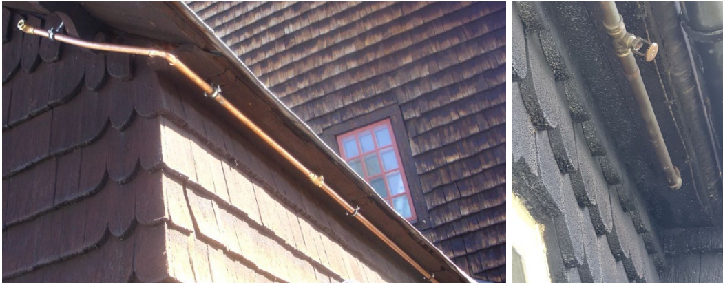
Figur 50 Till vänster: Ett sprinklersystem med öppna sprinklerrör (dock ej installerade när fotot togs) för att vattenbegjuta en ytterfasad på en träkyrka. Sprinklersystemet aktiveras sektionsvis och automatiskt via en signal från en värmedetekteringskabel installerad under takfoten. Sprinklerrörerna är tillverkade av koppar och fotot är taget kort tid efter installationen. Till höger: I utomhusmiljö sker en oxidation av koppar, varvid det med tiden bildas ett mörkbrunt skikt på metallens yta som gör röret mindre synligt. Viktigt att notera är att kopparrör är känsliga för tak- eller fasadtjära och kan förstöras vid omtjärning. Det här innebär att rören behöver skyddas vid omtjärning. Foto: Magnus Arvidson, RISE och Tomas Godby, Brandskyddsbesiktning T Godby AB.
