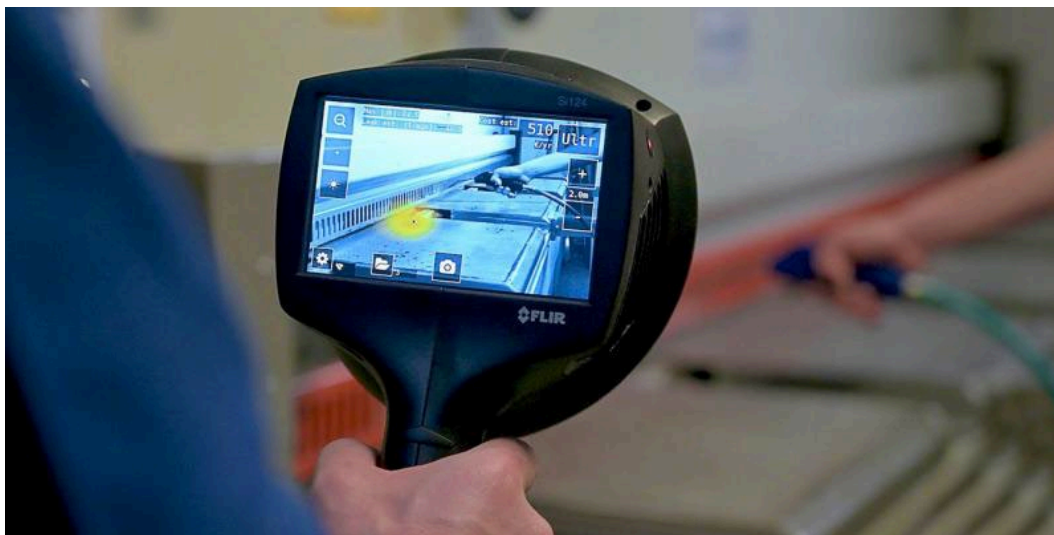
Figur 80 Läckagesökning i rörsystem med tryckluft eller andra gaser med kamera som gör det möjligt att detektera och snabbt lokalisera läckage. Foto från Elma Instruments AB. Det finns flera andra liknande kommersiella produkter på marknaden.
