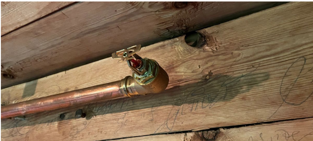
Figur 47 Installation med kopparrör i ett biutrymme i en kyrka som visar hur rör av koppar kan bockas. Sprinklern är försedd med en skyddskorg och texten på röret säger: "OBS. INGET FÅR HÄNGAS PÅ RÖRET...". Foto: Magnus Arvidson, RISE.
