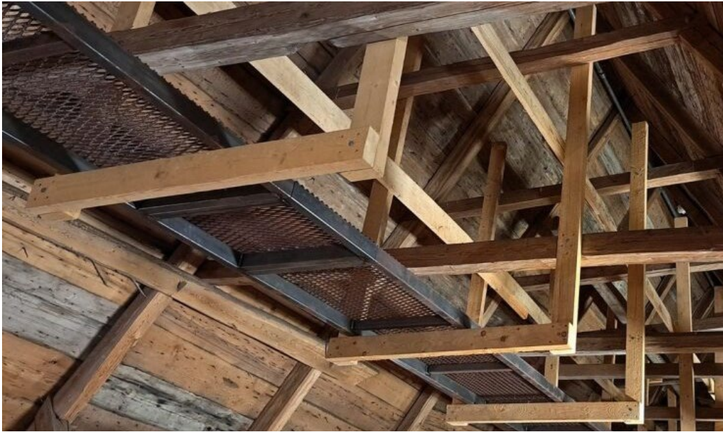
Figur 71 Exempel på gångbrygga under taknocken som är tillverkad av obrännbar gallerdurk som är vattengenomsläpplig. Gångbryggan har ordentliga räcken. Foto: Magnus Arvidson, RISE.
