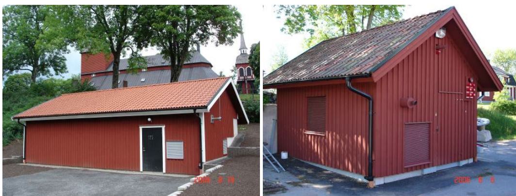
Figur 7 Två exempel på teknikbyggnader som innehåller både sprinklerpumpar, reservkraftaggregat och vattentank. Foto: Magnus Arvidson, RISE.
