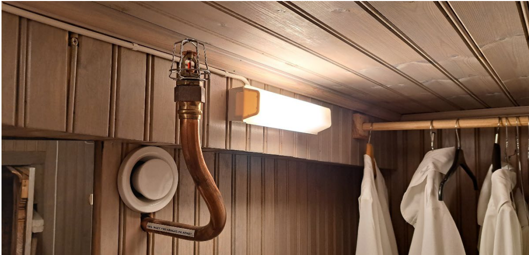
Figur 47 Installation med kopparrör i ett biutrymme i en kyrka som visar hur rör av koppar kan bockas. Sprinklern är försedd med en skyddskorg och texten på röret säger: "OBS. INGET FÅR HÄNGAS PÅ RÖRET...". Foto: Magnus Arvidson, RISE.
