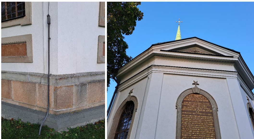
Figur 94 Nedledare på en kyrka. Foto: Magnus Arvidson, RISE.
