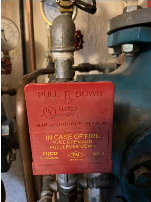
Figur 55 Nödaktiveringsventil på larmventil i ett pre-actionsystem i en större stadskyrka. Dock endast märkt med text på engelska. Foto: Emil Egeltoft, Brandskyddslaget AB.
