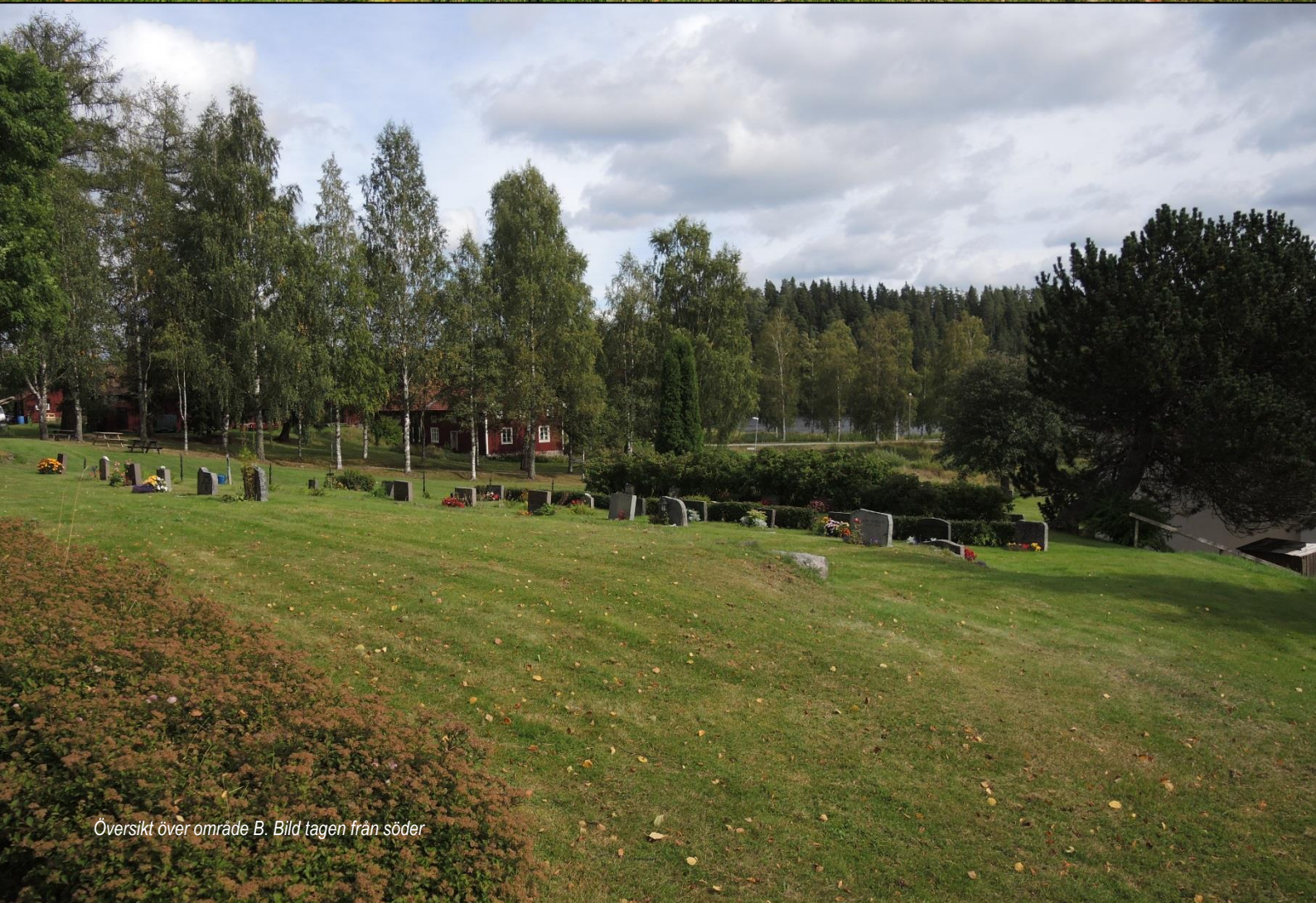
Stödmur i område B, uppförd under 1950-talet av stenhuggaren Axel Wall från Söderbärke
