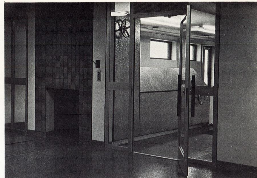
Från införingsrummet skymtar man incineratorn som är av Tabos välkända fabrikat.
