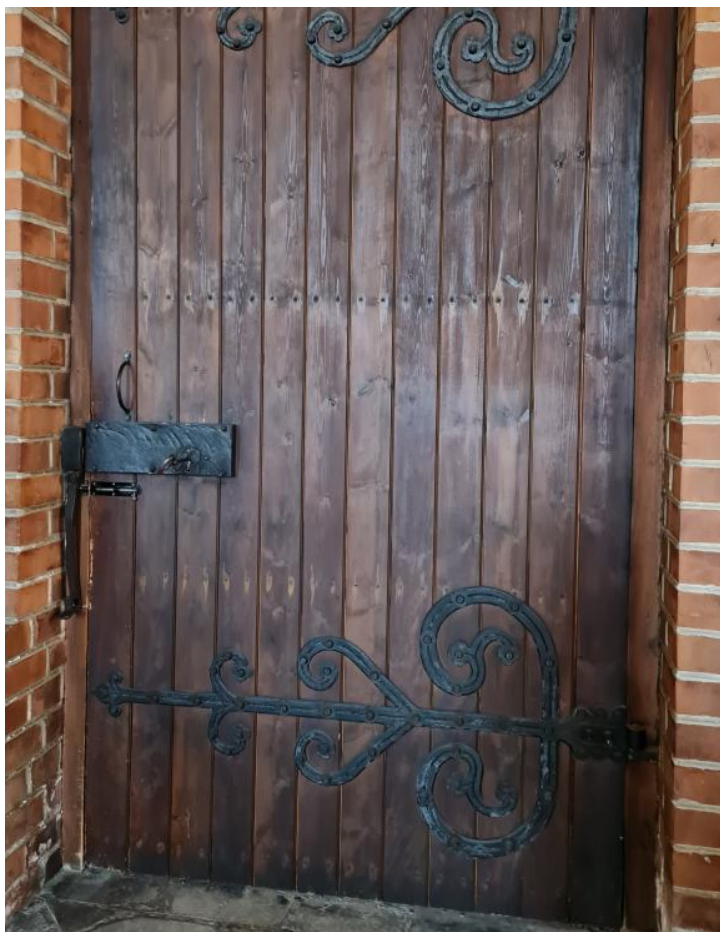
Figur 29. Beslagning av inåtgående dörrar för utrymning.
