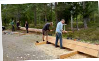
Timmermännen från Traditionsbärarna renoverar taknocken på Skaga stavkyrka.
