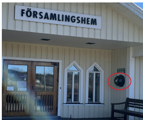
Vi har installerat en hjärtstartare på församlingshemmet i Rävlanda.
