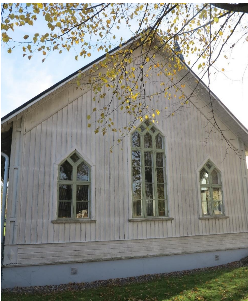
Västgaveln med konstruktionen avtecknad i nedsmutsningen av ytskiktet. Fönstrens form framträder utan skymmande vegetation. Foto Pär Malmros 2014, Gotlands Museum.
