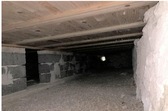
Inspektionsslucka till grunden, i sockenmuren mitt på nordfasaden, samt krypgrundens norra del mot väster. Foto JL 2020.
