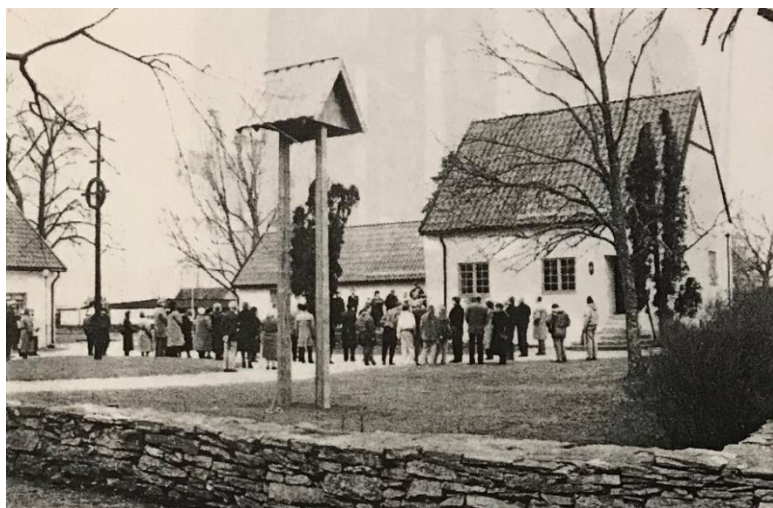
Exteriör från invigningen av klockstapeln 26/3 1991. I förgrunden klockstapeln i sin ursprungliga form utan snedsträvor. GT 26/3 1991, GMA. T.h. klockstapeln efter strävornas tillkomst. Foto Danne Pe Pettersson 1997, Visby stift.
