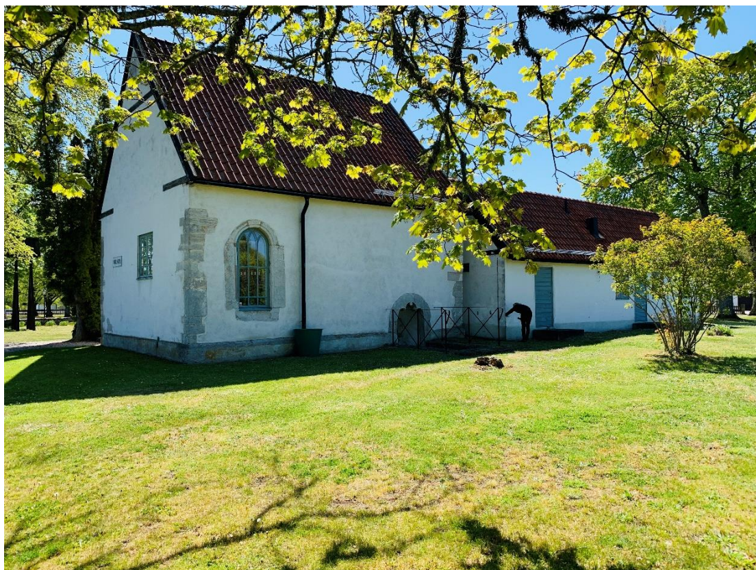
Exteriör från nordväst. Foto JL 2020.
