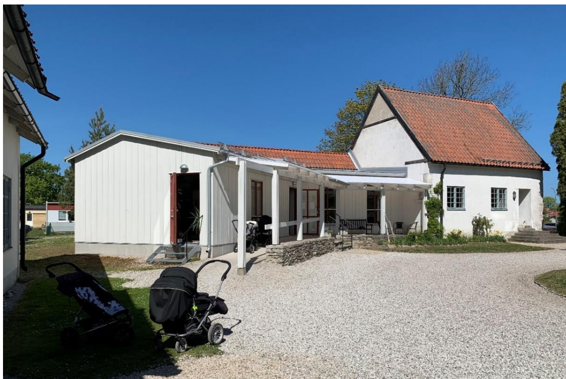
Exteriör från sydöst av kapellet och flygeln. Foto JL 2020.
