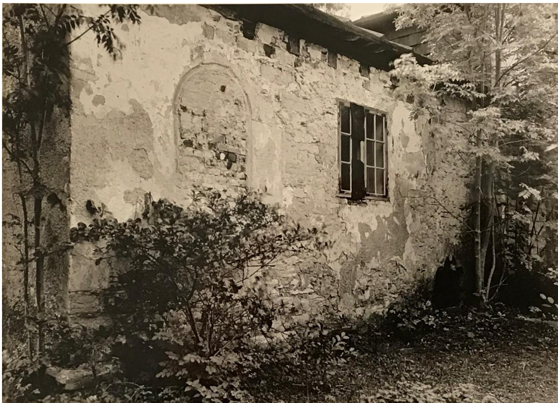
Stensalen, nuvarande kapellet, västfasaden från nordväst. Foto Alfred Edle 1922, GMA. I förgrunden det nuvarande rundbågiga fönstret vars öppning i Säves teckning 1868 utgjorde ingång till salen. Bakom rönnen (?) till höger skymtar källaringången med den profilerade omfattningen.
