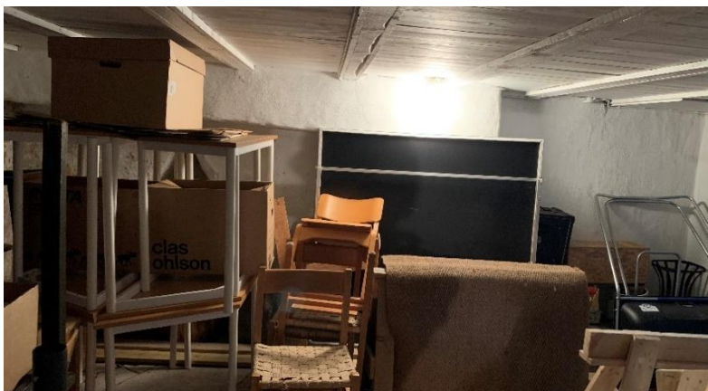
Källarens större, yttre rum, mot söder. Den källartrappa som på uppmätningen från före branden 1943 mynnade i väggens högra del är igensatt. Foto JL 2020.
