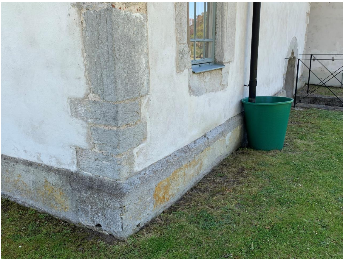
Sockeln i nordvästra hörnet. Foto JL 2020.
