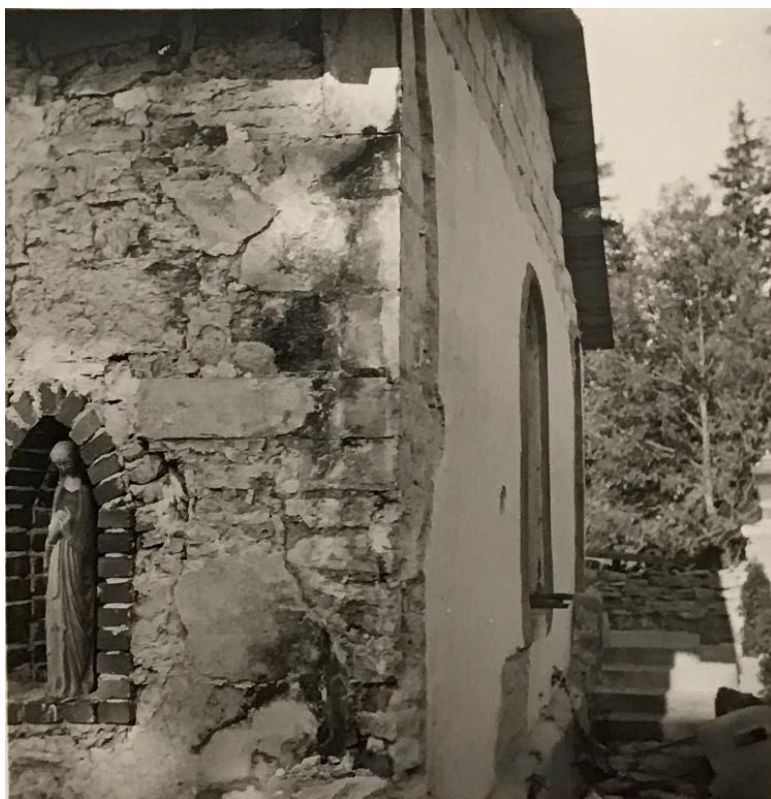
Sydöstra hörnet och blick längs med den östra fasaden, i oktober 1943, efter att byggnaden satts under tak. Nischen i sydfasaden till vänster har ersatt den tidigare rakspetsiga nischen på samma ställe. Foto Gunnar Svahnström 1943, GMA.
