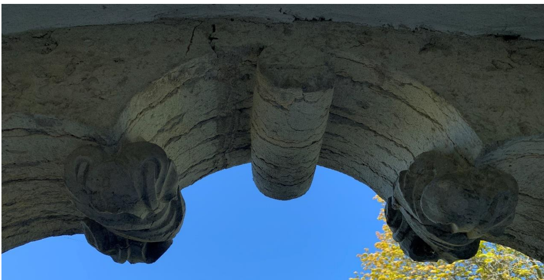
Källarportalens bågkrön, sett inifrån. Foto JL 2020.
