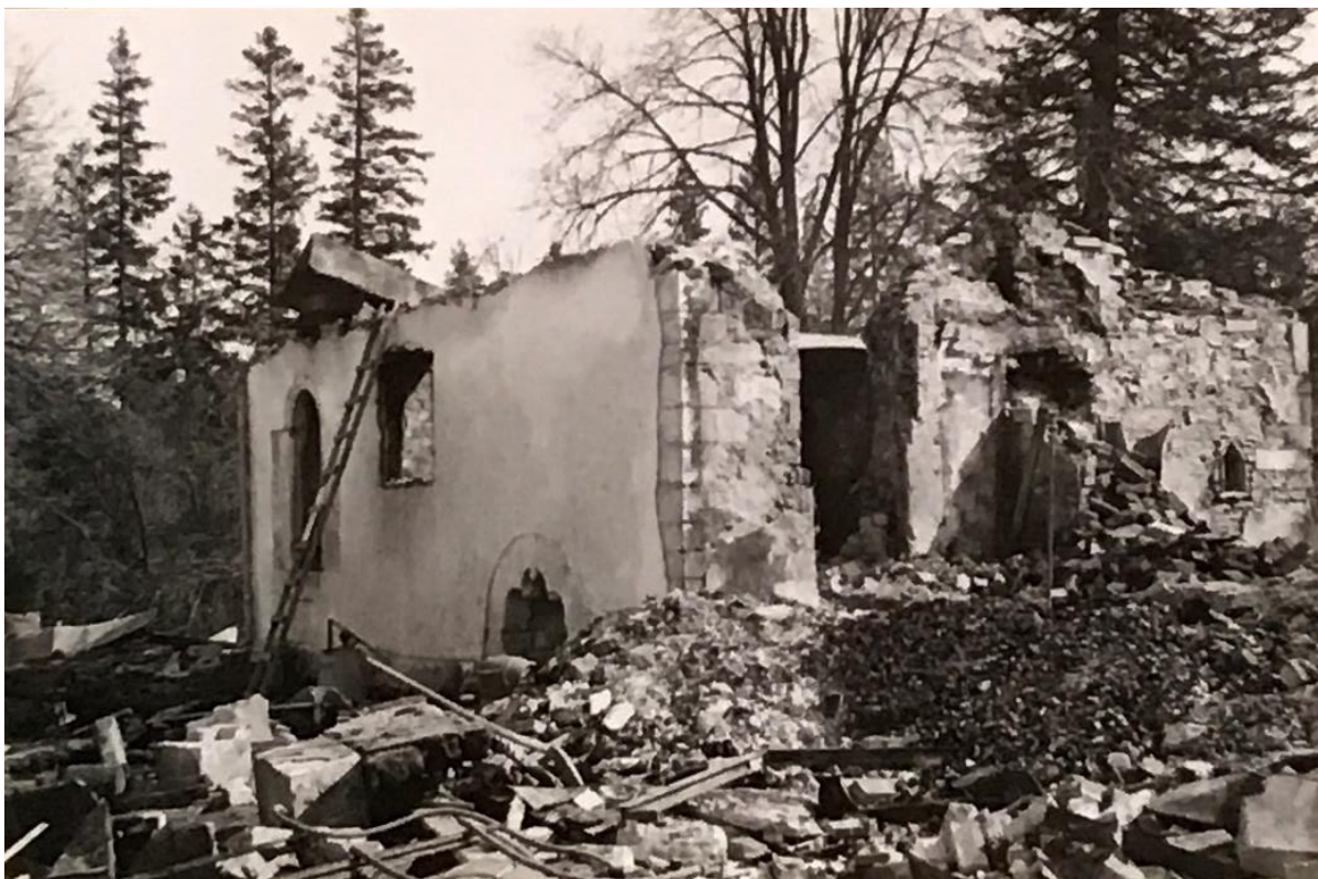
Exteriör från sydväst efter branden. Foto Gunnar Svahnström 1943, GMA (980-234). De medeltida omfattningarna berördes inte av branden. Putsen tillkommen efter foton 1939.
