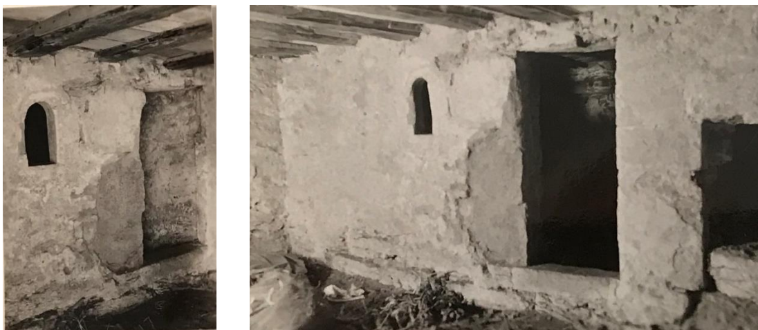
Interiör av källarens stora rum mot nordöst och nordväst med ingång och glugg till den lilla cellen i norr. Foto före branden troligen Gunnar Svahnström 1939, GMA.
