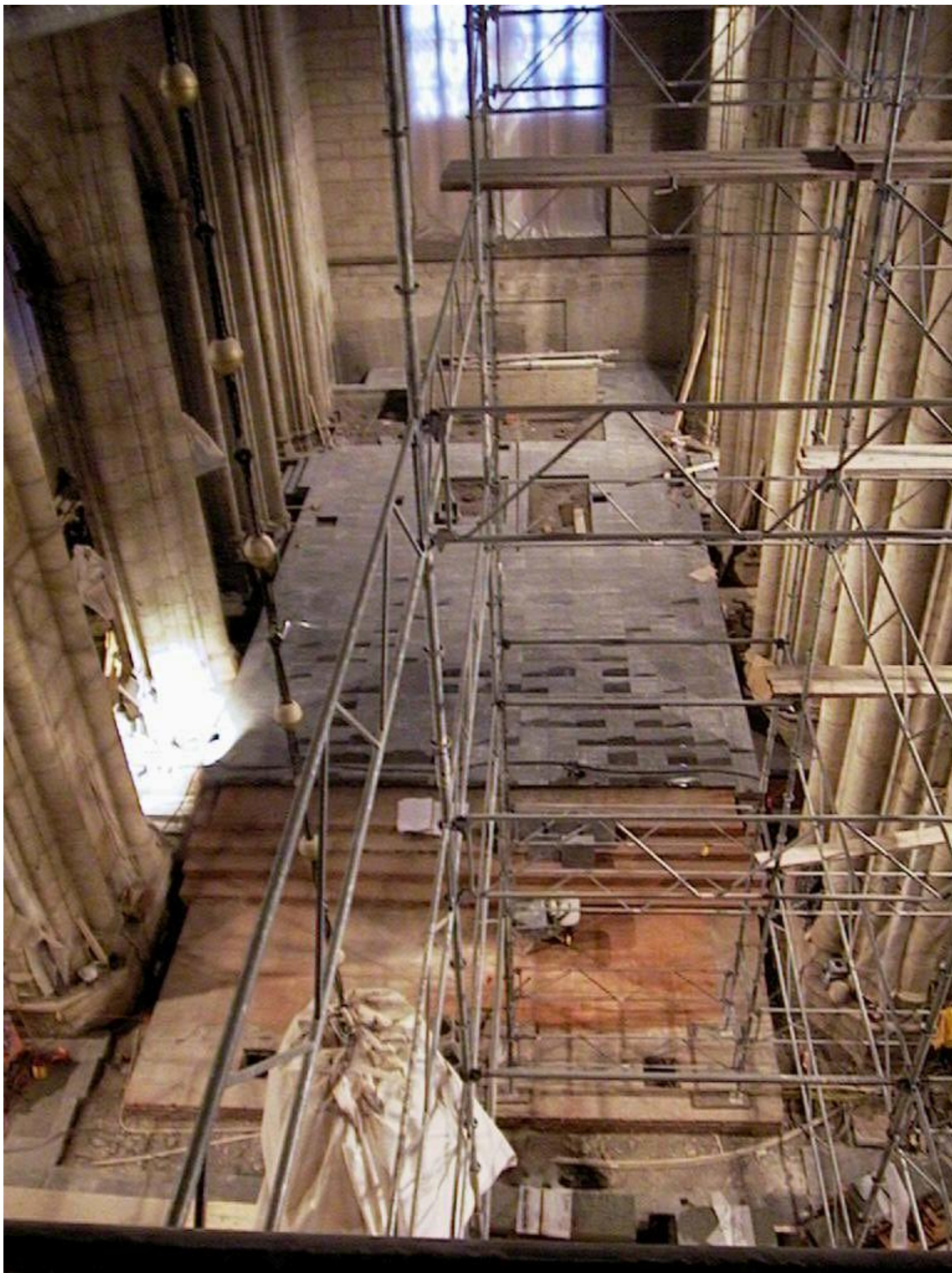
Så såg vyn mot högkoret ut under renoveringen i Skara domkyrka. Foto: NCC
