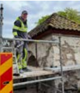
Här har taket kommit på plats på stigporten i Vallda. Restaureringen står Frillesås mur och puts för.
