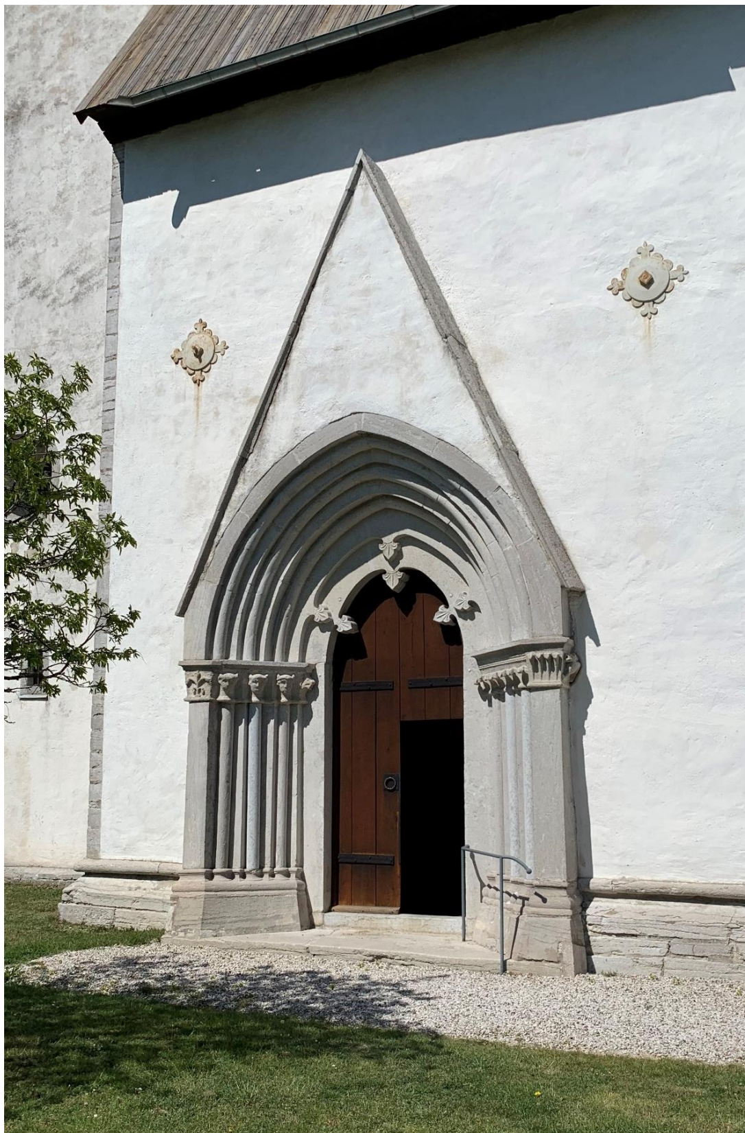
Långhusets sydportal, 1300-talets förra hälft. Gångöppningen är en av de vidaste på Gotland. Foto JL 2020.
