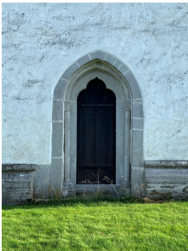
Nordportalen, med delar troligen från den tidigare västportalen i tornet. Foto JL 2019.
