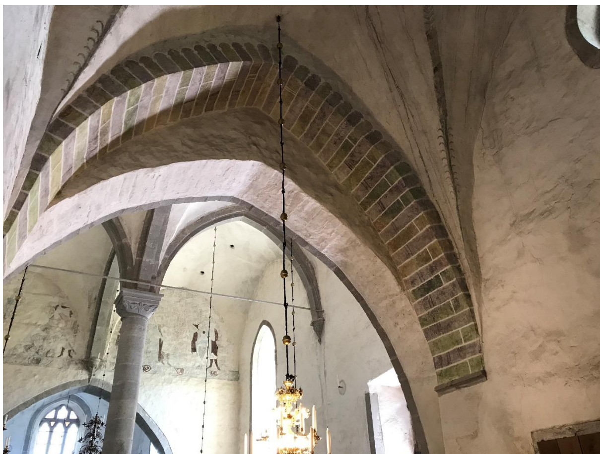
Till vänster: Tornets valv, inslaget vid en ombyggnad av tornet omkring 1200-talets mitt, sett underifrån mot sydöst. Nedan: Tornbågen, sedd underifrån mot sydöst. Den hitre, kvaderstensmålade delen av bågen är samtida med tornvalvet och avpassad för att öppna sig mot det tidigare, romanska långhuset, på motsvarande sätt som i Eskelhem och Mästerby. Den bortre, vitputsade bågen, är samtida med det nuvarande långhuset från 1300-talet, och placerad lägre av hänsyn till långhusvalvens konsol på andra sidan. Foto JL 2020.
