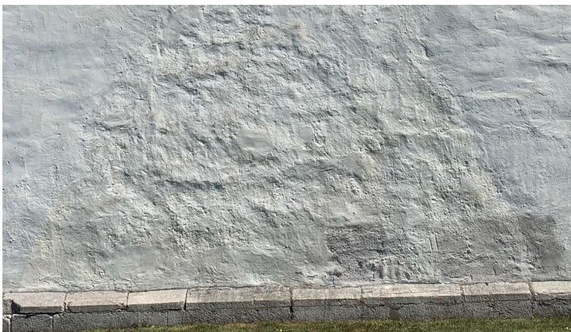
Tornets västfasad med frilagd medeltida putsyta visande ritning till bågarna i långhusets sydportal. Ristad i den nyslagna putsen på platsen för tornets samtidigt igensatta västportal. Foto JL 2020.
