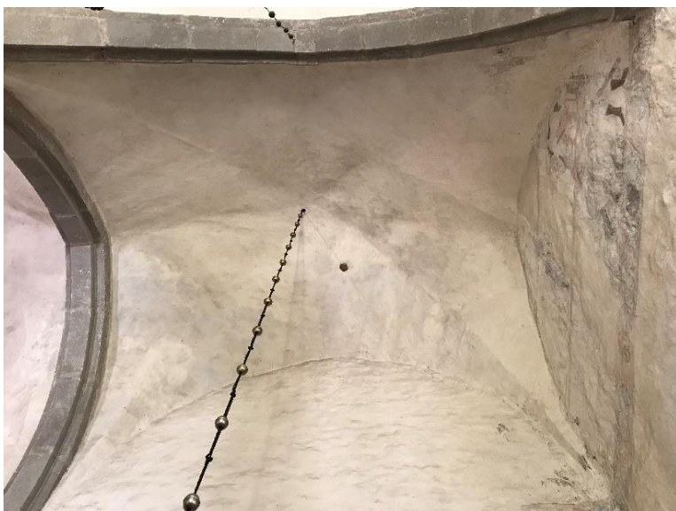
Långhusets nordöstra valv med hål, sannolikt för akustikförstärkande så kallad ljudkruka. Foto JL 2020.
