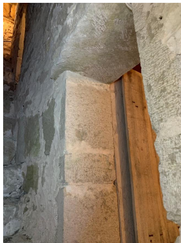
Ingång till tornets första övervåning. Golvet höjt vid valvbygget. Till höger den välhuggna omfattningens övre del. Längre upp i trappan en liknande ingång till nästa våning.
