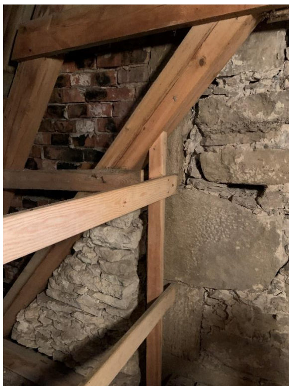
Långhusvindens sydvästra hörn med tornets hörnkedja murad med stora block, 1860-talets murverk med kalksten i litet format och 1958-59 års påmurning med återanvänt tegel från den rivna skorstenen. Foto Lisa Johansson 2020, Gotlands Museum. Till höger nisch i gavelmuren i långhusets nordöstra hörn. Foto JL 2020.
