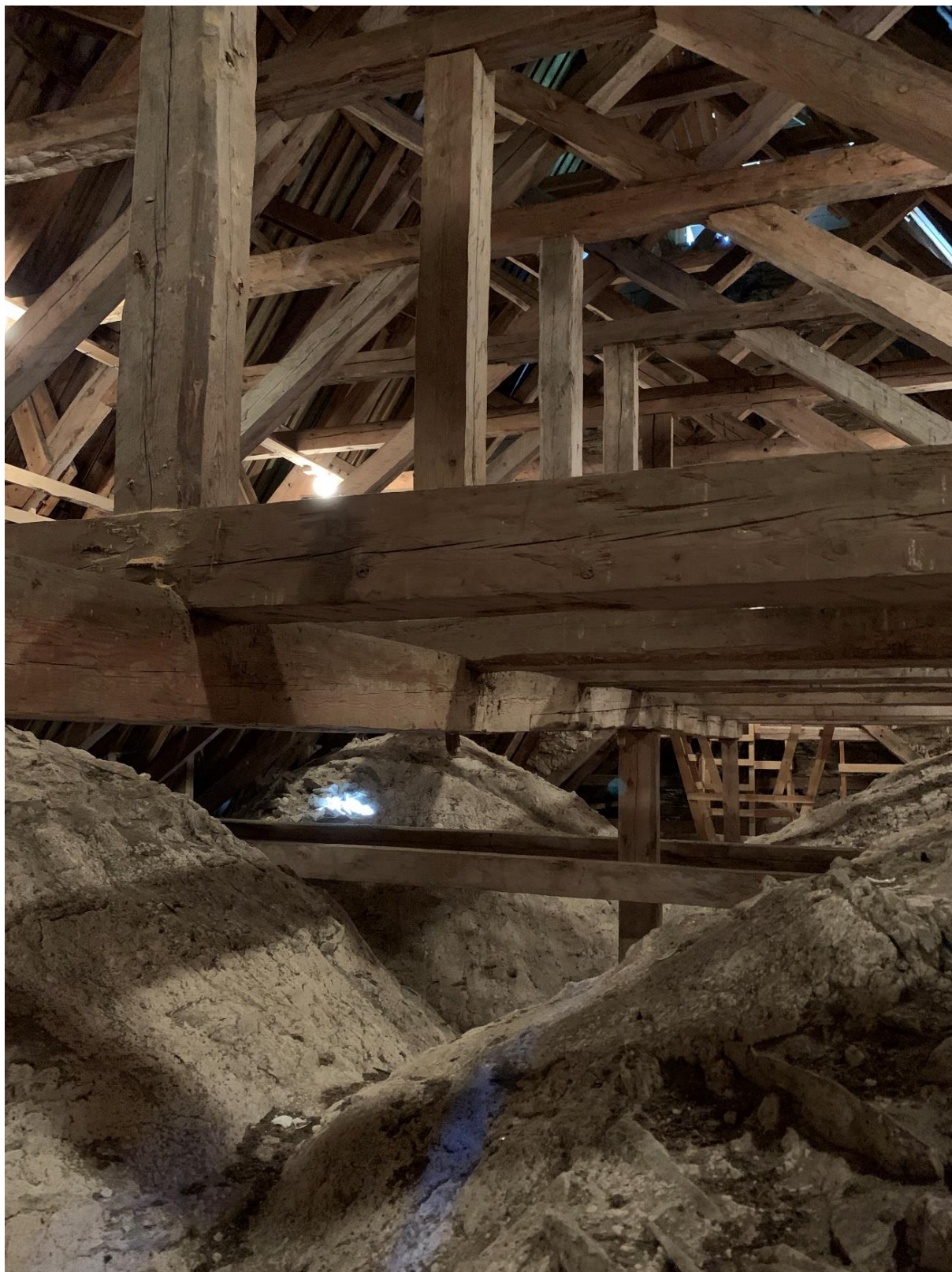
Långhusvalvens ovansida och långhusets takstol mot öster. Foto Lisa Johansson 2020, Gotlands museum.
