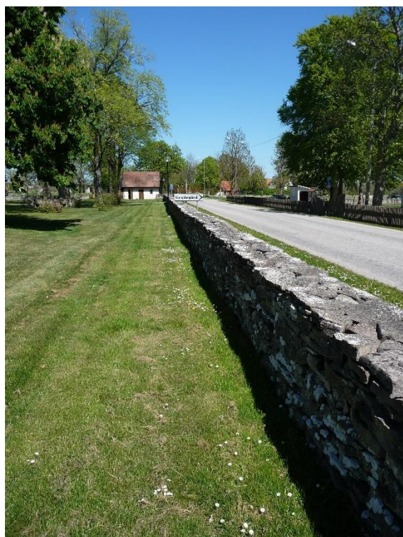
Muren mot landsvägen i öster. Foto ES 2020.
