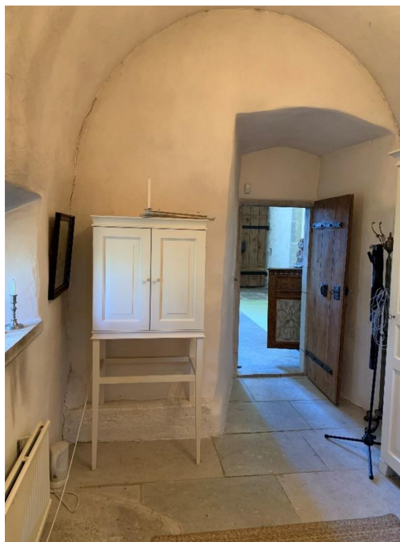
Interiör av sakristian mot norr och söder. Fönstret mot norr från 1958-59 på platsen för ett större spetsbågigt fönster från sakristians byggnadstid på 1880-talet, sattes igen vid tillbyggnaden 1998. Det murade tunnvalvet ersatte ett träinnertak 1958-59. Skåpinredning från 2012. Foto JL 2020.
