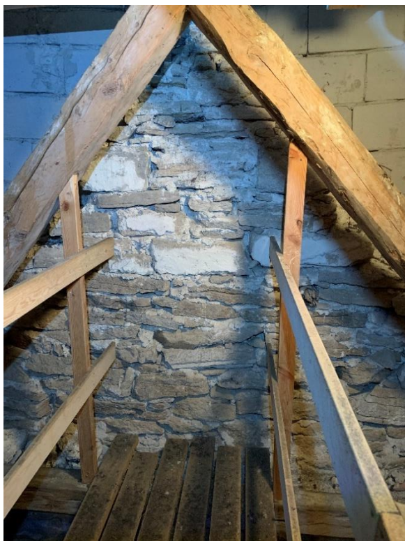
Korets östra gavelmur. Röstets spets i 1860-talets lägre takfall, sannolikt ommurat vid taksänkningen med sten med äldre fasadputs samt arkitekturfragment, troligen från någon av gavelrösternas gluggar. Foto JL 2020.
