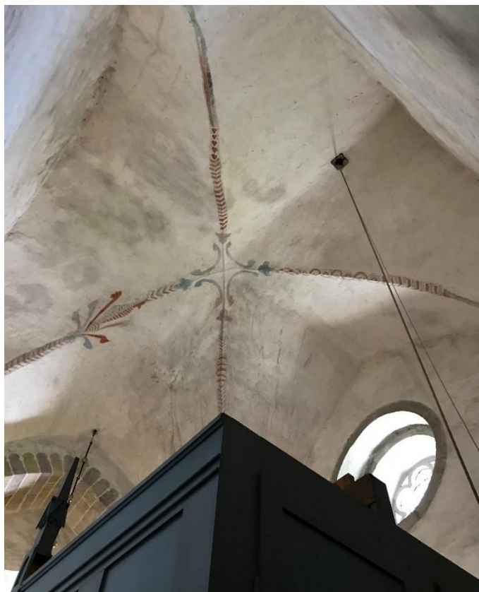
Till vänster: Tornets valv, inslaget vid en ombyggnad av tornet omkring 1200-talets mitt, sett underifrån mot sydöst. Nedan: Tornbågen, sedd underifrån mot sydöst. Den hitre, kvaderstensmålade delen av bågen är samtida med tornvalvet och avpassad för att öppna sig mot det tidigare, romanska långhuset, på motsvarande sätt som i Eskelhem och Mästerby. Den bortre, vitputsade bågen, är samtida med det nuvarande långhuset från 1300-talet, och placerad lägre av hänsyn till långhusvalvens konsol på andra sidan. Foto JL 2020.
