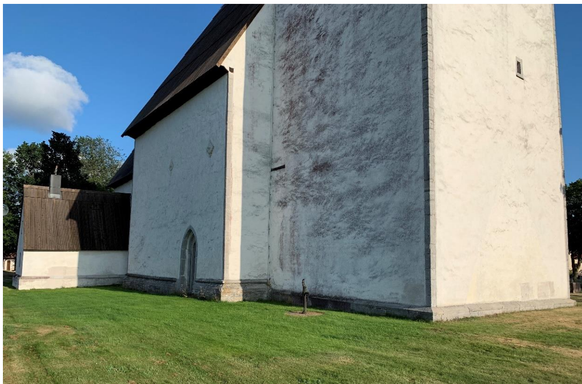
Kyrkans norra sida, sedd från väster. Den inmurade svarta bjälken i tornmuren utgör en del av det romanska långhusets hammarband. Foto JL 2019.
