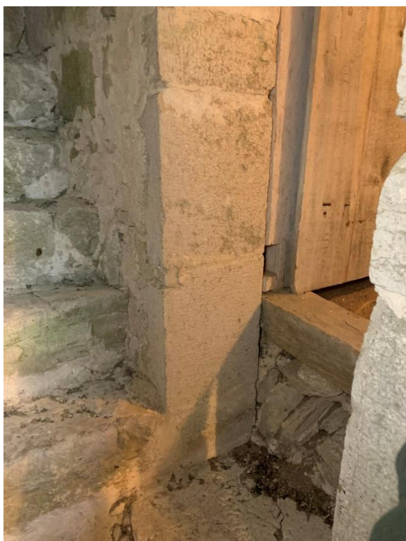
Ingång till tornets första övervåning. Golvet höjt vid valvbygget. Till höger den välhuggna omfattningens övre del. Längre upp i trappan en liknande ingång till nästa våning.
