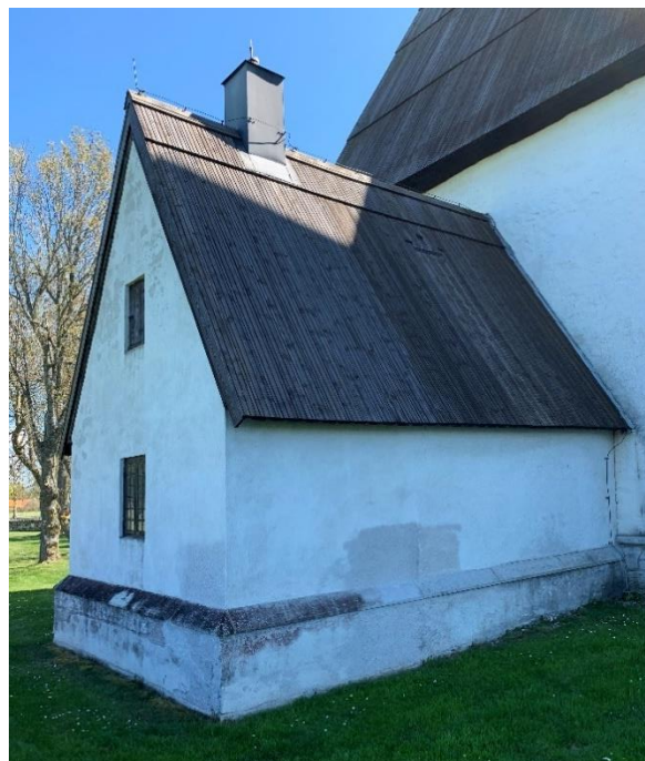
Sakristian från nordöst och nordväst. Byggd efter ritning 1881, ombyggd 1958-59 och tillbyggd åt norr med dörr och ny gavel 1998. Foto JL 2020.
