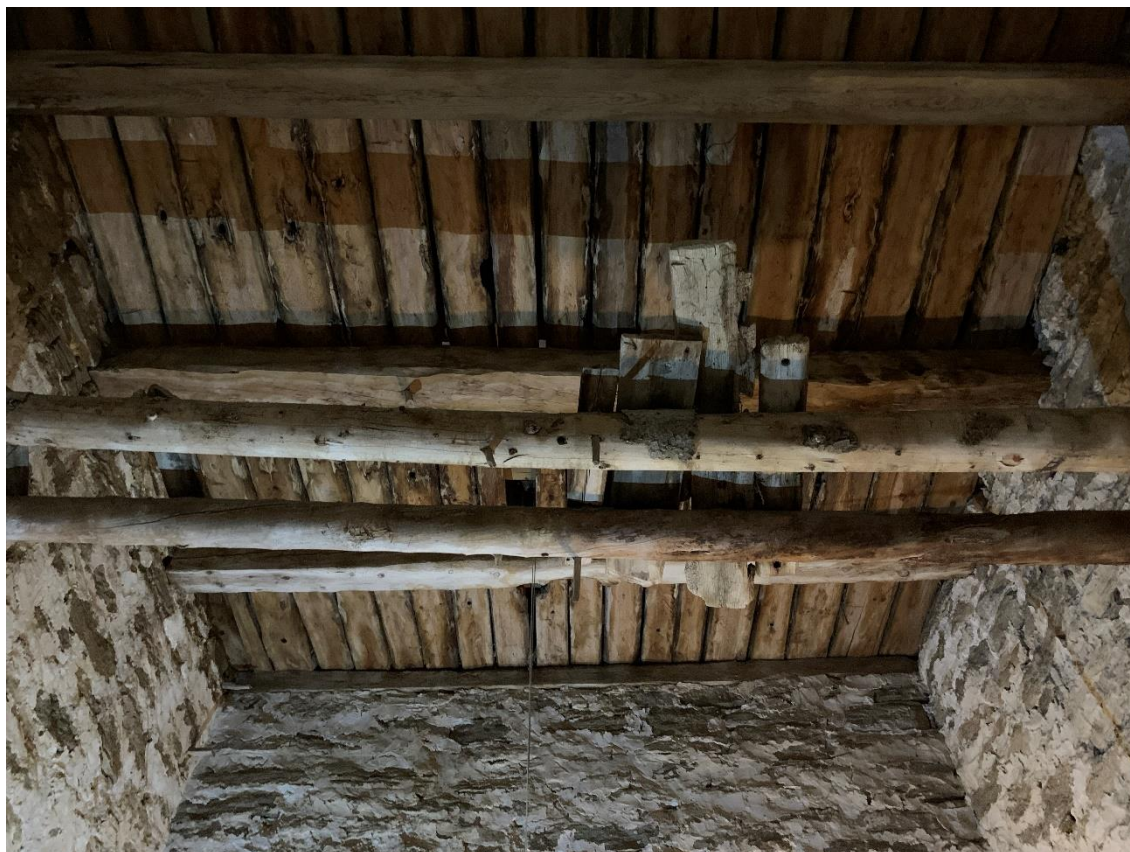
Tornets andra övervåning sedd uppåt mot väster. Foto Lisa Johansson 2020, Gotlands Museum.
