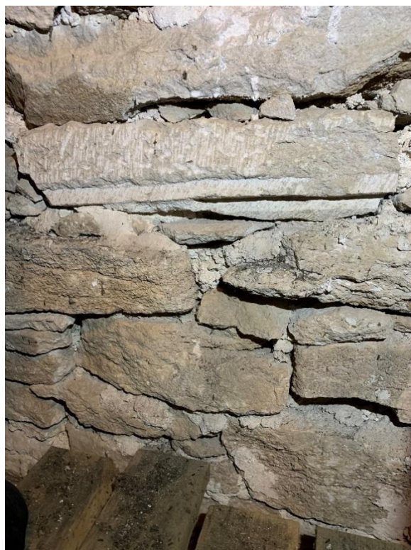
Korets östra gavelmur. Röstets spets i 1860-talets lägre takfall, sannolikt ommurat vid taksänkningen med sten med äldre fasadputs samt arkitekturfragment, troligen från någon av gavelrösternas gluggar. Foto JL 2020.
