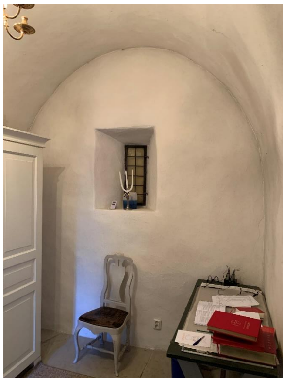
Interiör av sakristian mot norr och söder. Fönstret mot norr från 1958-59 på platsen för ett större spetsbågigt fönster från sakristians byggnadstid på 1880-talet, sattes igen vid tillbyggnaden 1998. Det murade tunnvalvet ersatte ett träinnertak 1958-59. Skåpinredning från 2012. Foto JL 2020.
