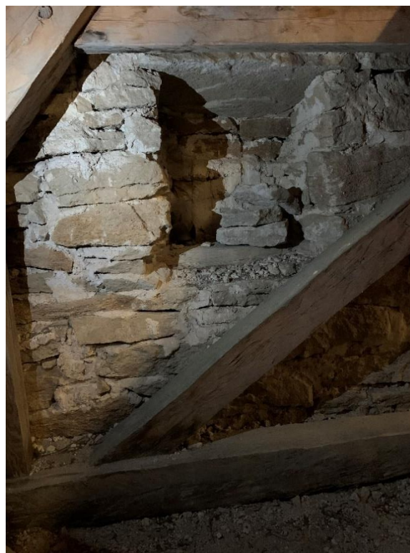
Långhusvindens sydvästra hörn med tornets hörnkedja murad med stora block, 1860-talets murverk med kalksten i litet format och 1958-59 års påmurning med återanvänt tegel från den rivna skorstenen. Foto Lisa Johansson 2020, Gotlands Museum. Till höger nisch i gavelmuren i långhusets nordöstra hörn. Foto JL 2020.
