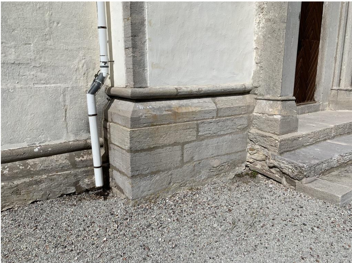
Socklar i långhuset (den lägre) och koret (den högre) samt anslutningen till korportalen. Att korets sockel löper runt hörnet och att koret har huggen hörnkedja kan antyda att det under korbygget inte var säkert att långhuset skulle rivas och ersättas av ett nytt. Foto JL 2020.
