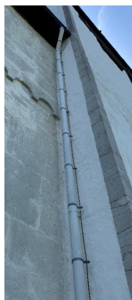
Långhusets sydvästra och nordvästra hörn. Den putsade spalten mellan långhusets hörnkedja och tornets östra mur upphör ovanför rundbågsfrisen och visar att långhusmurens övre parti ovanför frisen kragat ut även på västfasaden. Den visar också att tornets sockelmur lagts ut även mot långhusgaveln innan man började resa tornmurarna. Foto JL 2020.
