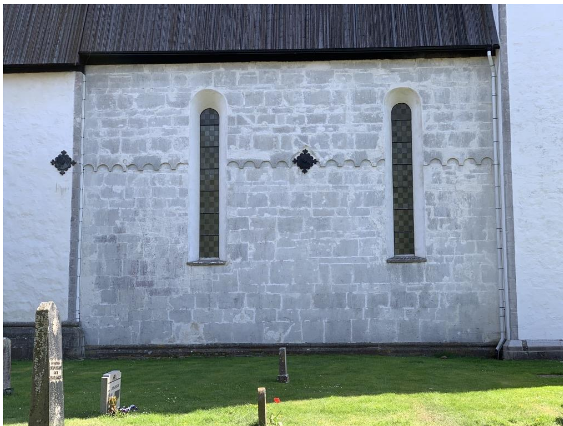
Långhusets norra fasad. Foto JL 2020.
