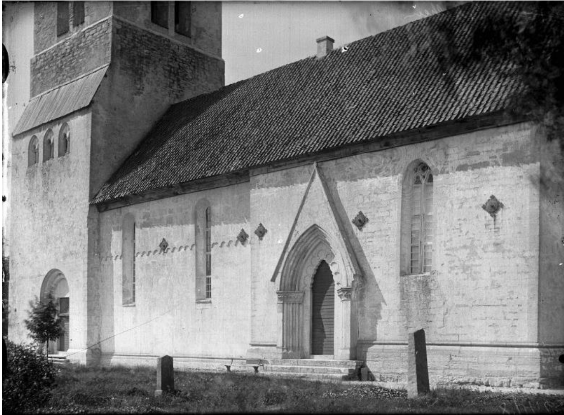
Sydfasaden från sydöst. Foto Anders Roland 1923, RAÄ, Kulturmiljöbild. Skorstenen tillkom 1922.
