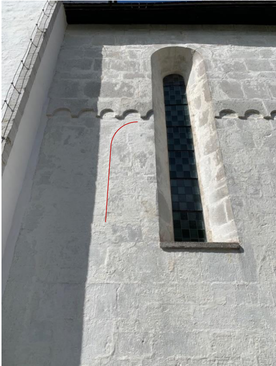
Hjälplinjer för att på föregående bilder markera spår av omfattningsbågar för äldre fönster vid långhusets sydvästra respektive sydöstra fönster.
