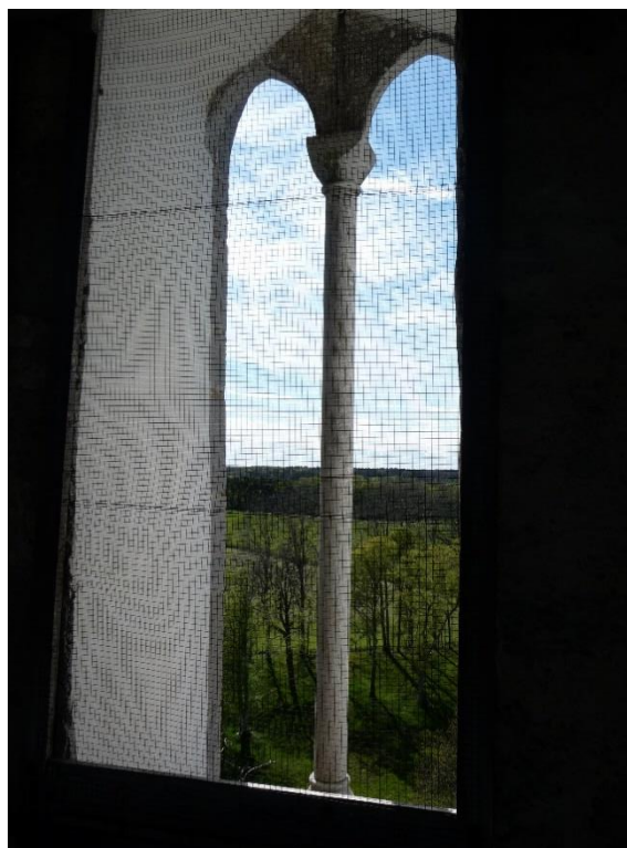
Till vänster: Klockvåningen mot väster. Foto JL 2020. Till höger: Ljudglugg mot väster. De smäckra kolonnerna är rekonstruktioner från 1992–93 utifrån rester av de ursprungliga. Foto ES 2020.
