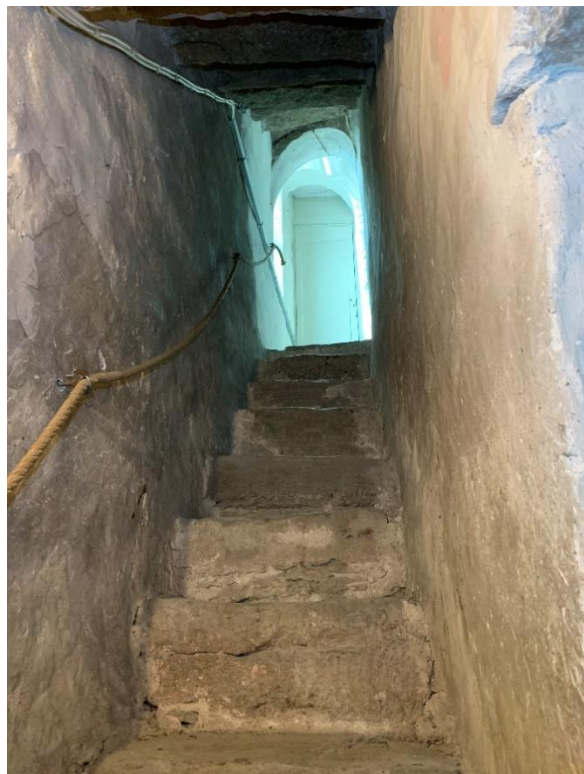
Murtrappa i tornets västra mur, trapploppet upp till tornets västra fönster. Foto JL 2020.
