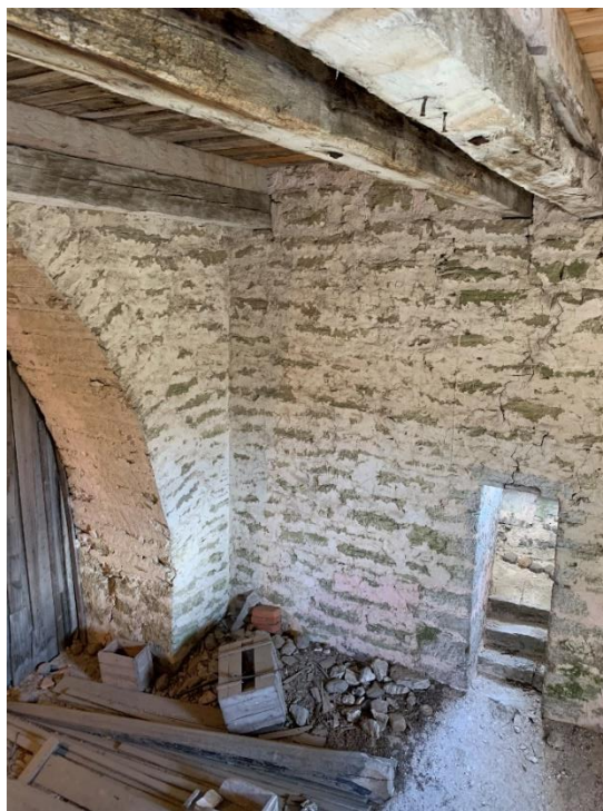
Till vänster: Tornets första övervåning med vid avlastningsbåge mot långhusvinden, igensatt med en brädvägg. Foto JL 2020. Till höger: Tornets första övervåning sedd mot sydöst, snett ovanifrån. Foto JL 2020.
