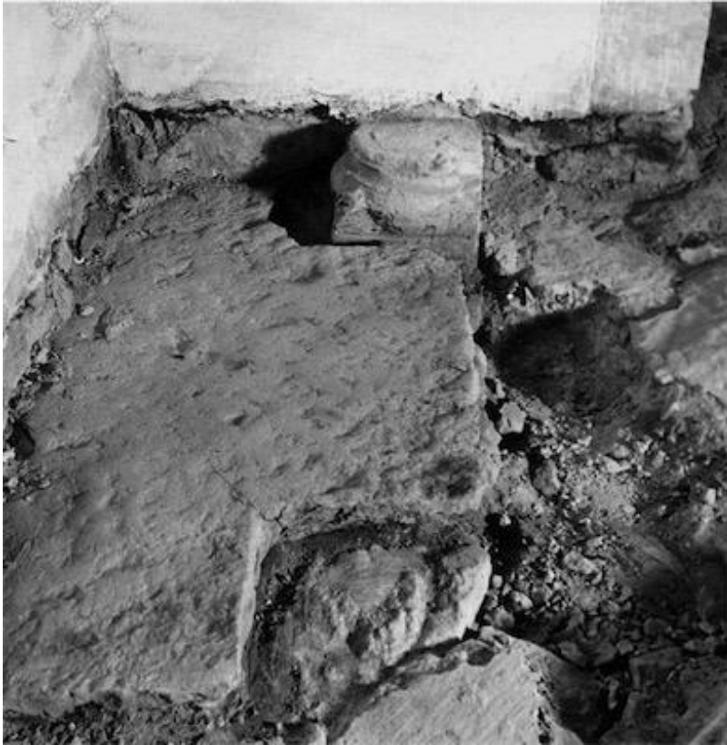
Trampsten och kolonettbaser till det tidigare korets sydportal i nuvarande korets sydvästra hörn, sett mot väster. Foto Gunnar Svahnström 1959-60. Gotlands Museum.
