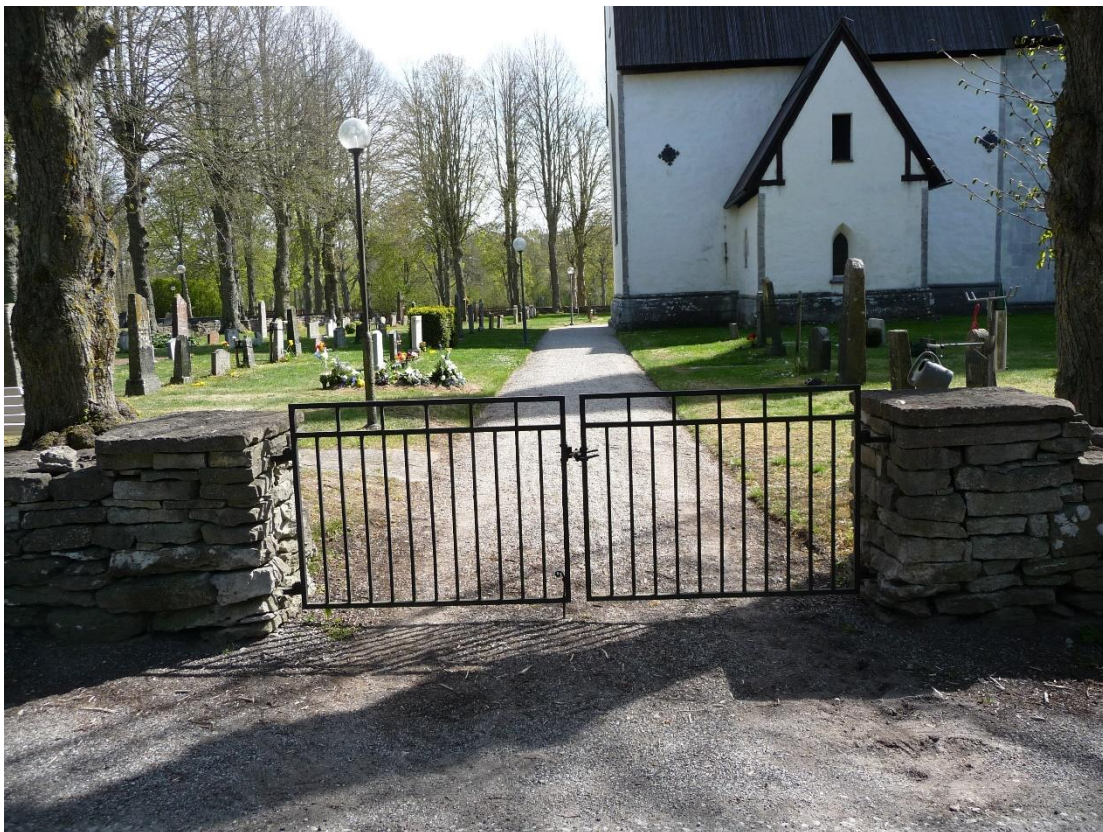
Ingången från norr har i likhet med de andra ingångarna järngrindar med stolpar i kallmurad kalksten. Foto ES 2020.
