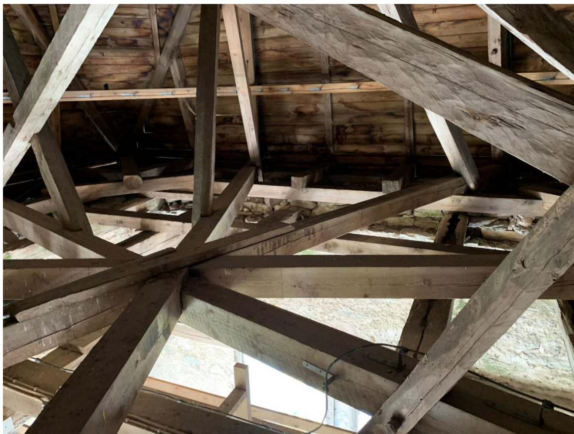
Tornhuvens bärande bjälklag på murkrönet. Foto JL 2020.
