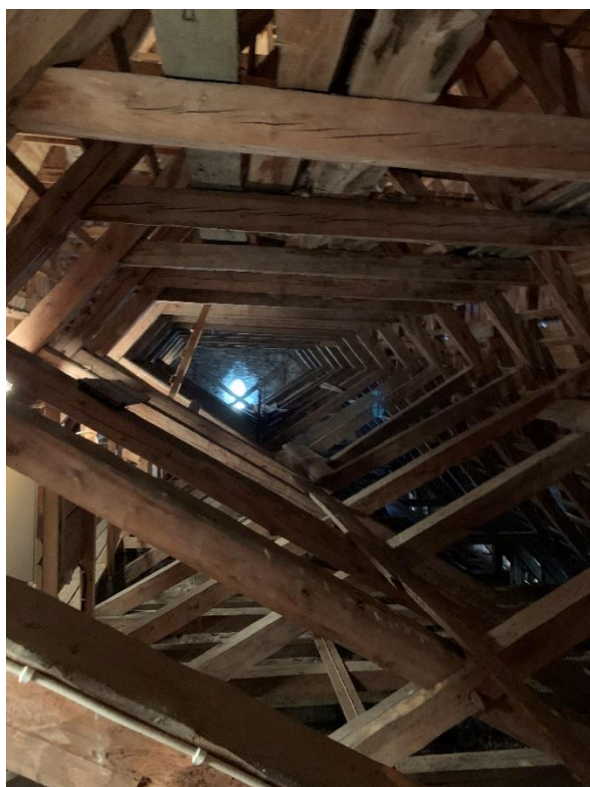
Långhus- och korvinden mot öster. Takstolen från takombyggnaden 1860 utgör ännu stomme. Till höger: Den 1959–60 påbyggda takstolens övergång från koret till långhuset sett uppåt mot väster. Foto JL 2020.
