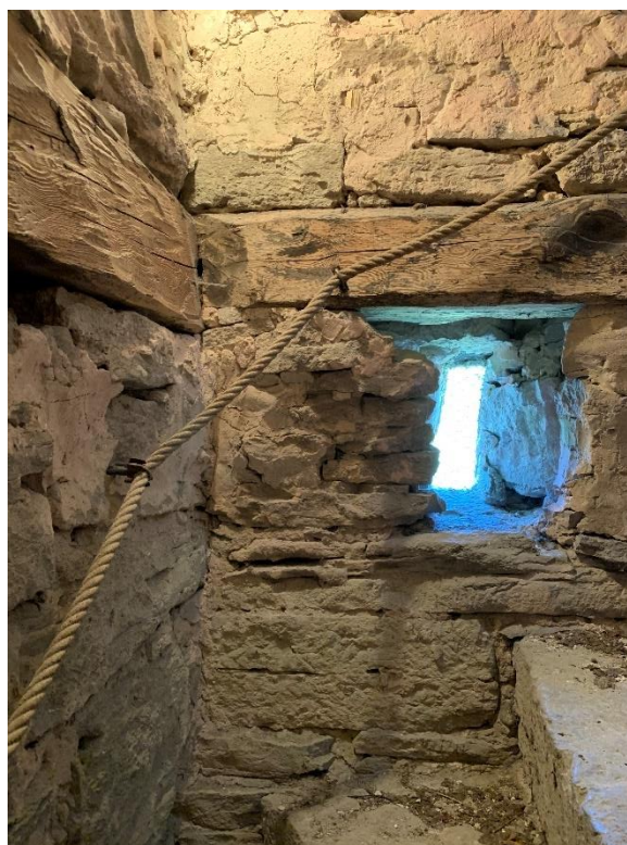
Till vänster: Västra murens övre trapplopp sett uppifrån ner mot västfönstret. Till höger: Ljusglugg och inmurade dragbjälkar i trappan i tornets nordvästra hörn. Foto JL 2020.
