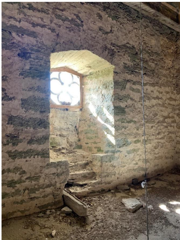
Tornets första övervåning. Fönsternischen mot väster med inmurad stock med skåra, troligen syll till en innervägg. Foto JL 2020.
