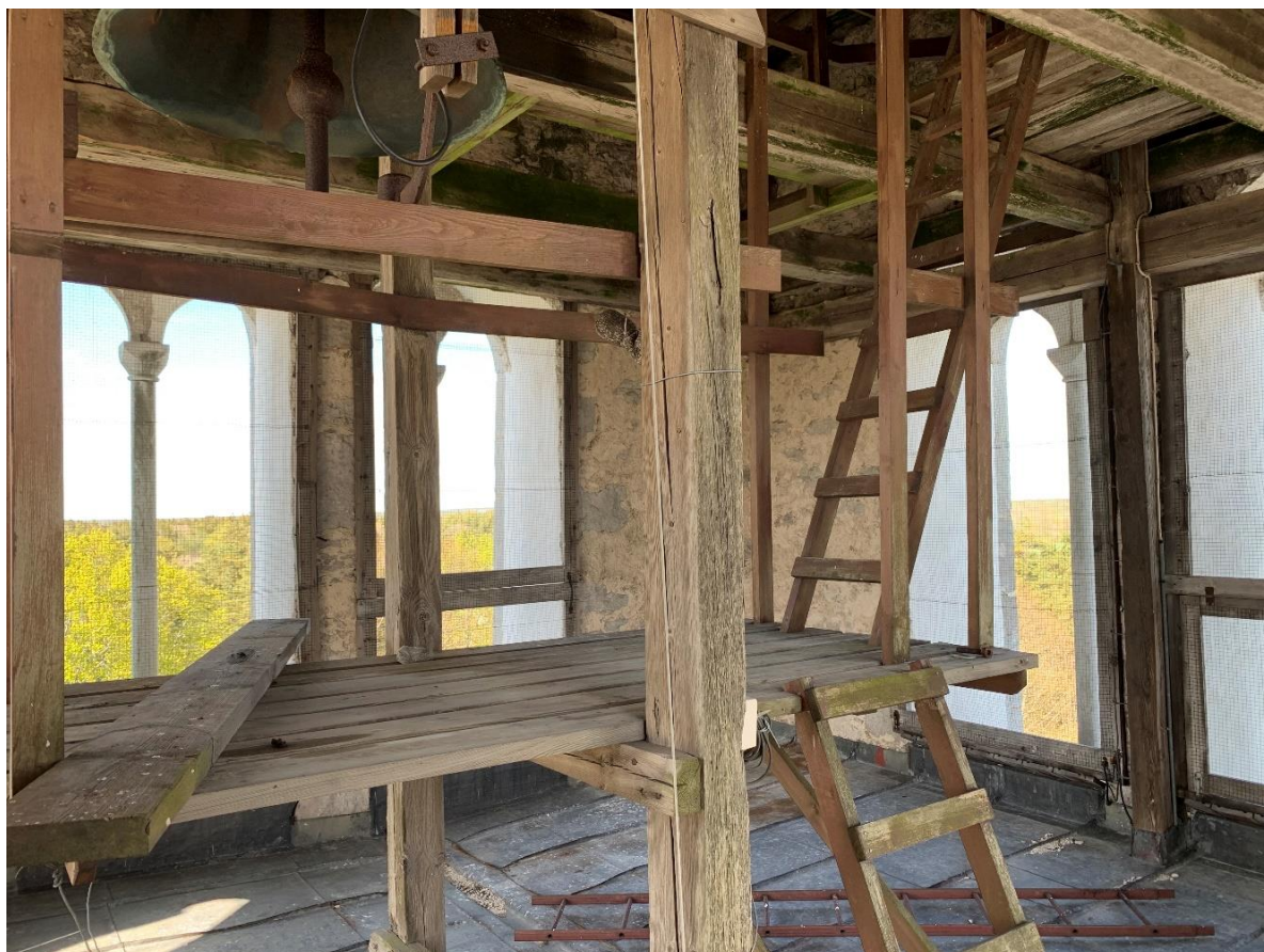
Klockvåningen mot nordöst. Foto JL 2020.
