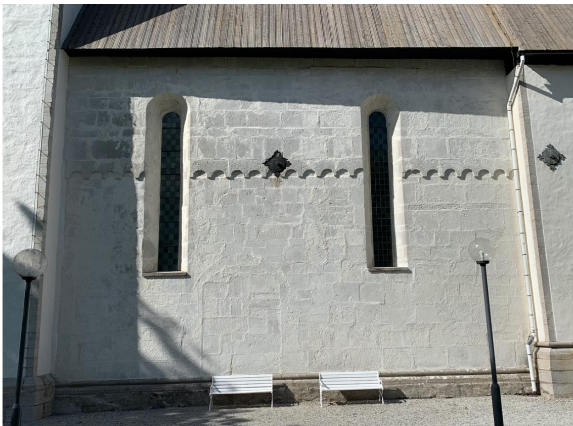
Samma fasad i släpljus. Den tidigare portalens läge framträder i murverket. Foto JL 2020.
