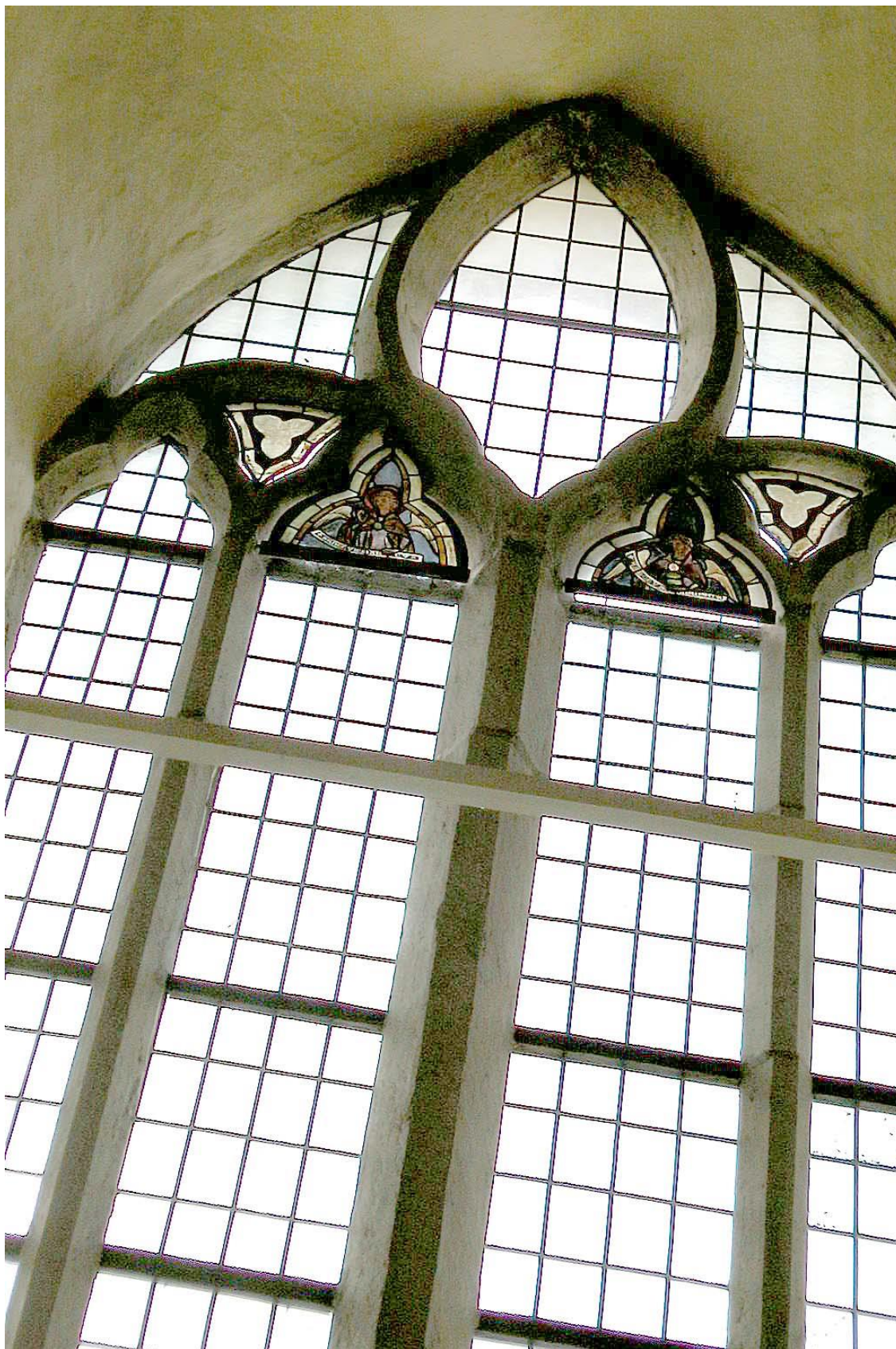
Detalj av korets östra fönster, visande masverk och glasmålningsrutor. Foto Bo-Göran Kristoffersson 2003-04, Visby stift.
