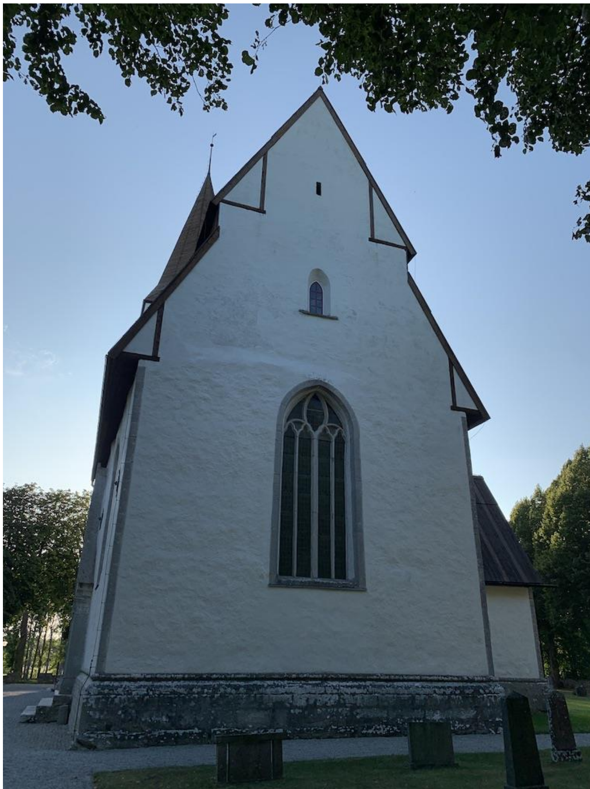
Korets östra gavel. Masverksfönstret från 1300-talet kan möjligen ha ersatt ett äldre fönster eller en fönstergrupp. Däröver ett vindsfönster från 1859-60 samt en rektangulär glugg från 1956-57, när gaveln återfick sin medeltida form med förhöjt mittparti. Foto JL 2019.
