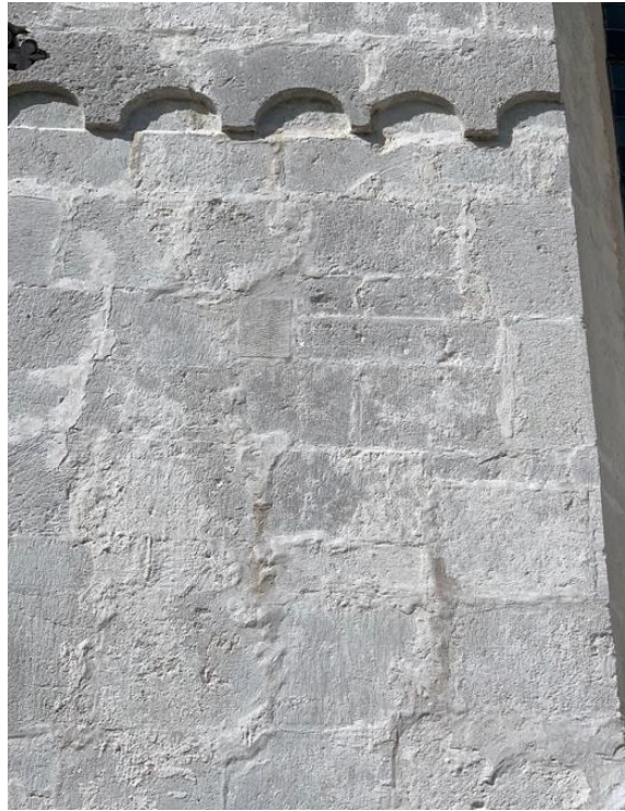
Sannolika lägen för igensatta fönster, omedelbart väster om båda de nuvarande fönstren och med bågkrön strax under rundbågsfrisen, att döma av spår i murverket. Foto JL 2020.
