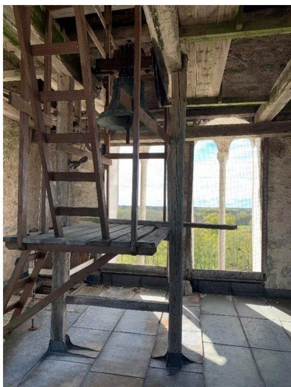
Till vänster: Klockvåningen mot väster. Foto JL 2020. Till höger: Ljudglugg mot väster. De smäckra kolonnerna är rekonstruktioner från 1992–93 utifrån rester av de ursprungliga. Foto ES 2020.
