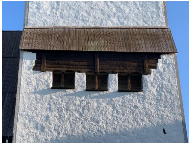
Tornet från sydöst samt detalj av norra galleriet, lagat med trä i skiftesverkskonstruktion, sannolikt på 1600-talet. Foto JL 2019.
