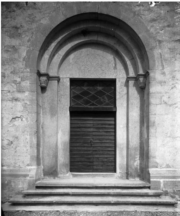
Tornets sydportal med infogat fönsterparti för att ge ljus under läktaren, borttaget 1959-60 och innan kolonnetterna rekonstruerades. Foto Olof Sörling 1891. RAÄ, Kulturmiljöbild.
