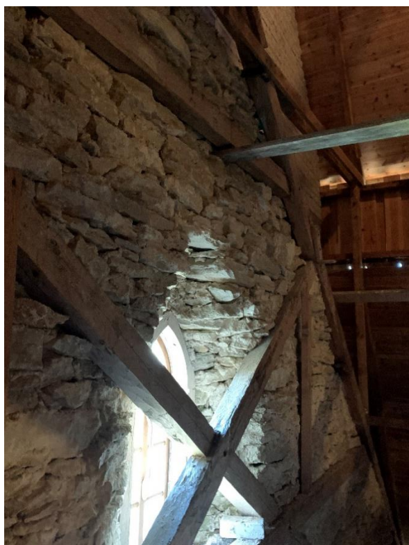
Korets östra gavelröste. Det 1860 ommurade röstet med samtida ljusöppning. Till höger: Röstets påmurning från 1959–60. Foto JL 2020.
