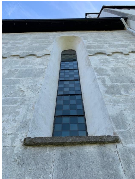
Långhusets nordöstra och nordvästra fönster. Till skillnad från fönstren på södra sidan saknas murad omfattning och smygarna är putsade, vilket tyder på att fönstren är yngre och upptagna på 1800-talet. De nämns inte i Brunius beskrivning 1864. Foto JL 2020.
