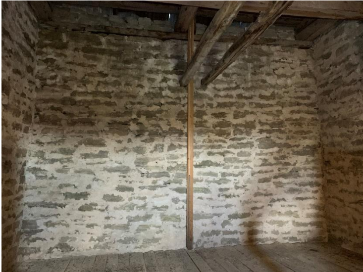
Tornets andra övervåning mot öster. Foto JL 2020.
