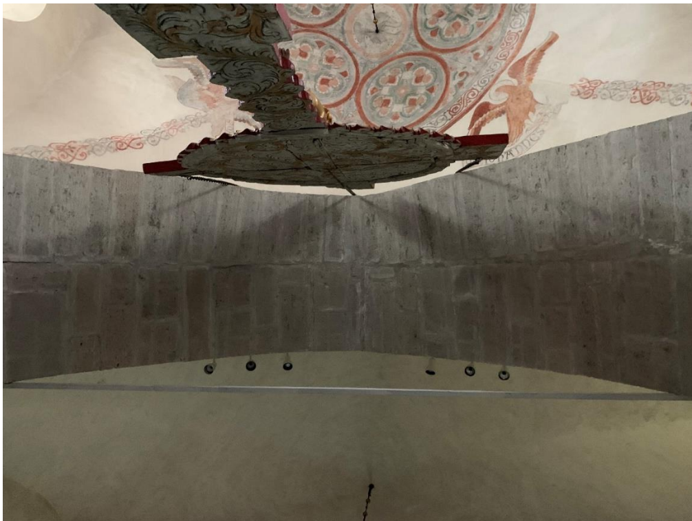
Triumfbågens krön. Öster nedåt. Den övre västra hälften av bågen, som hör till långhuset, förefaller fogad till den nedre östra, vilket tyder på att den del av bågen som hör till koret är äldre. Foto JL 2019.
