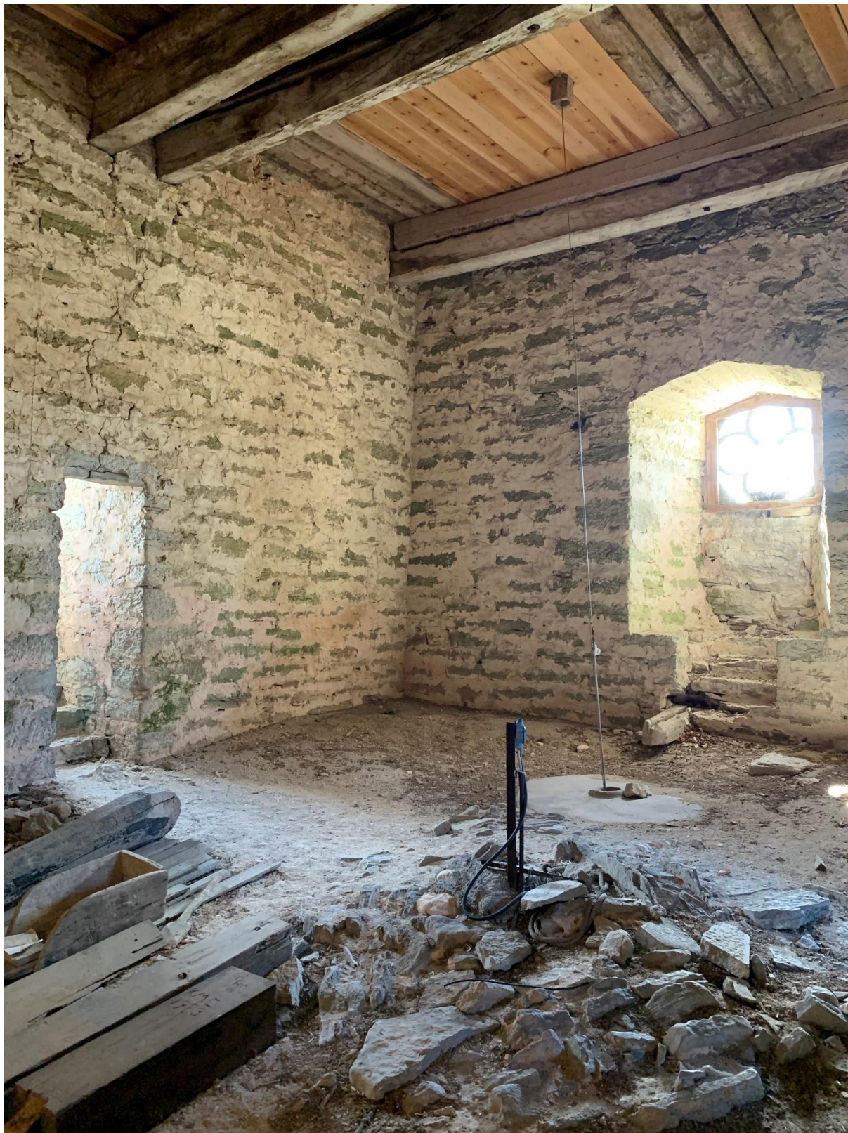
Tornets första övervåning. Interiör mot sydväst. Foto JL 2020.
