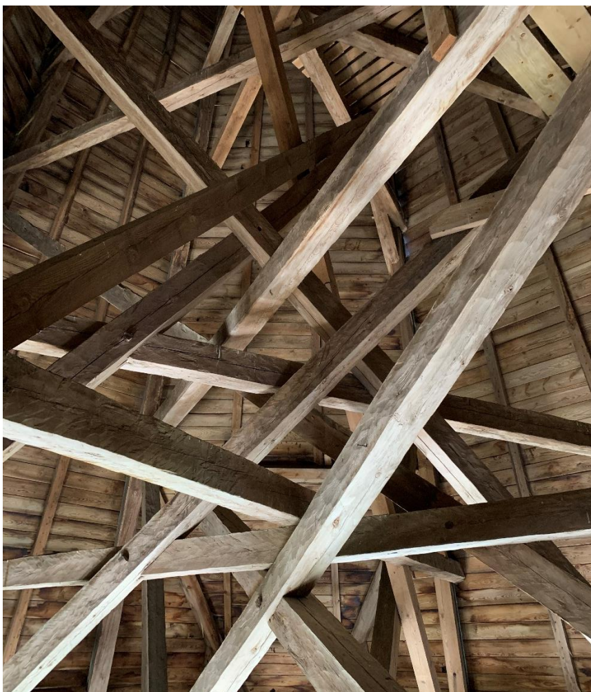
Interiör av tornhuven. Foto JL 2020.
