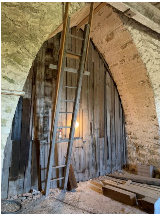
Till vänster: Tornets första övervåning med vid avlastningsbåge mot långhusvinden, igensatt med en brädvägg. Foto JL 2020. Till höger: Tornets första övervåning sedd mot sydöst, snett ovanifrån. Foto JL 2020.
