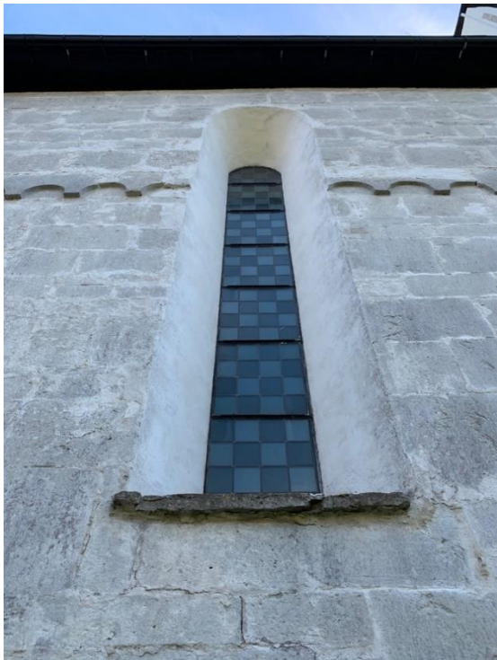
Långhusets nordöstra och nordvästra fönster. Till skillnad från fönstren på södra sidan saknas murad omfattning och smygarna är putsade, vilket tyder på att fönstren är yngre och upptagna på 1800-talet. De nämns inte i Brunius beskrivning 1864. Foto JL 2020.
