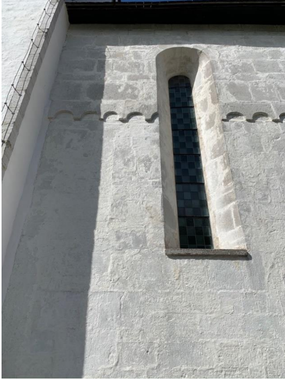
Sannolika lägen för igensatta fönster, omedelbart väster om båda de nuvarande fönstren och med bågkrön strax under rundbågsfrisen, att döma av spår i murverket. Foto JL 2020.
