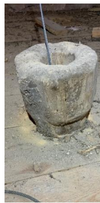
Till vänster: Bjälkar i tornets andra övervåning, sedda mot öster. Till höger: Sturk, träskoning för klockrepet, placerad i trägolvet till tornets andra övervåning. Foto JL 2020.
