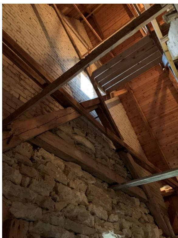
Korets östra gavelröste. Det 1860 ommurade röstet med samtida ljusöppning. Till höger: Röstets påmurning från 1959–60. Foto JL 2020.
