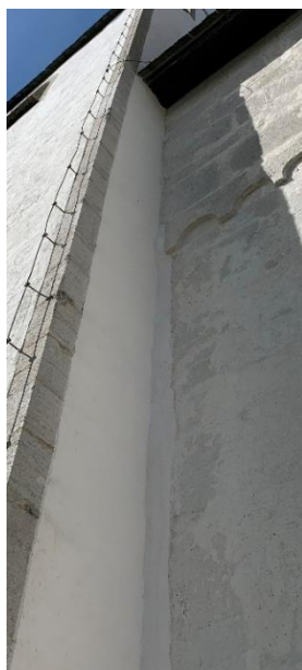
Långhusets sydvästra och nordvästra hörn. Den putsade spalten mellan långhusets hörnkedja och tornets östra mur upphör ovanför rundbågsfrisen och visar att långhusmurens övre parti ovanför frisen kragat ut även på västfasaden. Den visar också att tornets sockelmur lagts ut även mot långhusgaveln innan man började resa tornmurarna. Foto JL 2020.
