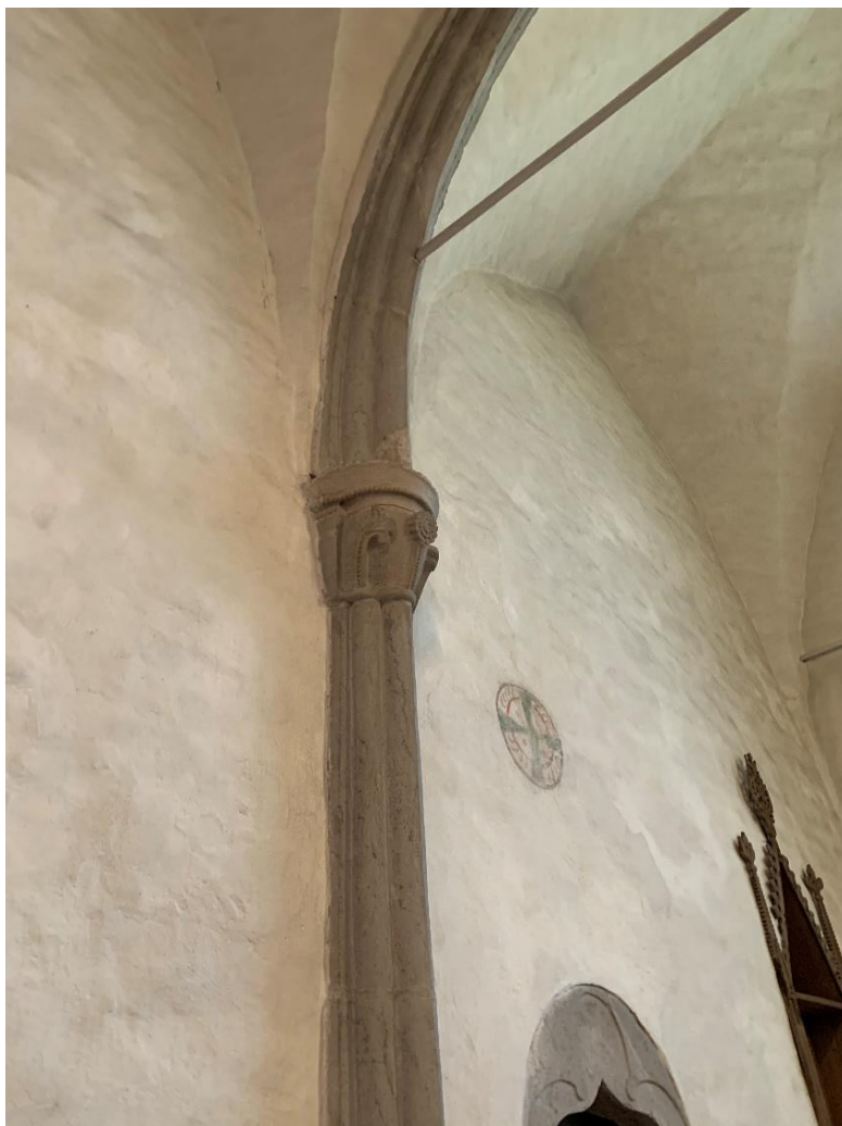
Korets norra mur med valvpilaster till gördelbåge. Foto JL 2020.
