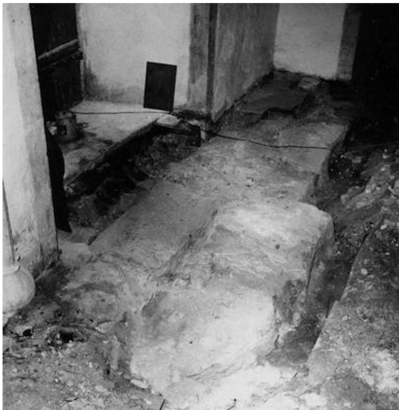
Grundmurar till det äldre koret. I förgrunden anslutningen mellan kor och absid. Foto Gunnar Svahnström 1959-60. Gotlands Museum.
