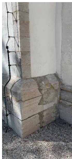
Långhusets sydvästra och nordvästra hörn. Den putsade spalten mellan långhusets hörnkedja och tornets östra mur upphör ovanför rundbågsfrisen och visar att långhusmurens övre parti ovanför frisen kragat ut även på västfasaden. Den visar också att tornets sockelmur lagts ut även mot långhusgaveln innan man började resa tornmurarna. Foto JL 2020.
