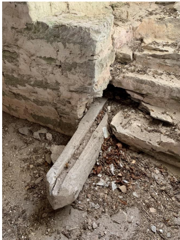
Tornets första övervåning. Fönsternischen mot väster med inmurad stock med skåra, troligen syll till en innervägg. Foto JL 2020.
