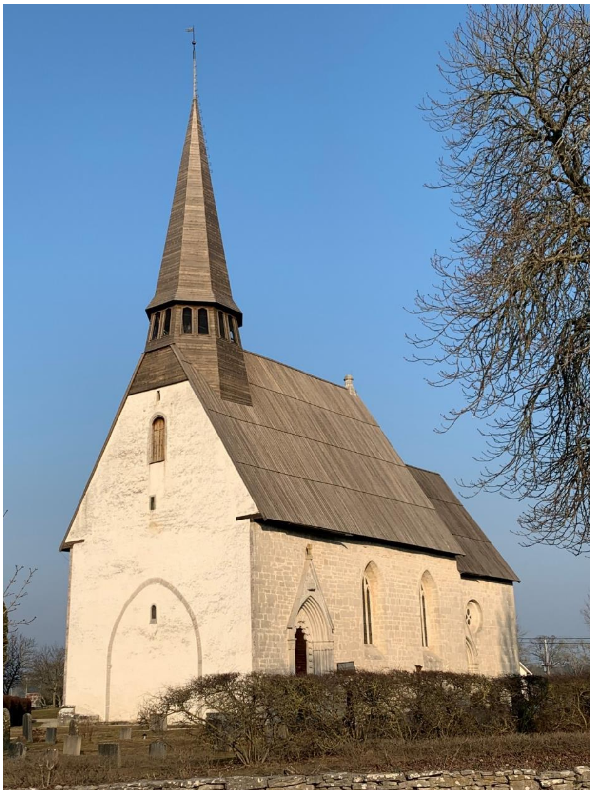
Exteriör från sydväst. Foto JL 2022.
