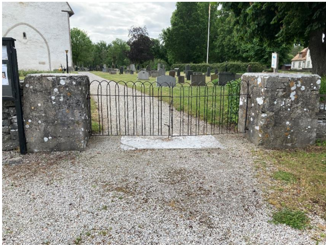
Ingången från väster. Grindar i smidesjärn med fyrkantiga putsade stolpar, liknande ingången från söder. Foto ES 2022.
