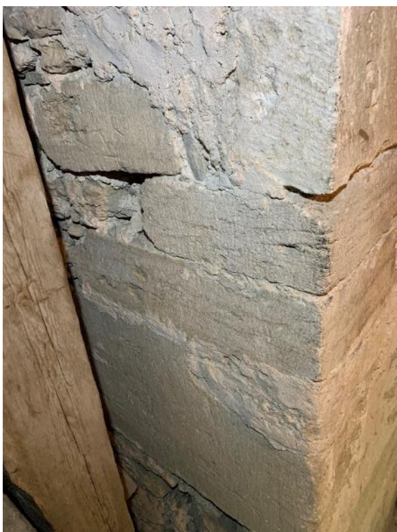
Slåthuggna stenblock med stenhuggarmärken i långhusets västgavel. Till höger ljusöppning i långhusets västgavel. Foto JL 2022.
