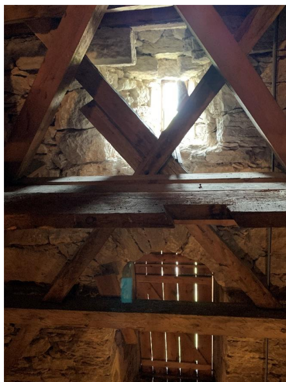
Slåthuggna stenblock med stenhuggarmärken i långhusets västgavel. Till höger ljusöppning i långhusets västgavel. Foto JL 2022.
