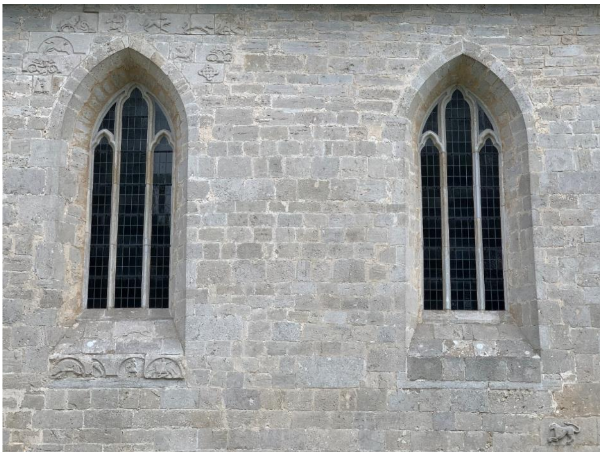
Södra långhusfasadens fönster och inmurade reliefstenar, sannolikt från den äldre kyrkan liksom kvaderstenarna i murverket i övrigt. Observera hur solbänkarna i fönstrens nederdel murats på underifrån, sannolikt redan under byggnadstiden. Foto JL 2022.
