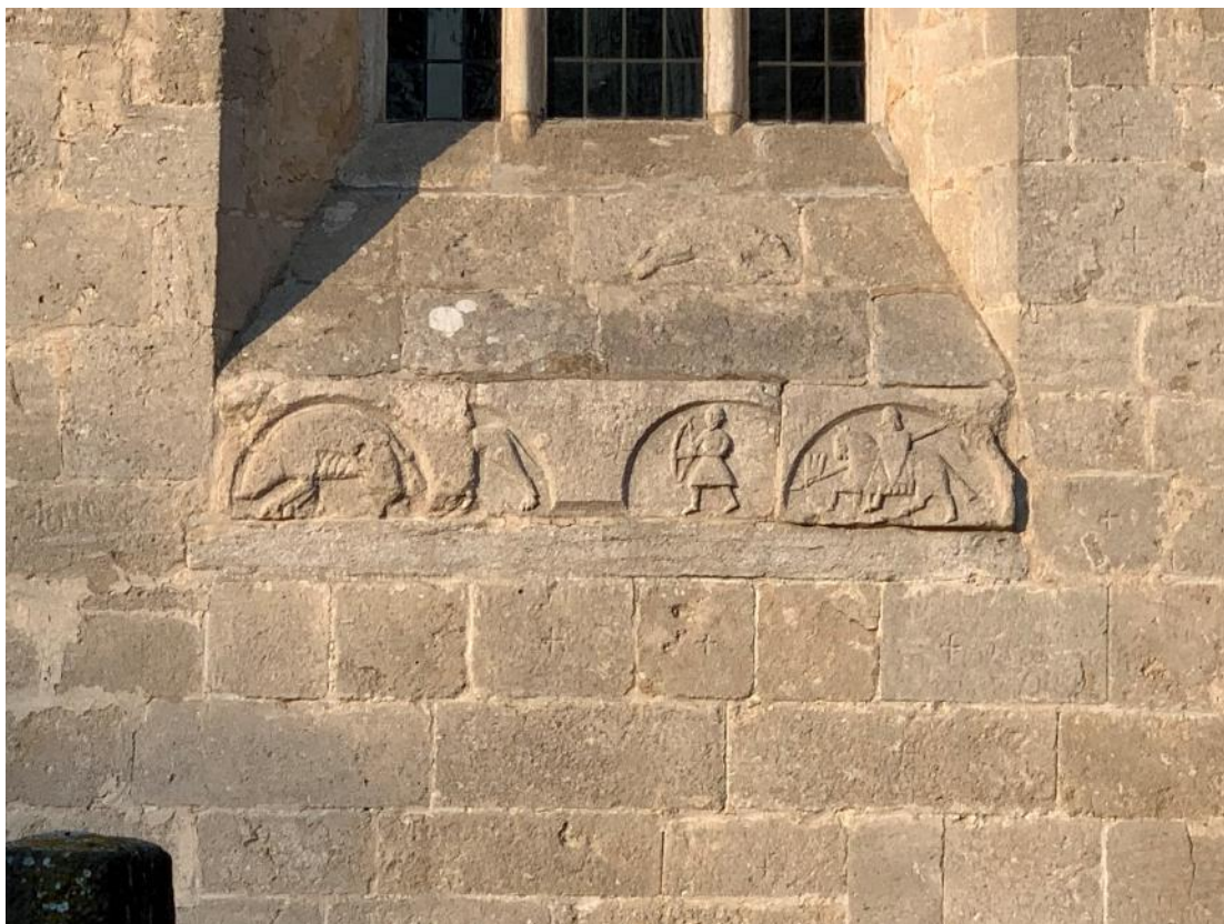
Det västra fönstrets nedre del med den ursprungligen planerade fönsterbänken synlig under påbyggnaden, vilken delvis består av inmurade äldre block med reliefer. Kors och andra märken på blocken är stenhuggarmärken. Foto JL 2022.
