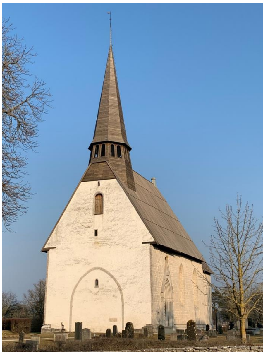
Västgaveln och takryttaren från sydväst. Foto JL 2022.
