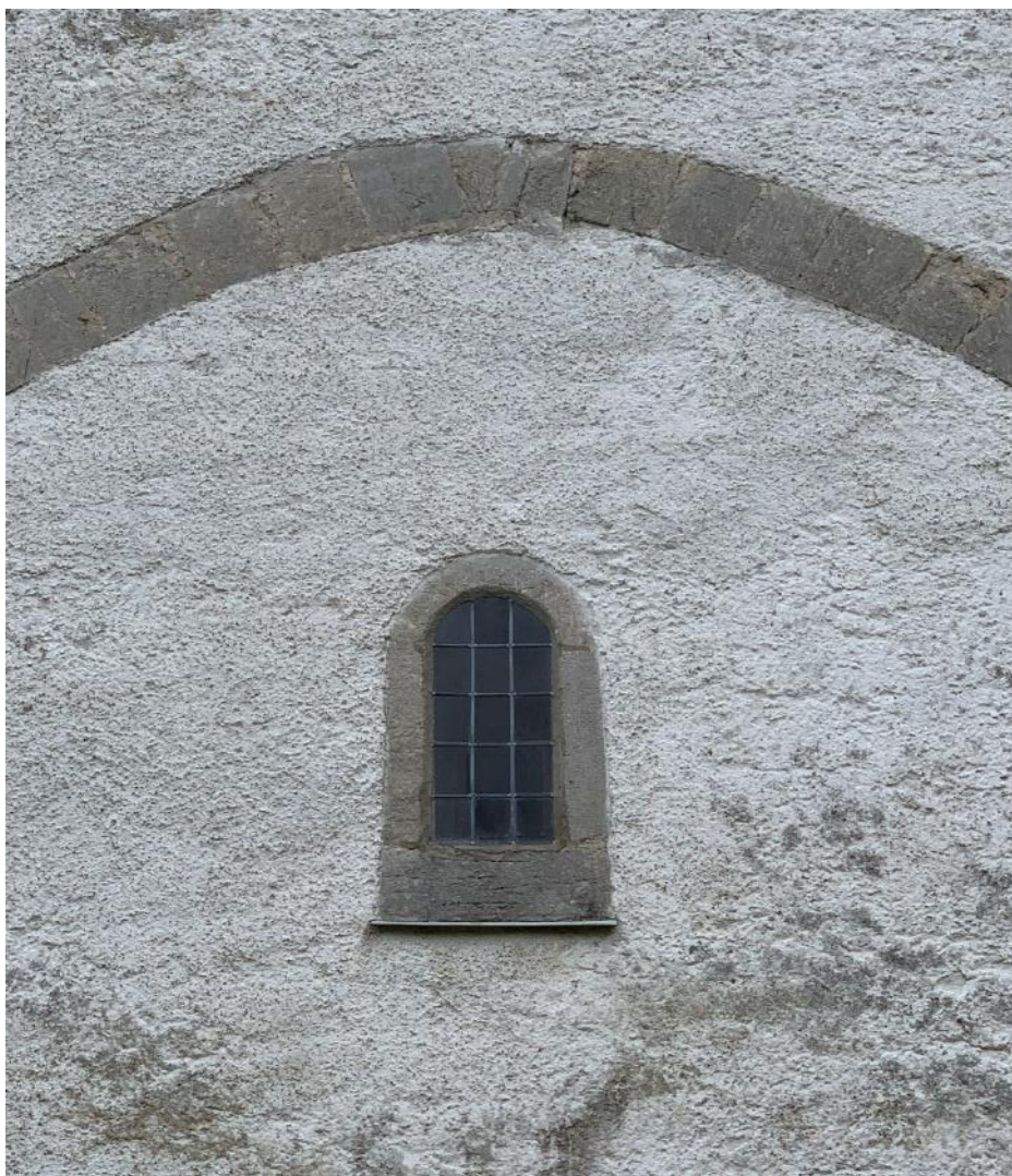
Fönster i långhusets västfasad, möjligen från den äldre kyrkan. Foto JL 2022.
