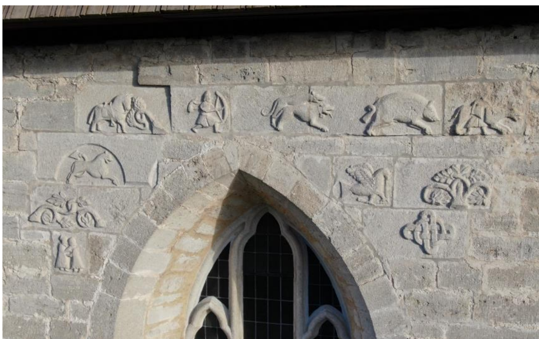
Murstenar med reliefer, återanvända från den äldre kyrkan, insatta kring det västra långhusfönstret övre del. Foto Pär Malmros 2018, Visby stift.
