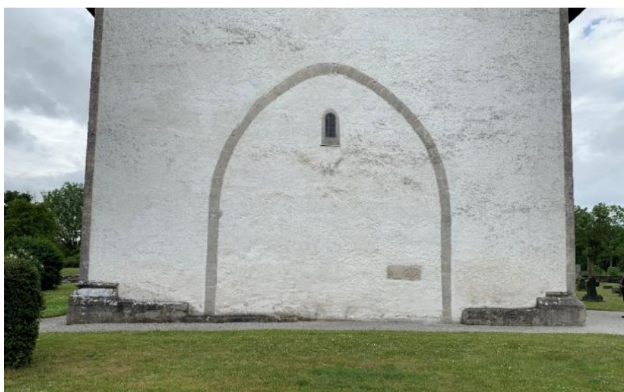
Västgavelns nedre del med förberedelser för ett västtorn som aldrig uppfördes. Foto JL 2022.
