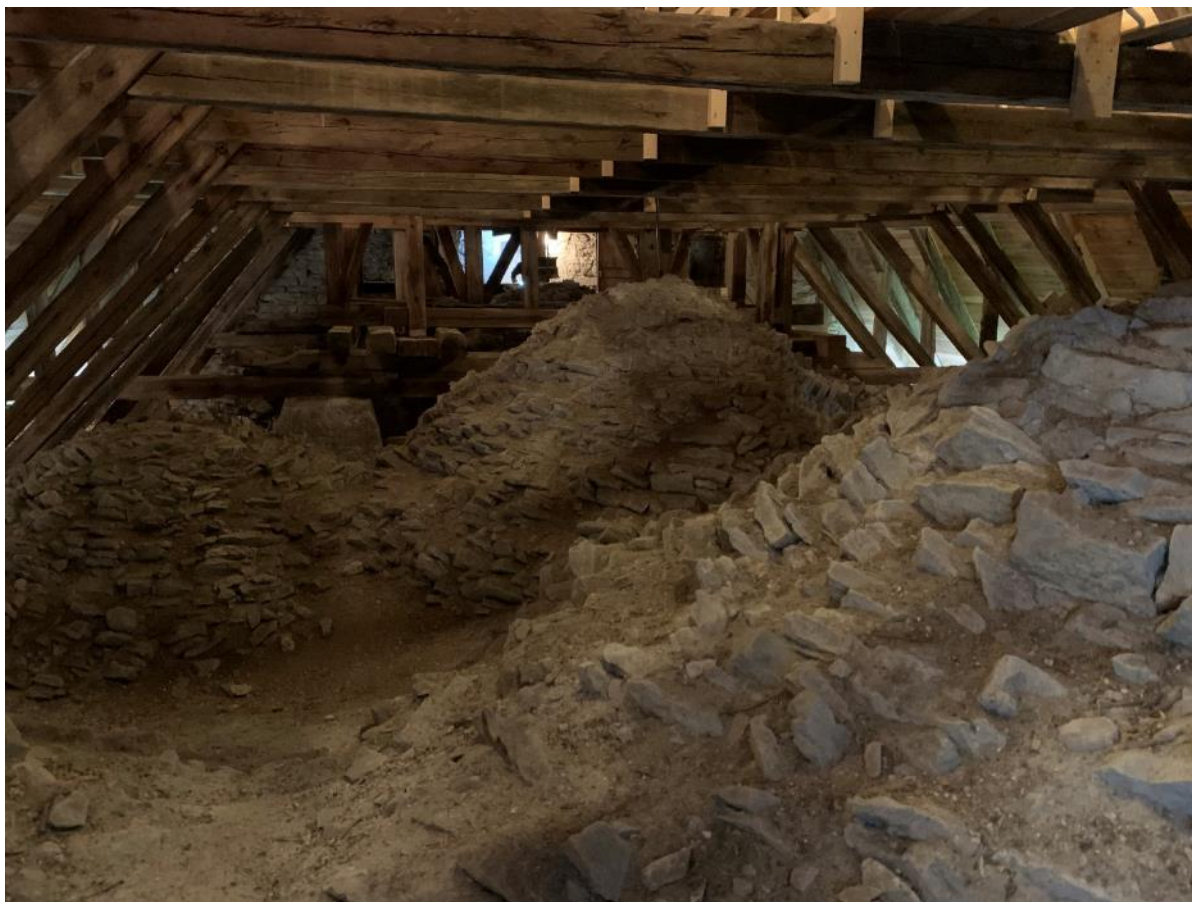
Långhusvalvens ovansida mot väster. Foto JL 2022.
