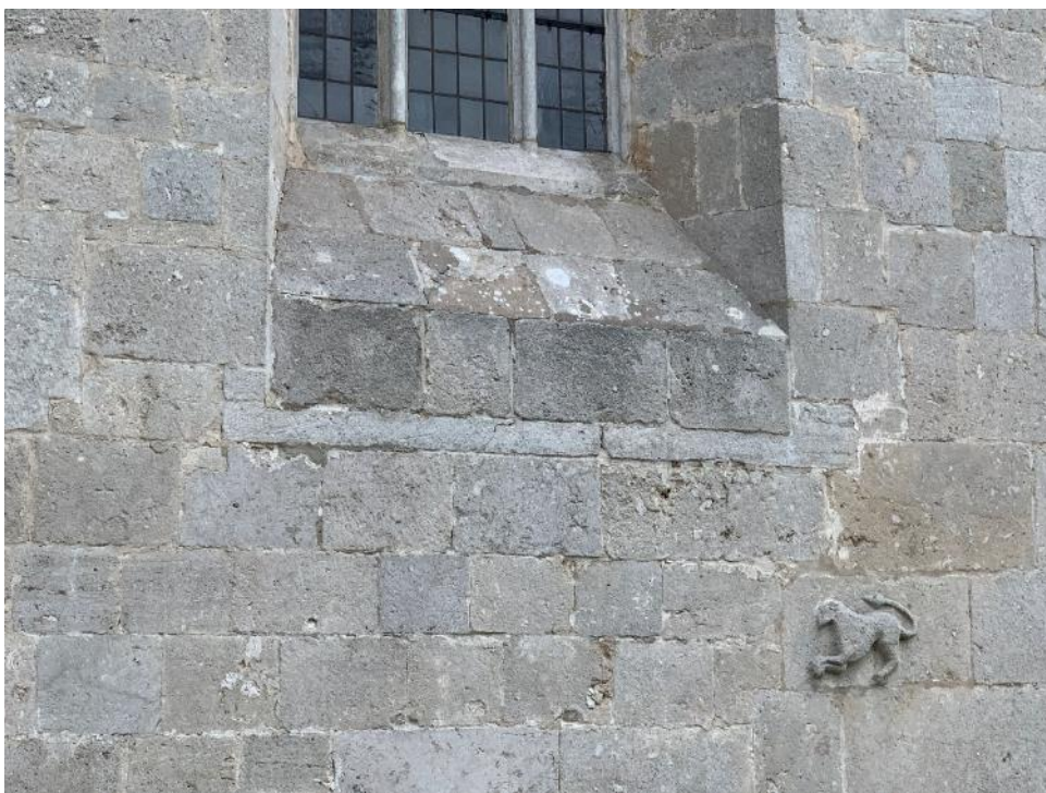
Det östra fönstrets nedre del med den ursprungligen planerade fönsterbänken synlig under påbyggnaden. Foto JL 2022.
