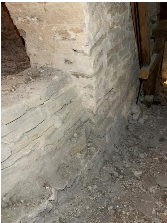
Korvindens nordvästra hörn med bågöppningen mot långhusvinden. Tröskeln påbyggd vid långhusets tillkomst. Till höger bågens södra sida med avtryck av skälbräder. Foto JL 2022.
