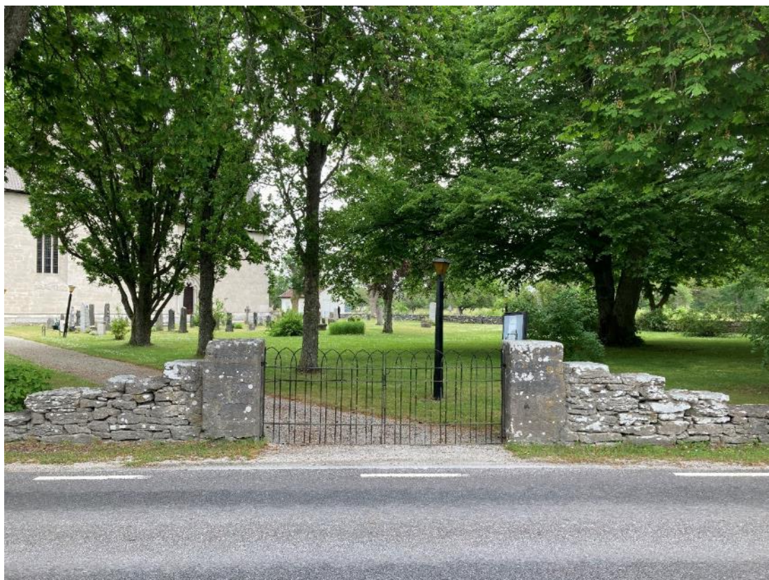
Ingången från söder. Här fanns i äldre tider en stiglucka. Grindar i smidesjärn med fyrkantiga putsade stolpar. Foto ES 2022.
