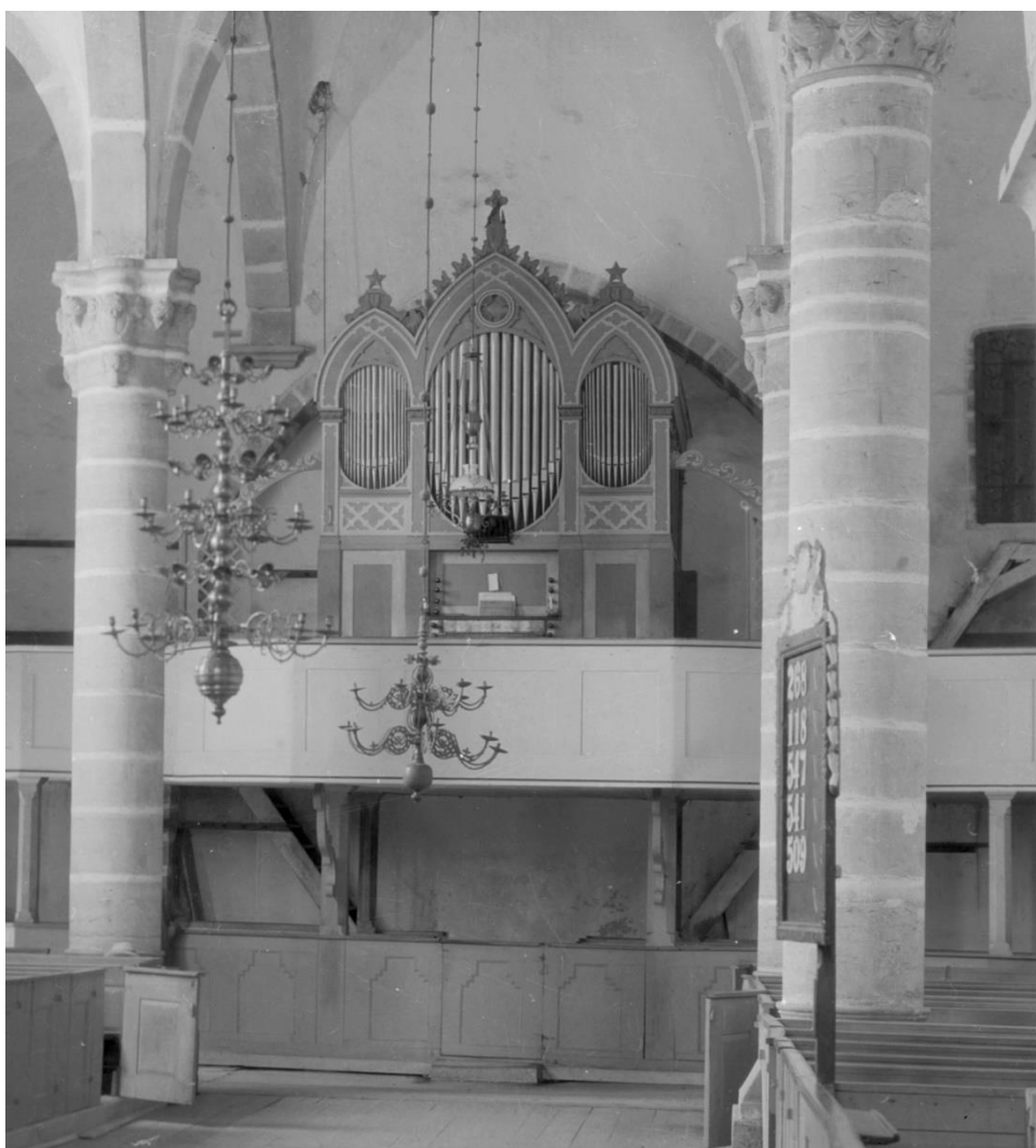
Interiör mot väster. Foto Sven Brandel 1926, ATA. Nedan detalj visande orgel av O. N. Lindqvist, Visby, 1858 samt läktaren med bänkinredning under, rivet på 1950-talet.
