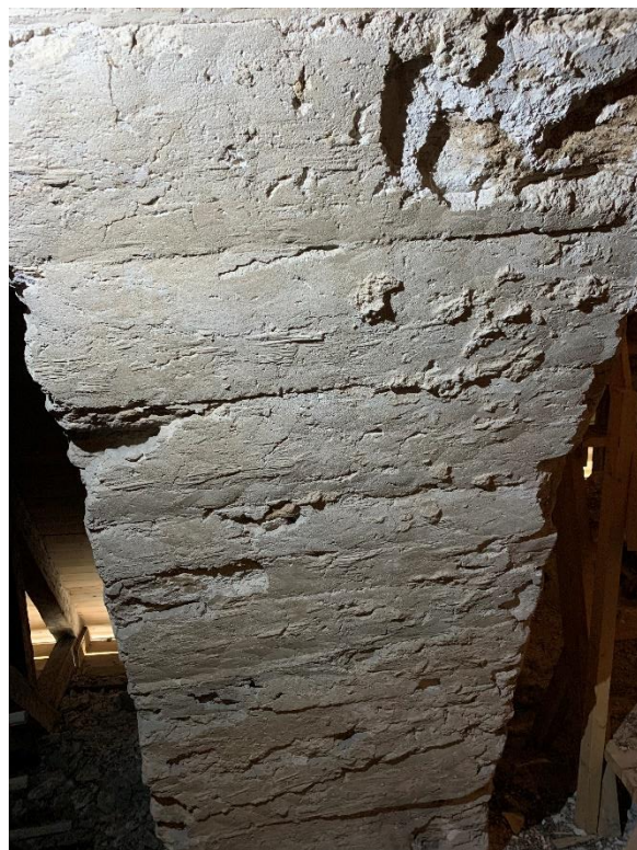
Korvindens nordvästra hörn med bågöppningen mot långhusvinden. Tröskeln påbyggd vid långhusets tillkomst. Till höger bågens södra sida med avtryck av skälbräder. Foto JL 2022.
