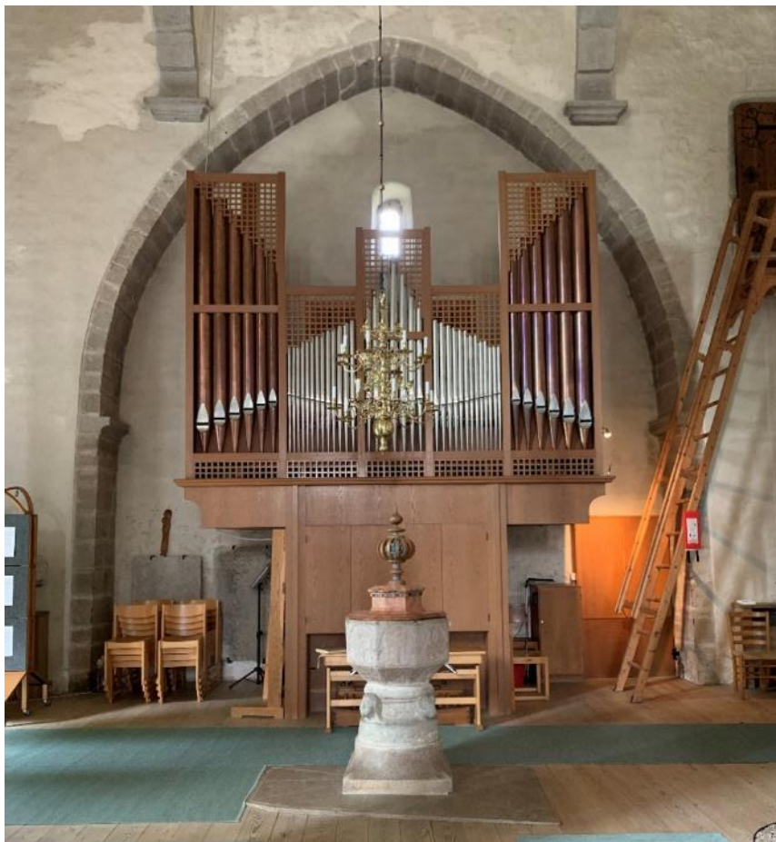
Båge i långhusets västra mur, avsedd för öppning till ej uppfört torn. Foto JL 2022.
