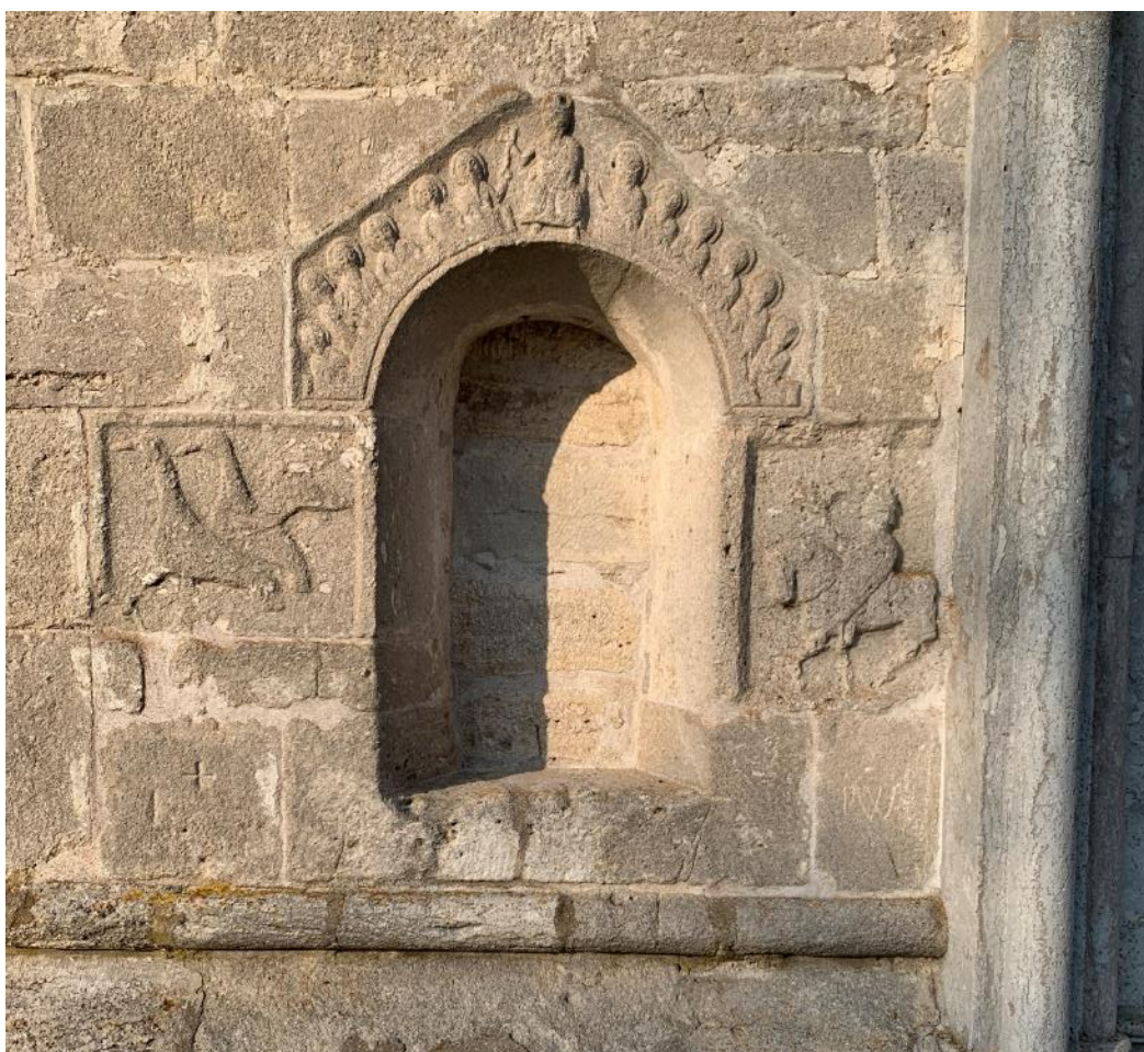
Nisch väster om södra långhusportalen, bestående av äldre fönsteromfattning från den romanska kyrkan. Foto JL 2022.
