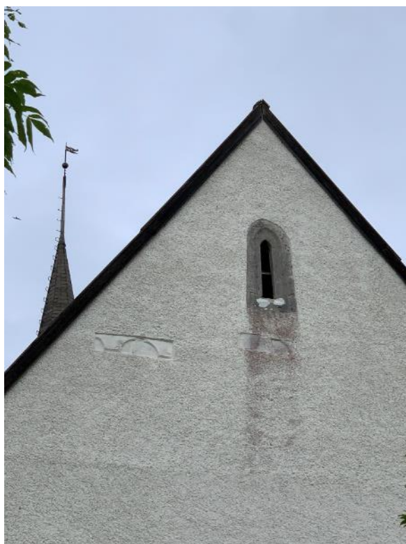
Korets östra gavelröste med inmurade delar av en odekorerad bågfris från den tidigare kyrkobyggnaden. Foto JL 2022. Till höger ljuslugg i korgaveln. Foto Pär Malmros 2022, Visby stift.
