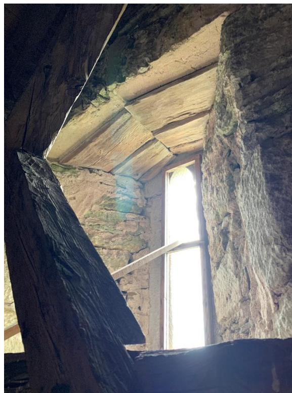
Fönster i korgaveln med kvarsittande skälbrädor i trä. Till höger närbild. Foto JL 2022.
