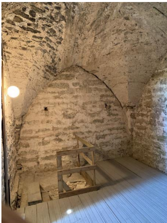
Tornets tredje övervåning mot norr och mot nordöst. Kvarsittande virken i murarna visar att denna del inte drabbats av brand, vare sig 1908 eller tidigare. Foto JL 2021.
