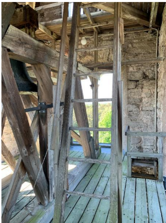
Klockvåningen innanför den mellersta våningen med ljudgluggar, sedd mot norr, med den norra ljudgluggen. Omfattningarna innerdelar förefaller något grövre i de övre än de nedersta ljudgluggarna. Foto JL 2021.
