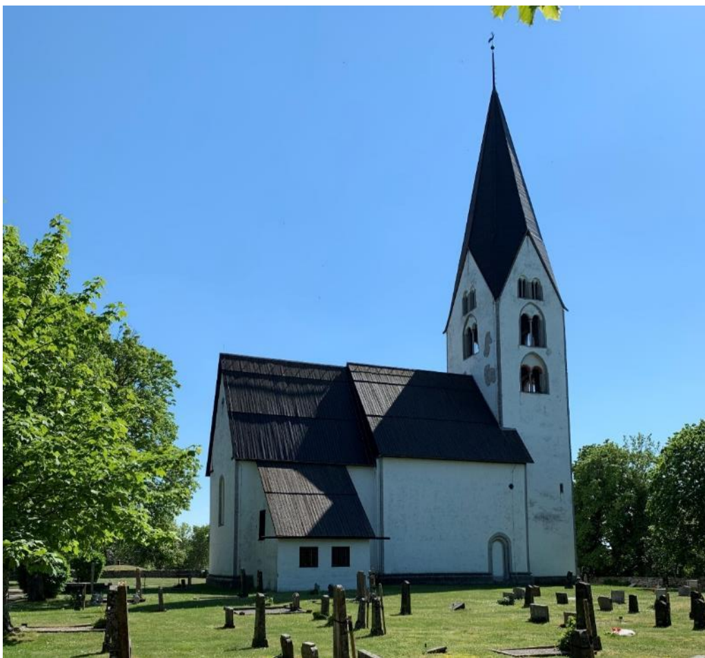
Exteriör från nordöst. Foto JL 2021.
