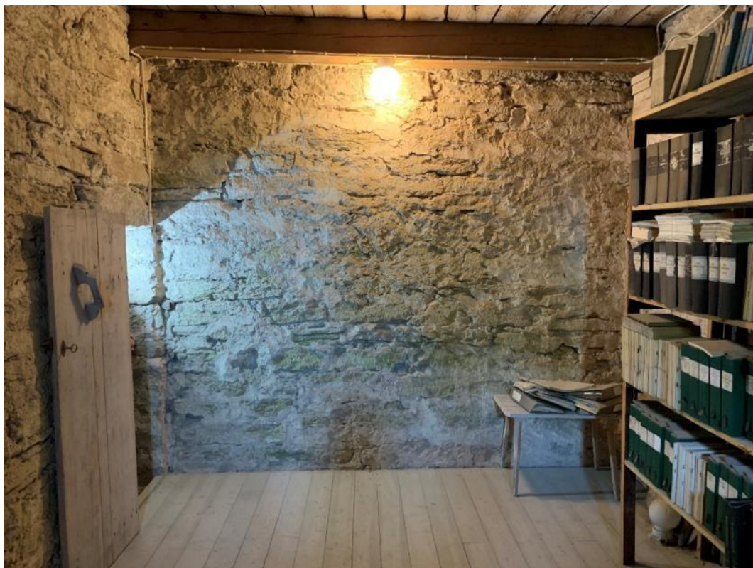
Tornets första övervåning. Interiör mot norr.
