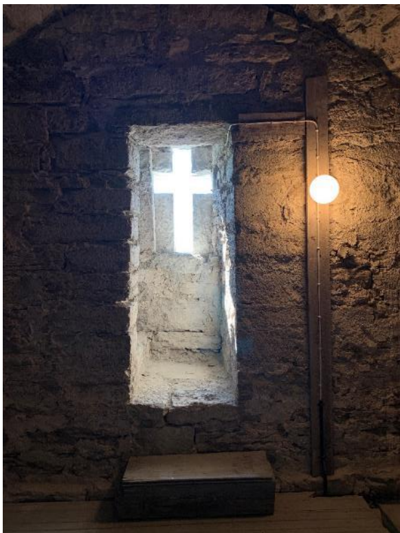
Korsformig ljuslugg till tredje övervåningen. Till höger öppningen med murtrappan synligt. Såväl här som längre ned utmärks trappan av ett murverk med skarpa hörn. Foto JL 2021.
