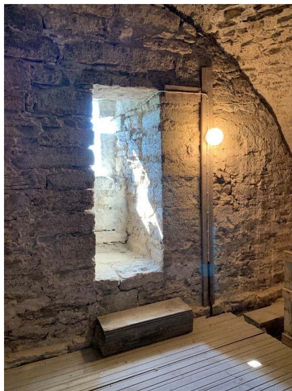
Öppning i övre delen av tornets östra mur i tornets tredje övervåning. Ursprungligen möjligen ljuslugg, igenmurad 1967. Till höger öppning i våningens västra mur till murtrappa förbi valvet. Foto JL 2021.
