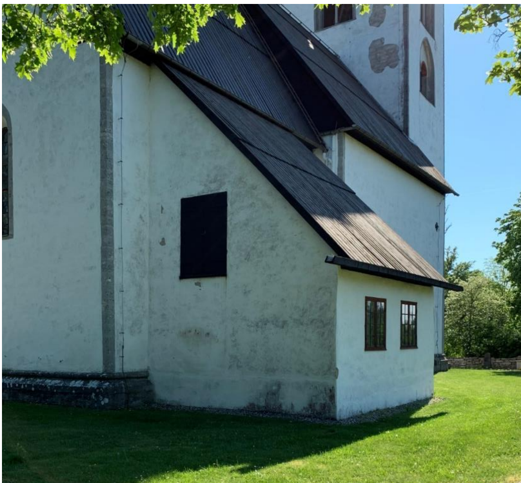
Sakristian från nordöst med rymlig lastport till vinden som troligen inrymt något slags magasin. Uppförd sannolikt under sent 1700-tal eller tidigt 1800-tal. Foto JL 2021.
