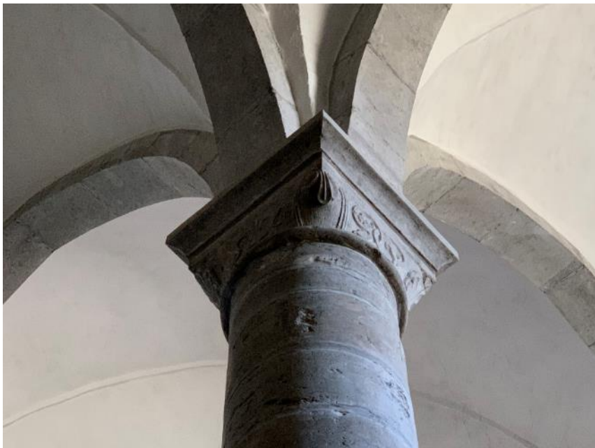
Långhuskolonnens kapital. Till höger valvconsol på långhusets norra mur. Foto JL 2021.
