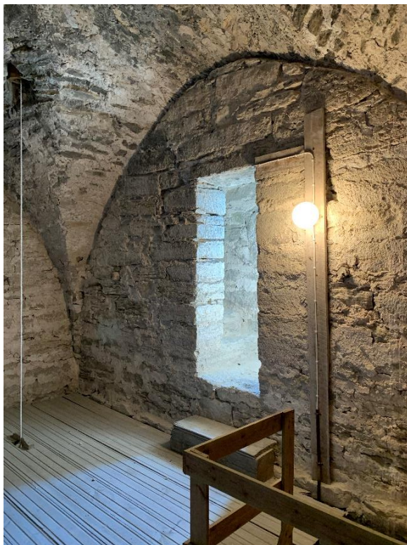
Korsformig ljuslugg till tredje övervåningen. Till höger öppningen med murtrappan synligt. Såväl här som längre ned utmärks trappan av ett murverk med skarpa hörn. Foto JL 2021.
