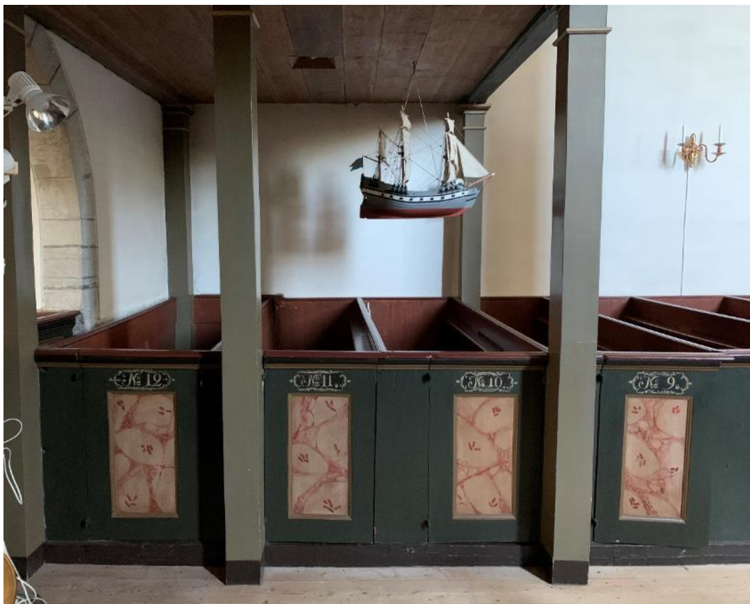
Interiör under läktaren mot norr. Foto JL 2021.
