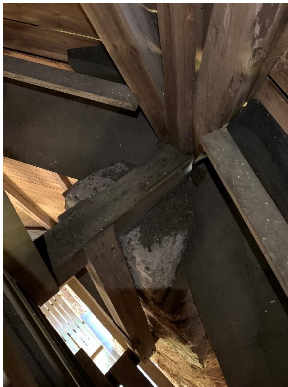
Stegen från klockvåningens golv upp till i höjd med torngavlarnas spetsar. Till höger spirkonstruktionens upplag på en av torngavlarna. Foto JL 2021.
