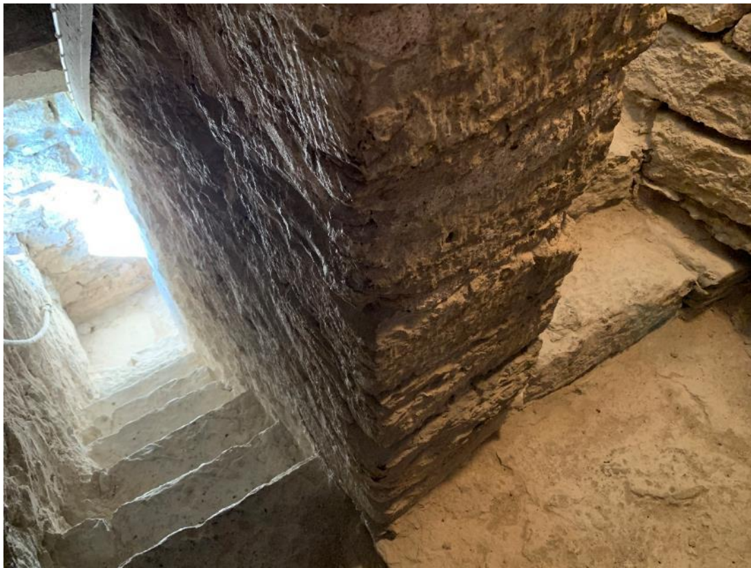
Trappa i tornets sydvästra hörn, förbi valvet mellan tredje övervåningen och den nedre av våningarna med ljudgluggar. Från öppningen vid den korsformade gluggen leds trappan upp till ett vilplan där den viker av tvärt ett halvt varv, kanske för att hejda eld att sprida sig nedåt. Foto JL 2021.
