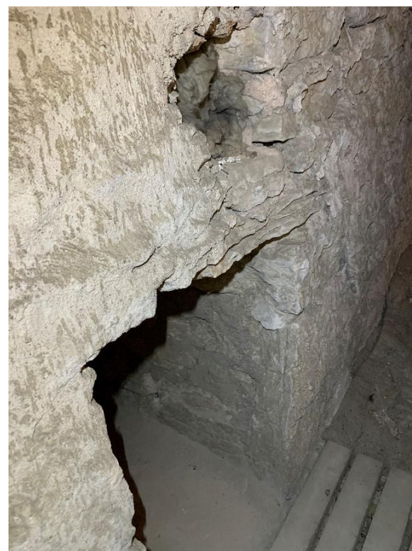
Triumfbågsmuren från långhusvinden med passage till korvinden. Passagens raka sidor visar att den är ursprunglig. Till höger passagen med öppning ovanför, sannolikt efter det äldre långhusets taknock. Foto JL 2021.
