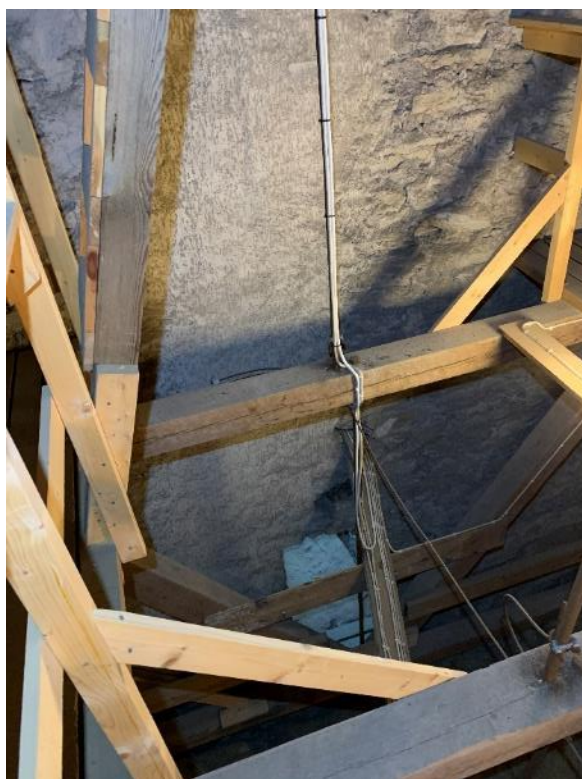
Triumfbågsmuren från långhusvinden med passage till korvinden. Passagens raka sidor visar att den är ursprunglig. Till höger passagen med öppning ovanför, sannolikt efter det äldre långhusets taknock. Foto JL 2021.
