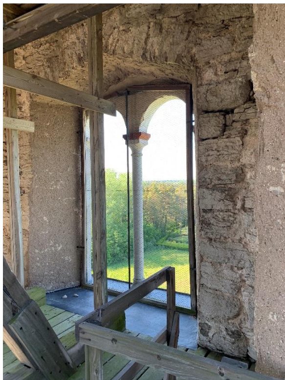
Klockvåningen innanför den mellersta våningen med ljudgluggar, sedd mot norr, med den norra ljudgluggen. Omfattningarna innerdelar förefaller något grövre i de övre än de nedersta ljudgluggarna. Foto JL 2021.
