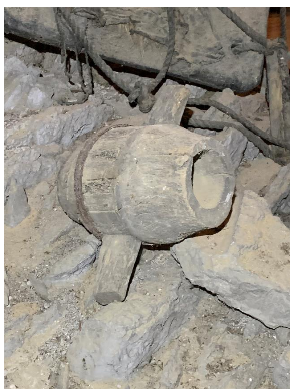
Sturk (träskoning kring hål för lina) i tornvalvet. Till höger vagnshjulsnav (?), troligen använt som tidigare sturk. Foto JL 2021.
