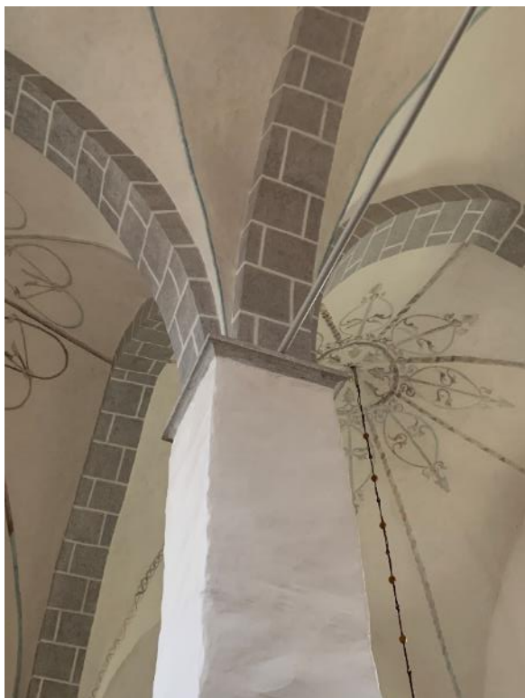
Östra långhuspelarens kapitel sett från nordväst. Till höger sydvästra valvkonsolen samt avsågad bjälke, sannolikt från äldre dragstag. Foto JL 2021.
