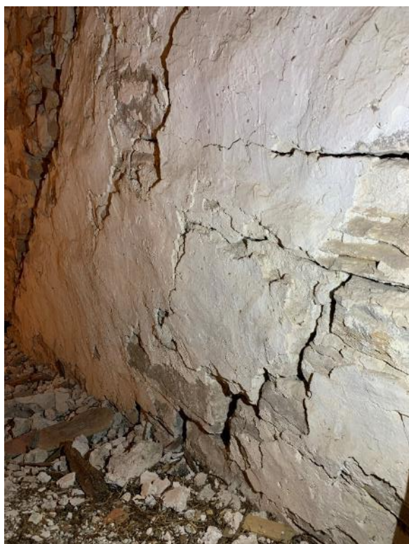
Det äldre långhusets bevarade gavelröste, södra delen med kvarstående puts, sannolikt från 1100-talet eller 1200-talets början, samt avtryck av takfallet. Foto JL 2021.
