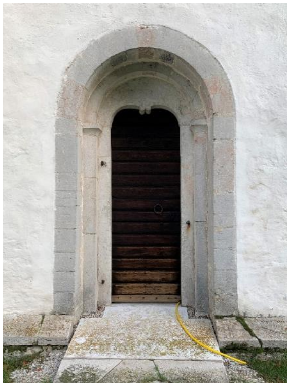
Korportalen. Foto JL 2021 och Einar Erics 1916, ATA. Gångjärnen för en yttre grind har tillkommit efter 1916, på senare tid även ramp utan trappsteg samt slang från avfuktare.
