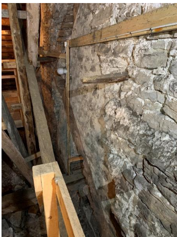
Triumfbågsmuren sedd från långhusmuren mot norr. Långhusets östra mur innesluter korets västra mur, vars putsade yta till stor del är bevarad sedan tiden innan nuvarande långhus kom till. Flera ställningsvirken kvarsitter i långhusgaveln. Foto JL 2021.
