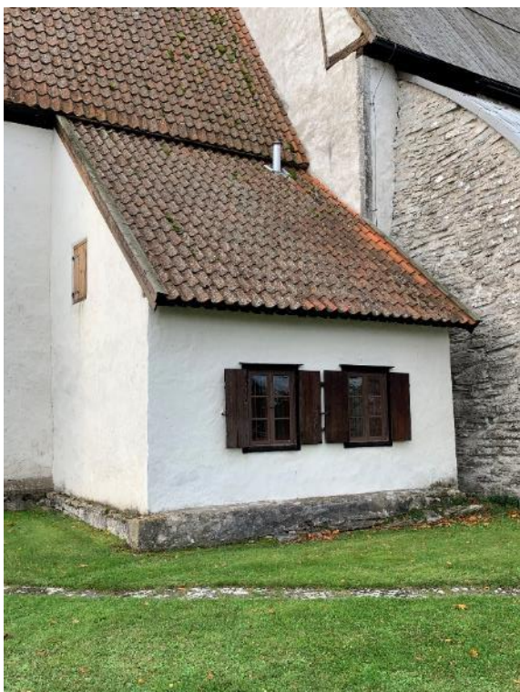
Sakristian från nordöst. Till höger utrymmet mellan sakristian och strävpelaren. Sakristians mur som vetter mot strävpelaren är mer ojämn än de övriga och saknar sockel, vilket talar för att sakristian tillkommit när strävpelaren redan stod på plats och att strävpelaren är äldre. Foto JL2021.
