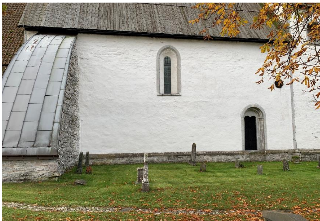
Långhusets norra fasad. Foto JL 2021.
