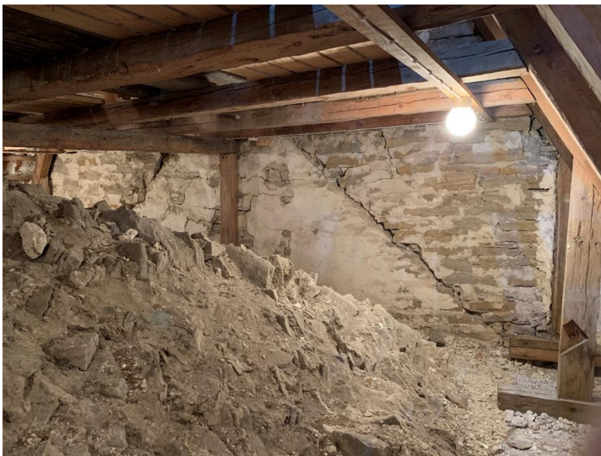
Korvindens nedre del mot väster. I korets västra gavel, triumfbågmuren, ingår i den nedre delen ett äldre långhus östra gavel med ett ovanligt flackt sadeltak. Foto JL 2021.
