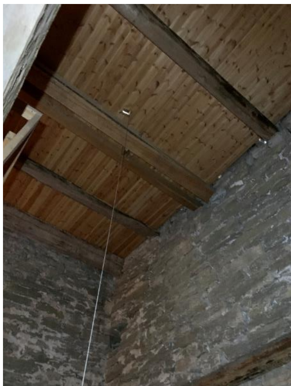
Bjälklaget under klockvåningen, sett mot sydöst från andra övervåningen i tornet genom den tredje. Till höger tornets tredje övervåning mot sydväst. Bjälklaget är endast delvis golvtäckt. Foto JL 2021.
