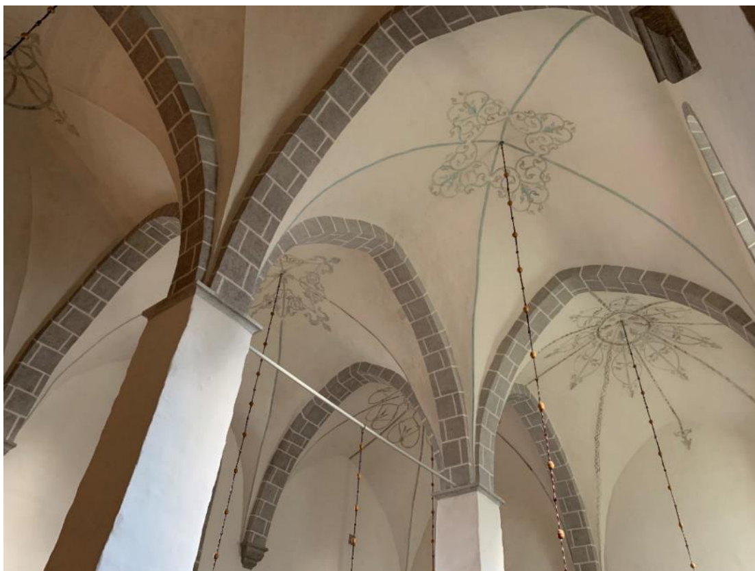
Långhusvalven sedda underifrån mot nordöst. Foto JL 2021.
