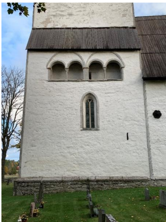
Tornets nedre del från söder. Till höger skarven mellan långhuset och dess hörnkedja till höger och tornmuren till vänster med glugg till torntrappan. Foto JL 2021.
