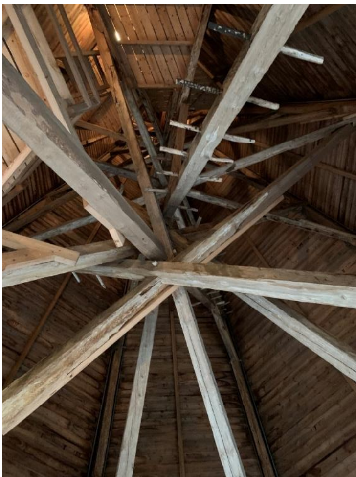
Tornhuvens inre konstruktion sedd underifrån. Foto JL 2021.
