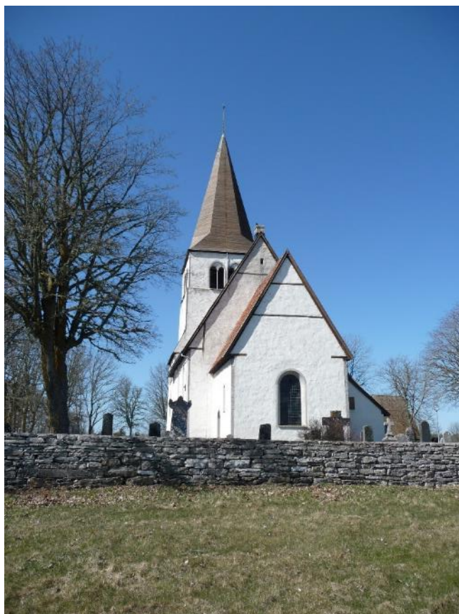
Den östra mursträckningen. Foto ES 2021.
