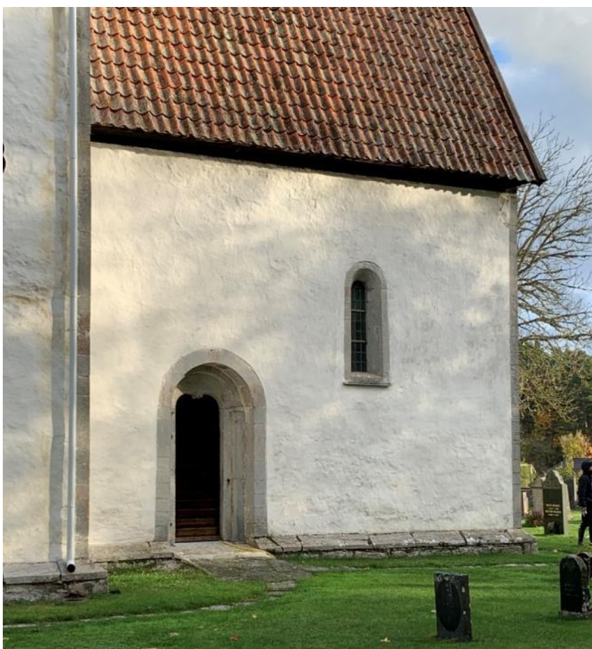
Korets södra fasad. Foto JL 2021.
