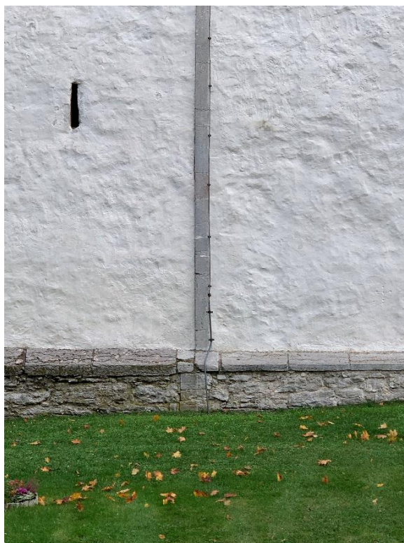
Tornets nedre del från söder. Till höger skarven mellan långhuset och dess hörnkedja till höger och tornmuren till vänster med glugg till torntrappan. Foto JL 2021.
