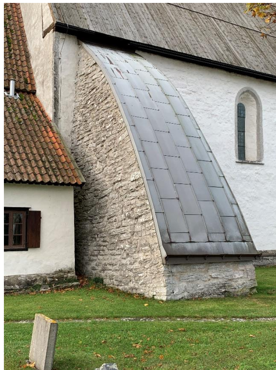
Övre delen av långhusets nordöstra hörn, synlig mellan sakristian och strävpelaren. Hörnkedjans nedre del saknas eller är överputsad. Till höger strävpelaren från nordöst. Foto JL 2021.
