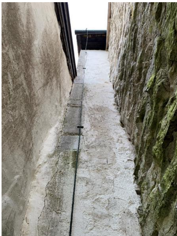
Övre delen av långhusets nordöstra hörn, synlig mellan sakristian och strävpelaren. Hörnkedjans nedre del saknas eller är överputsad. Till höger strävpelaren från nordöst. Foto JL 2021.
