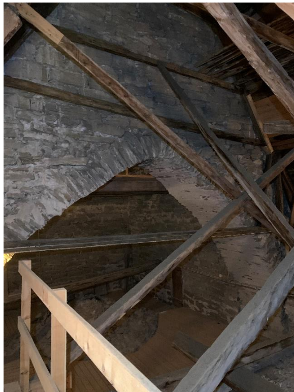
Blick från tornets första övervåning mot långhusvinden i öster. Till höger blick från långhusvinden mot tornets första övervåning i väster. Den vida bågen bär tornets östra mur. Foto JL 2021.
