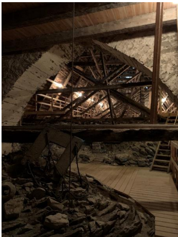
Blick från tornets första övervåning mot långhusvinden i öster. Till höger blick från långhusvinden mot tornets första övervåning i väster. Den vida bågen bär tornets östra mur. Foto JL 2021.
