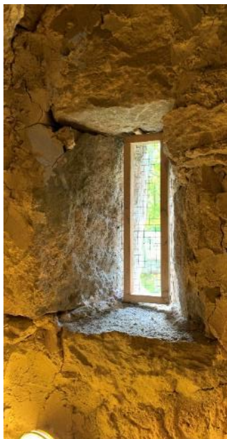
Ljuslugg i murtrappans nedre del. Till höger detalj av spiraltrappans trappsteg strax ovanför ljusluggen med urtag i ett av stegen, sannolikt för att sprida ljuset från öppningen. Foto JL 2021.
