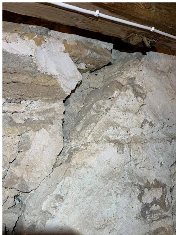
Det äldre långhusets bevarade gavelröste, södra delen med kvarstående puts, sannolikt från 1100-talet eller 1200-talets början, samt avtryck av takfallet. Foto JL 2021.
