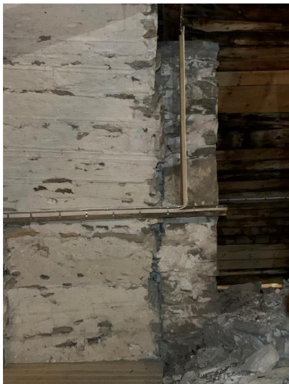
Bågöppningens norra och södra sidor med tunn mur ovanför långhusets västra gavel, det är antingen rest av tidigare långhusgavel eller ett senare tillkommet stöd för del av takstolen. Foto JL 2021.
