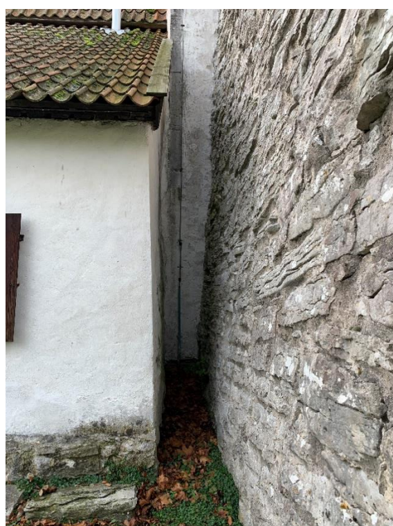
Sakristian från nordöst. Till höger utrymmet mellan sakristian och strävpelaren. Sakristians mur som vetter mot strävpelaren är mer ojämn än de övriga och saknar sockel, vilket talar för att sakristian tillkommit när strävpelaren redan stod på plats och att strävpelaren är äldre. Foto JL2021.
