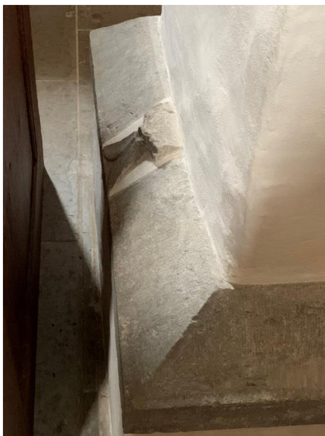
Skadad huggstensdetalj på östra pelarbasens västra sida. Till höger långhusets pelare. Foto JL 2021.
