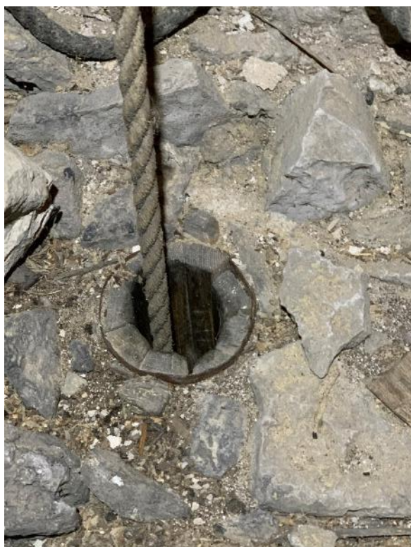
Sturk (träskoning kring hål för lina) i tornvalvet. Till höger vagnshjulsnav (?), troligen använt som tidigare sturk. Foto JL 2021.
