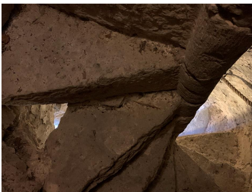
Ljuslugg i murtrappans nedre del. Till höger detalj av spiraltrappans trappsteg strax ovanför ljusluggen med urtag i ett av stegen, sannolikt för att sprida ljuset från öppningen. Foto JL 2021.
