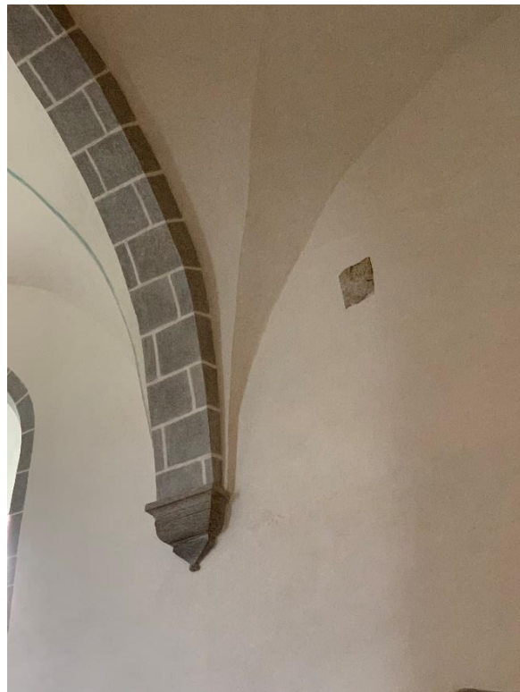
Östra långhuspelarens kapitel sett från nordväst. Till höger sydvästra valvkonsolen samt avsågad bjälke, sannolikt från äldre dragstag. Foto JL 2021.
