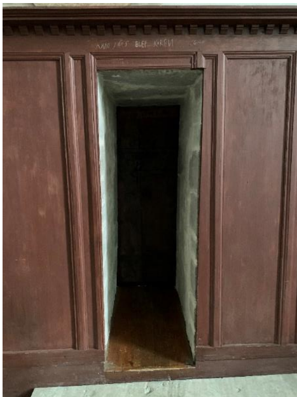
Ingång till sakristian från koret, upptagen i panel, daterad 1605. Till höger passagen genom muren, med huggen sten, samt sannolikt medeltida dörr i fonden. Foto JL 2021.
