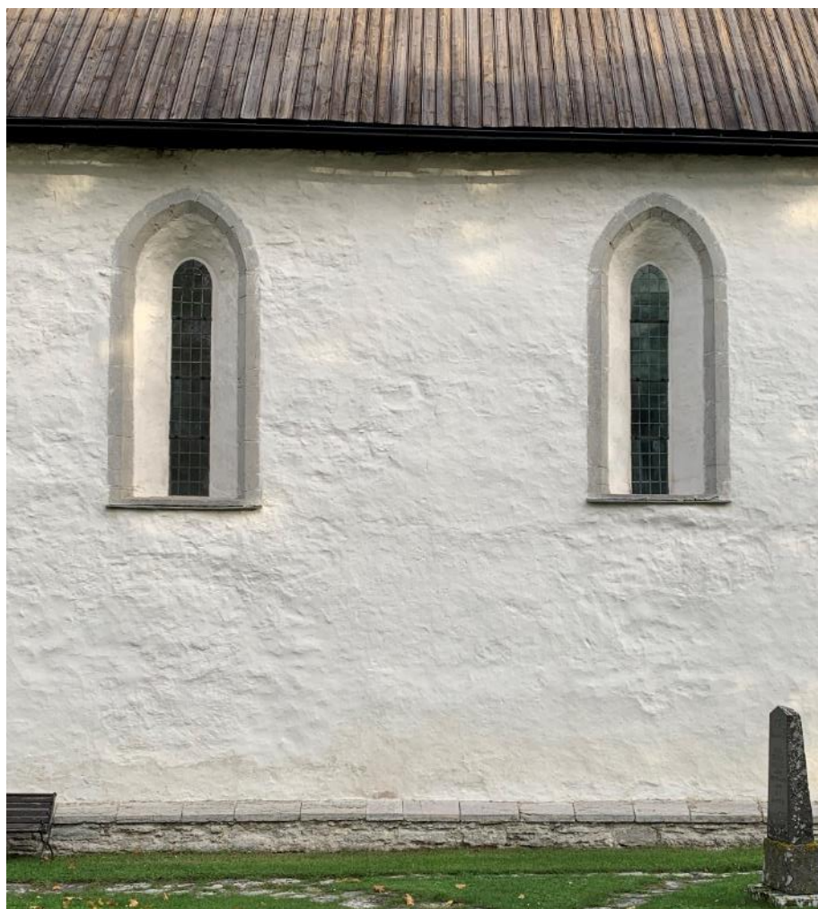
Södra långhusfasadens fönster. Foto JL 2021.
