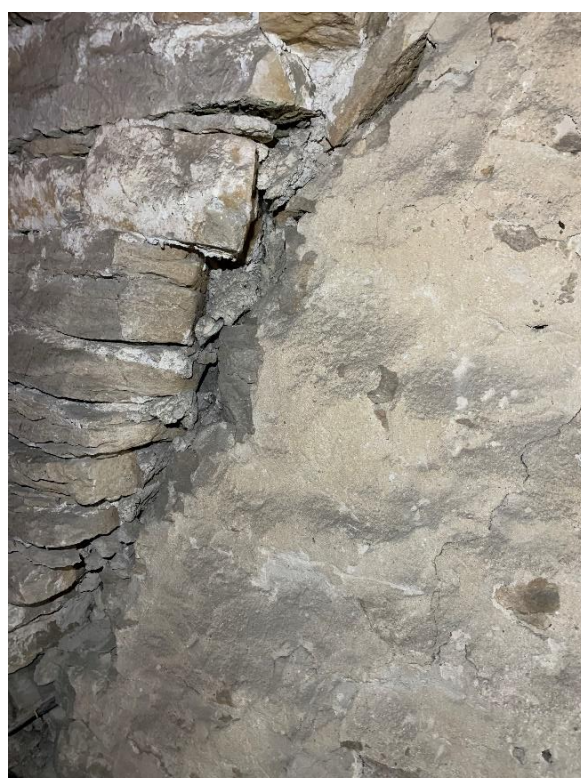
Triumfbågsmuren sedd från långhusmuren mot norr. Långhusets östra mur innesluter korets västra mur, vars putsade yta till stor del är bevarad sedan tiden innan nuvarande långhus kom till. Flera ställningsvirken kvarsitter i långhusgaveln. Foto JL 2021.
