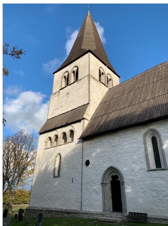
Tornets nedre del från söder. Till höger skarven mellan långhuset och dess hörnkedja till höger och tornmuren till vänster med glugg till torntrappan. Foto JL 2021.
