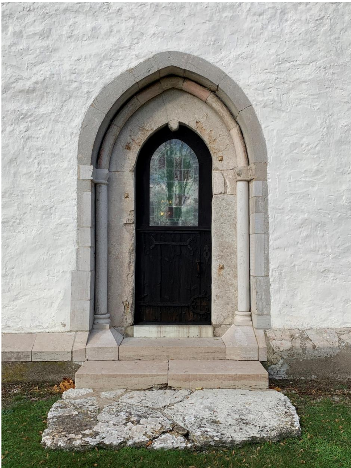
Långhusportalen. Omfattningen har skador, sannolikt från branden 1676. Dörrbladets järnbeslag som efterbildar medeltida former är yngre. Den övre delen omgjord till fönster, vars nuvarande form sannolikt tillkom 1946-47. Foto JL 2021.
