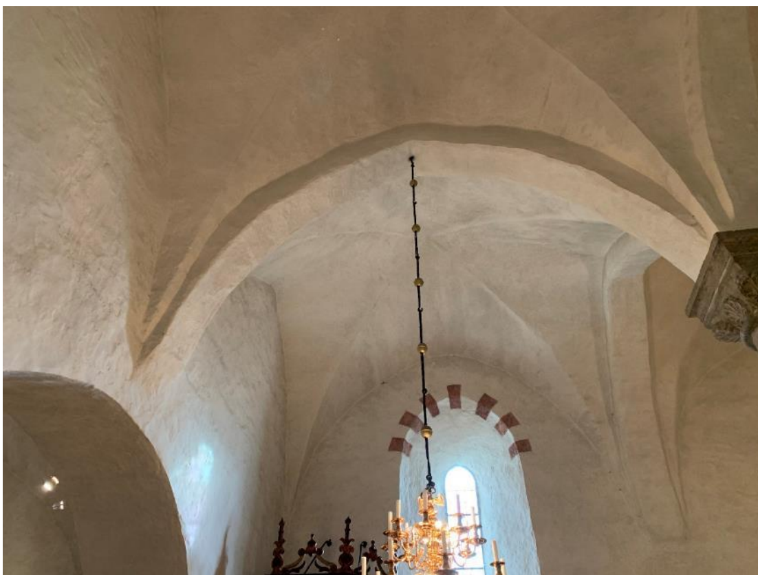
Långhusvalven mot sydöst. Foto JL 2021.
