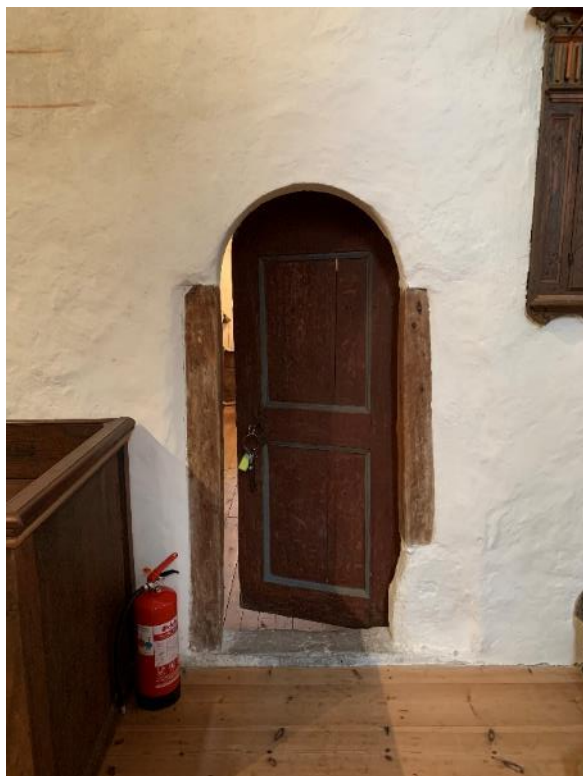
Ingången till sakristian. De båda posterna av trä kan vara ersättning för brandskadade poster och talar då för att sakristian är medeltida men omgjord senare. Till höger interiör av sakristian mot norr. Bakom skåpen döljer sig en ingång utifrån, upptagen på 1800-talet, kanske att sakristian användes för skriftermål samt skol- och konfirmandundervisning. Foto JL 2021.
