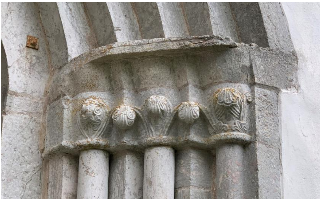
Västportalens södra kapitälband. Foto JL 2021.
