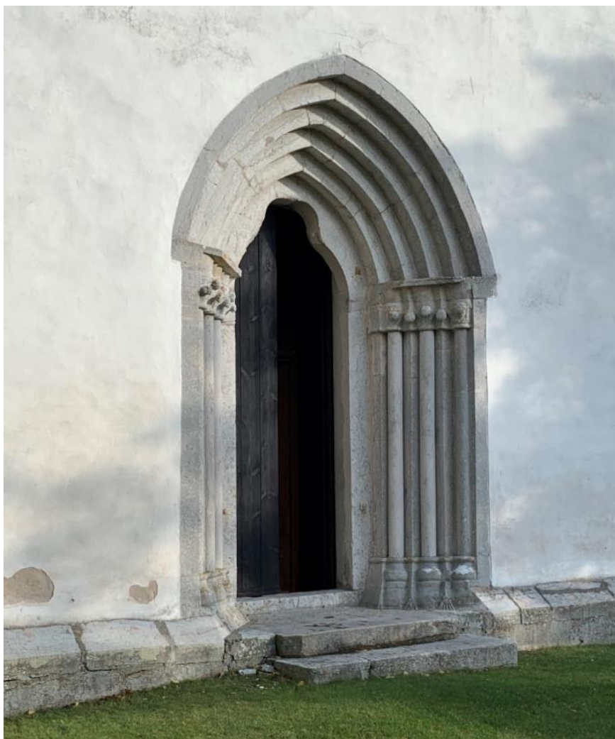
Västportalen sedd från nordväst. Foto JL 2021.
