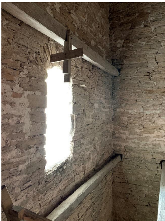
Lastport i tornets västra mur. Foto JL 2021.
