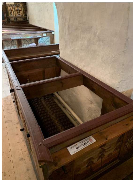
Tornbågens vederlag på norra och södra sidan, sedda mot nordväst respektive sydöst. Bänkrummen sedan 1946-47 använda för dolda radiatorer. På den norra sidan skjuter en klack ut som antyder att tornbågen kan ha vidgats och ursprungligen ha varit smalare. Foto JL 2021.
