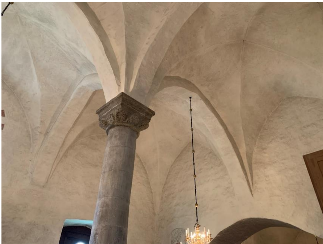
Långhusvalven mot sydöst. Foto JL 2021.
