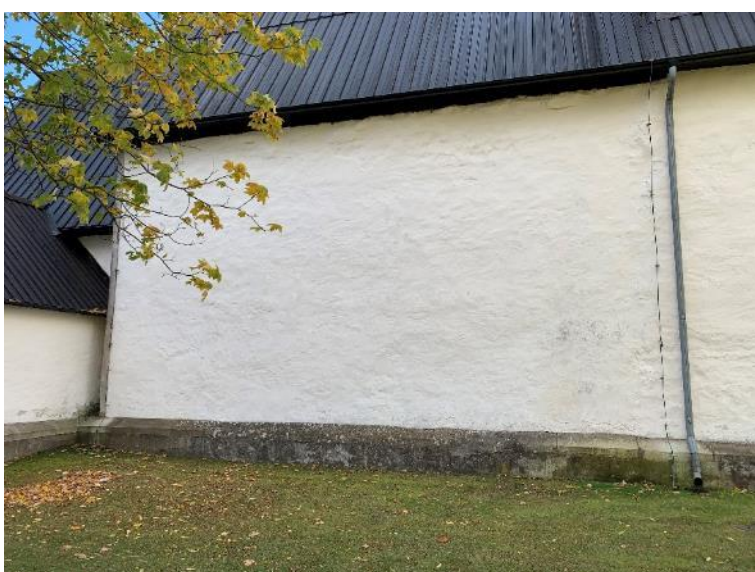
Långhusets nordfasad. Foto JL 2021.
