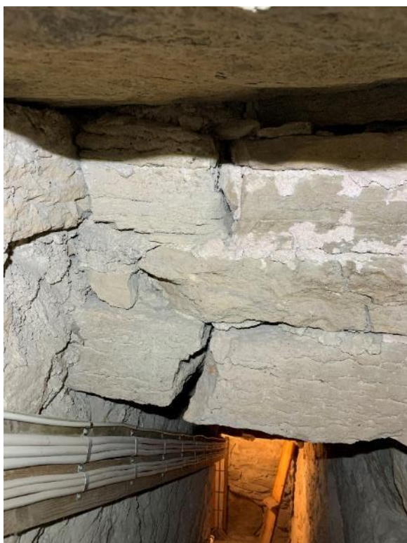
Del av murtrappans tak sett mot öster. Sprickorna härrör sannolikt från sättningar efter 1676 års brand. Till höger murtrappans mynning i första tornövervåningens sydvästra hörn. Foto JL 2021.
