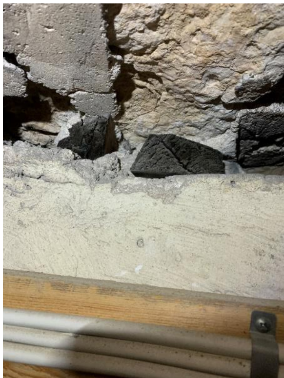
Gångöppningen från tornet till långhusvinden. Sedan branden 1676 brända stycken, sannolikt av en ursprunglig träavtäckning. Brädan för elledning troligen från 1983 eller 1996. Till höger gångöppningen sedd från långhusvinden. Foto JL 2021.
