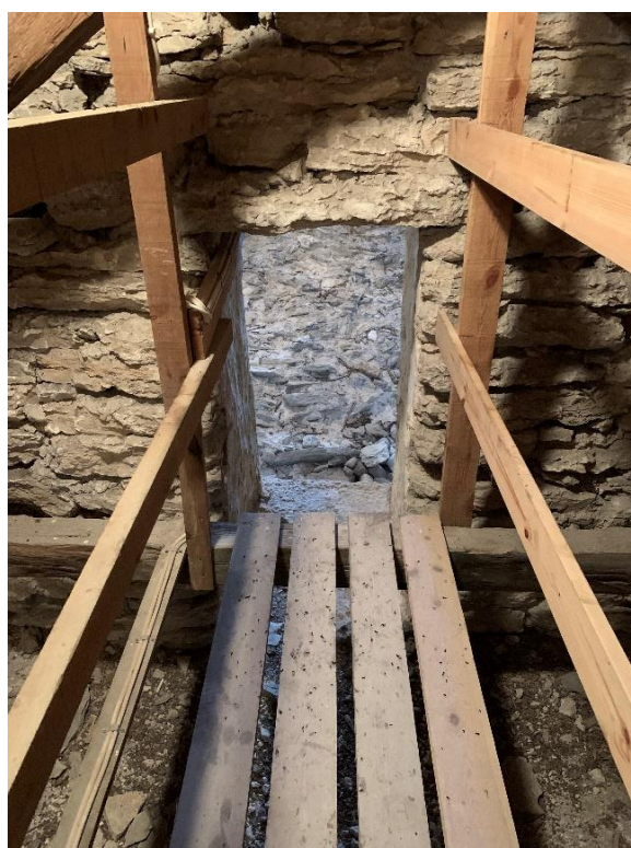
Gångöppningen från tornet till långhusvinden. Sedan branden 1676 brända stycken, sannolikt av en ursprunglig träavtäckning. Brädan för elledning troligen från 1983 eller 1996. Till höger gångöppningen sedd från långhusvinden. Foto JL 2021.
