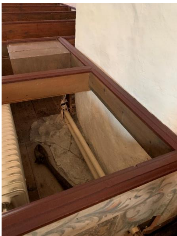
Tornbågens vederlag på norra och södra sidan, sedda mot nordväst respektive sydöst. Bänkrummen sedan 1946-47 använda för dolda radiatorer. På den norra sidan skjuter en klack ut som antyder att tornbågen kan ha vidgats och ursprungligen ha varit smalare. Foto JL 2021.
