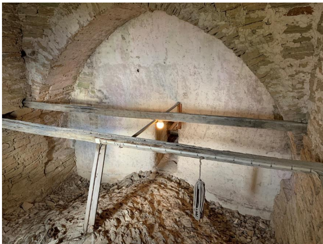
Tornets första övervåning mot nordöst. Muren i fonden utgör ett stycke av långhusets ursprungliga västra gavelmur. Putsen, som fortsätter in bakom tornets murverk, är äldre än tornet och visar att tornet är en senare tillbyggnad och att kyrkan även i sitt äldsta skick var putsad. Linjerna strax ovanför valvets sidor markerar sannolikt nivån på svicklarnas fyllning före 1998. Foto JL 2021.
