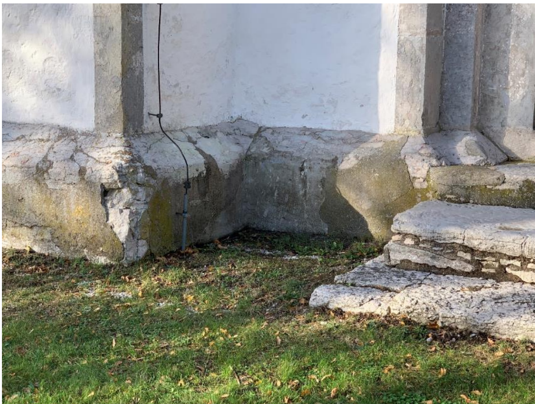
Sockeln i södra hörnet mellan långhus och kor. Sockeln och portalerna visar skador, sannolikt från branden 1676. Foto JL 2021.
