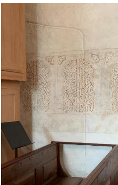
Igenmurad portal på långhusets norra sida. Foto JL 2021. Till höger den nyupptäckta portalen och de nyframtagna kalkmålningarna. På igenmurningen återfinns inte bara kalkmålningarna av 1500-talstyp utan även rester av draperimålningar, sannolikt från Passionsmästarens målningar från 1400-talets mitt, vilket visar att portalen murades igen redan på medeltiden. Foto Alfred Edle 1946, ATA.
