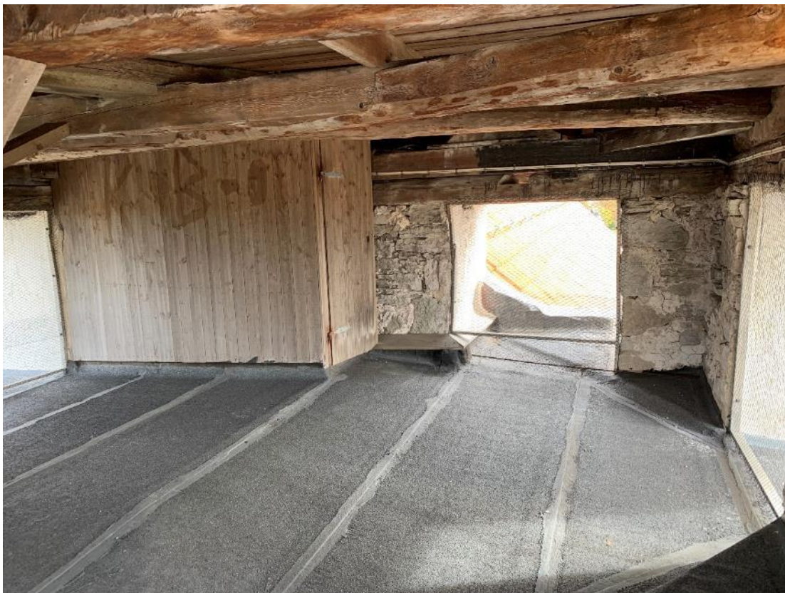
Klockvåningen mot öster, vars ljudgluggar före taksänkningen 1857 vette in mot långhusvinden. Den norra ljudgluggen inbyggd för trappmynnings skull. Foto JL 2021.
