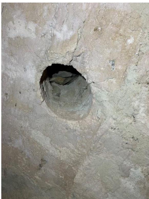
Hål för klocklina i valvet mellan tornets tredje övervåning och klockvåningen. Till höger trapploppet från tornets tredje övervåning till klockvåningen, nordöstra hörnet. Foto JL 2021.
