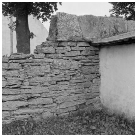
Den västra mursträckningen med diagonalställda täckhällar. Foto Sören Hallgren 1965. RAÄ, Kulturmiljöbild.
