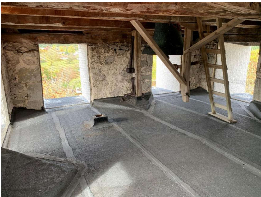
Klockvåningen mot väster. Foto JL 2021.
