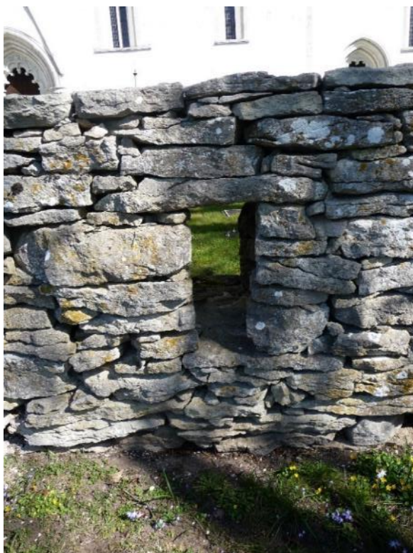
Skytteglugg i den södra mursträckningen. Muren har en gång tidigare rasat och blivit återuppbyggd. Foto ES 2021.
