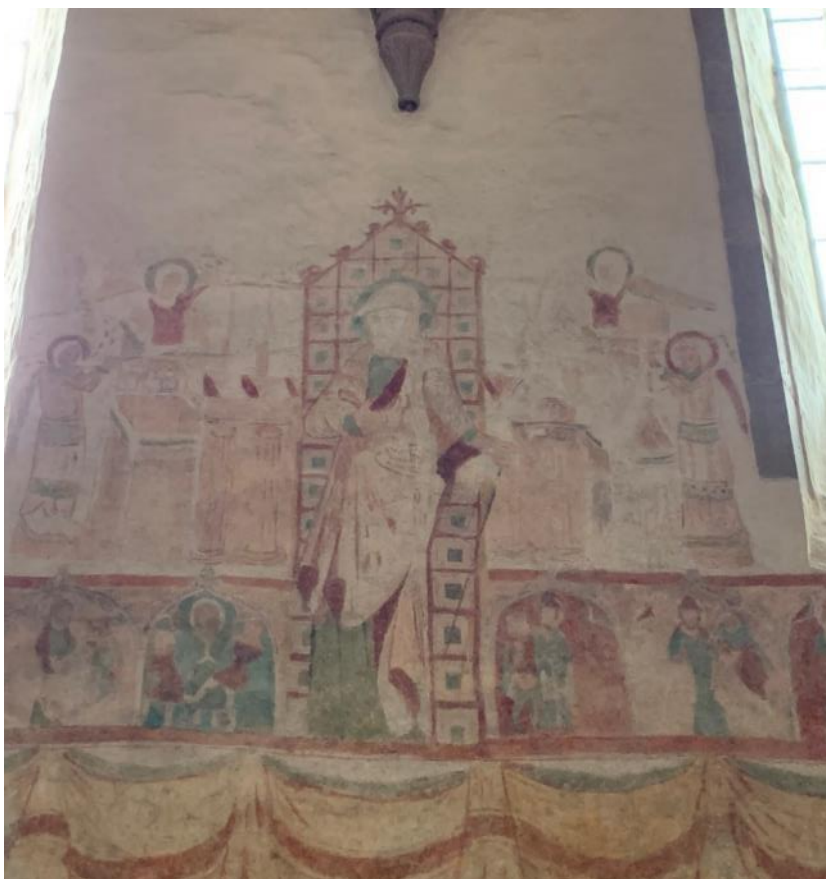
Kalkmålningar mellan fönstren på långhusets södra mur. Foto JL 2021.
