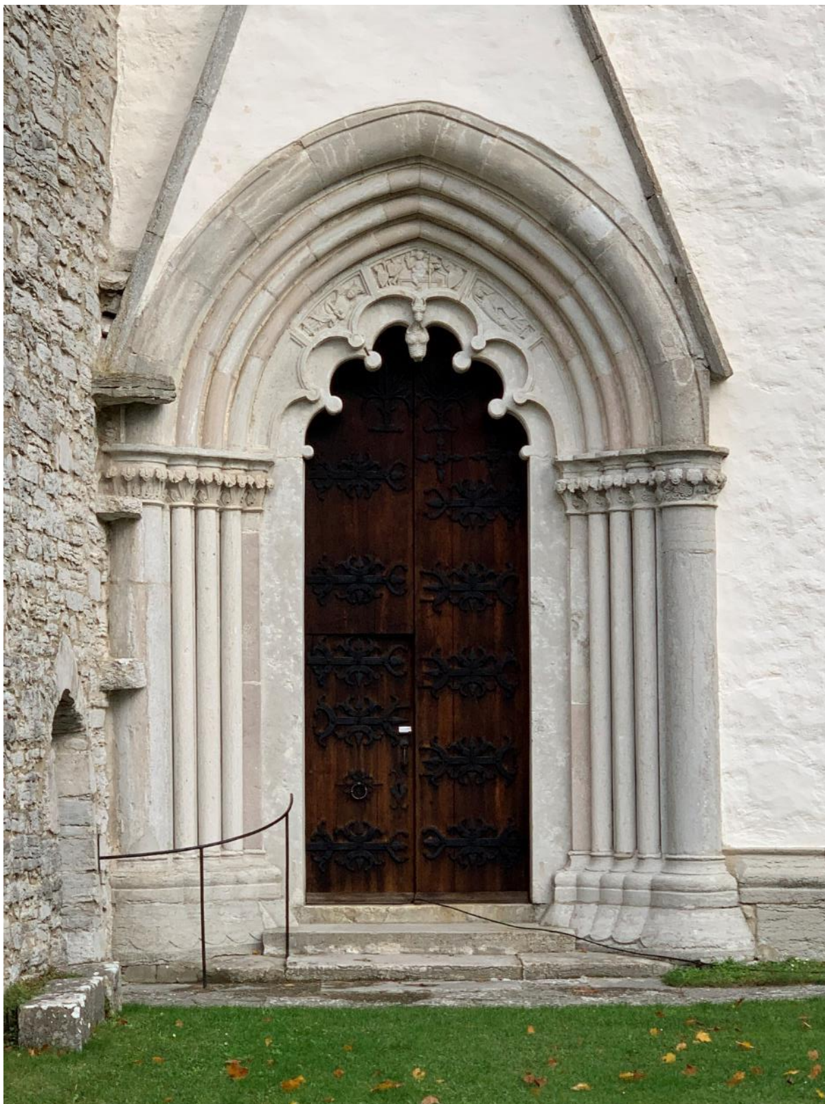
Långhuset's sydportal. Foto JL 2021.
