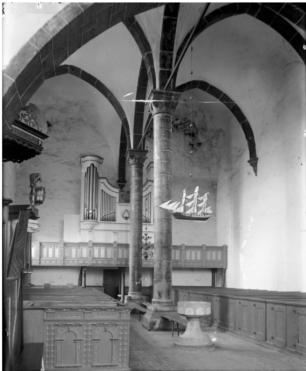
Interiör mot väster, troligen omkring 1890. Bänkinredningen omgrupperad och övermålad, troligen vid restaureringen 1857-58, varvid sannolikt även kolonner och bågar målades. Läktaren från 1863 bär den år 1870 från Franska reformerta kyrkan i Stockholm inköpta orgeln. Foto Olof Sörling, ATA.
