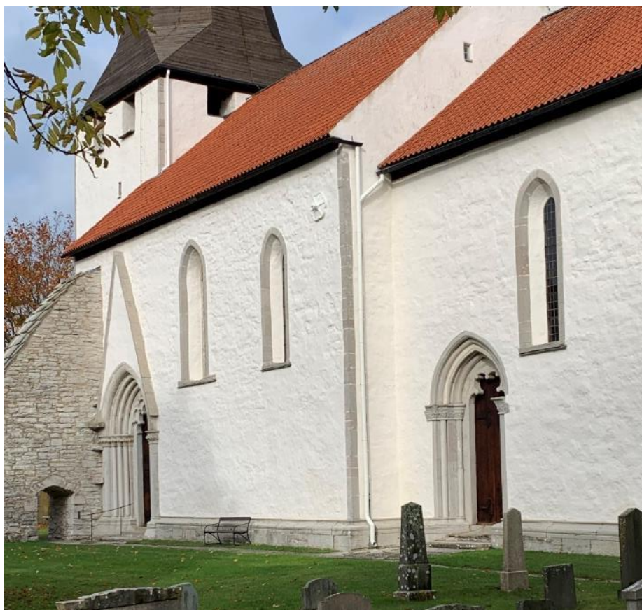
Sydfasaden sedd från sydöst. Foto JL 2021.
