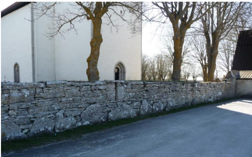
Den västra mursträckningen. Foto ES 2021.
