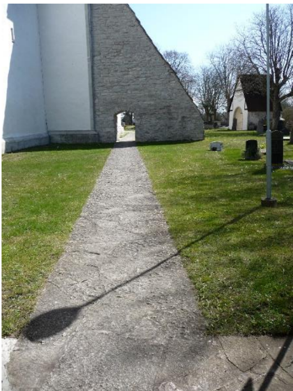
Huvudgången från den västra stigluckan mot öster. Foto ES 2021.
