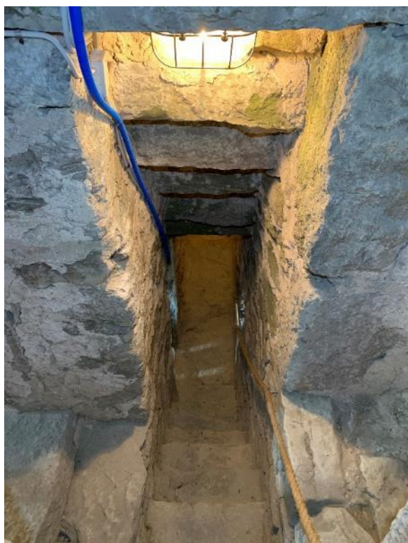
Trappan i norra muren sedd mot väster med i förgrunden öppningar till tredje övervåningen och porten i norra muren. Till höger blick från tornets tredje övervåning mot porten i norra muren, som möjligen kan ha fungerat som lastport. Öppningen in till våningen har uttag för en dörr försedd med lås. Foto JL 2021.
