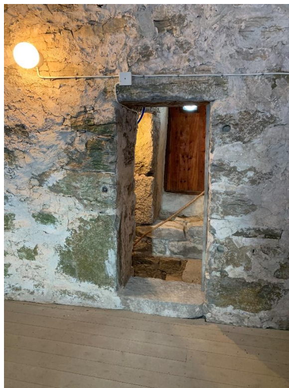
Trappan i norra muren sedd mot väster med i förgrunden öppningar till tredje övervåningen och porten i norra muren. Till höger blick från tornets tredje övervåning mot porten i norra muren, som möjligen kan ha fungerat som lastport. Öppningen in till våningen har uttag för en dörr försedd med lås. Foto JL 2021.
