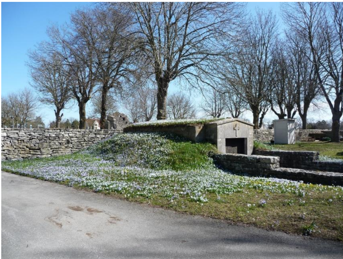
Gravkapell i den norra delen av den yngre kyrkogården uppfört 1947. Kapellet är övertäckt med en jordkulle som har en rik vårflora. Foto ES 2021.
