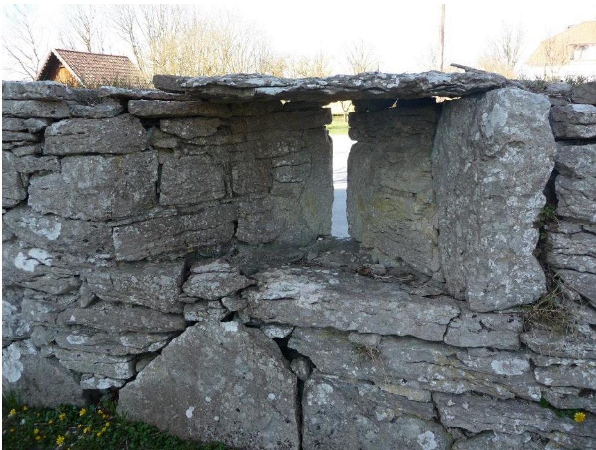
Skytteglugg i den västra mursträckningen fotograferad från öster. Innanför skyttegluggen finns en nisch. Foto ES 2021.
