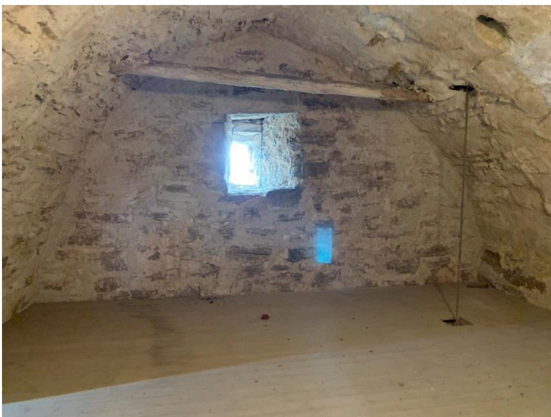
Tornets tredje övervåning mot söder. Foto JL 2021.
