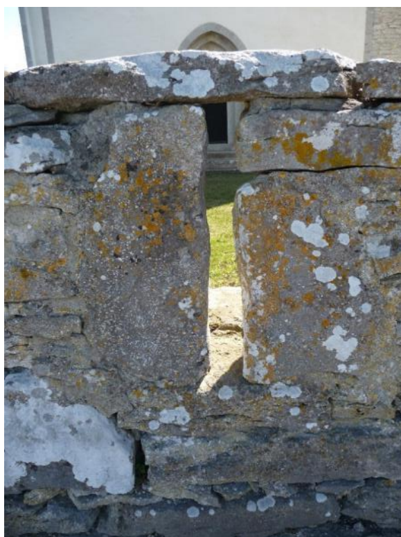
Skytteglugg i den västra mursträckningen fotograferad från väster. Foto ES 2021.
