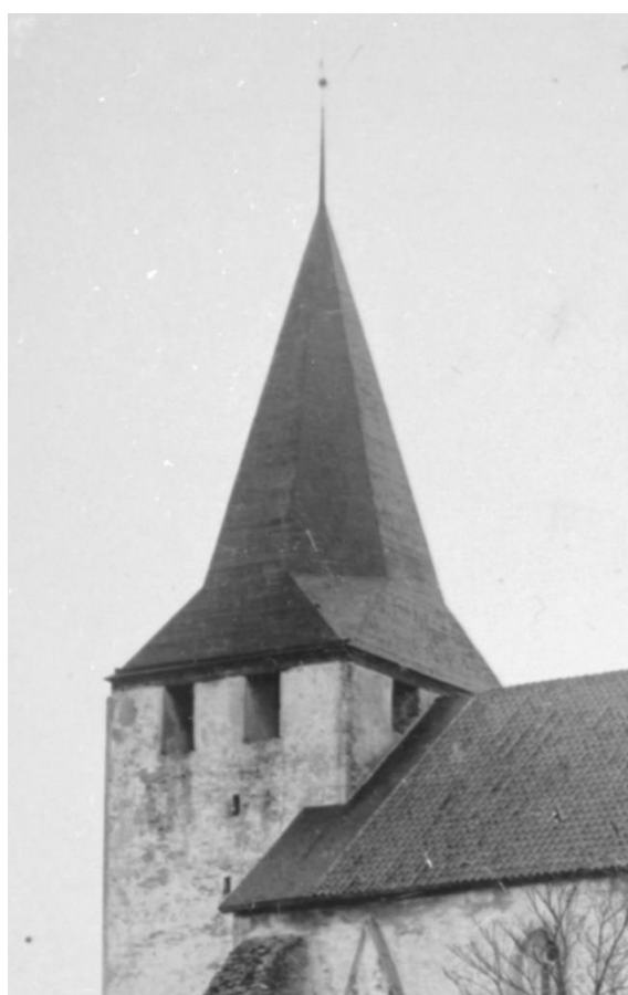
Tornhuven före och efter ombyggnaden 1897. Förstoringar av närmast föregående bilder. Svicklarna i hörnen gavs en lägre lutning, tornhuvens remstycke frilades och möjligen blev huven något lägre.
