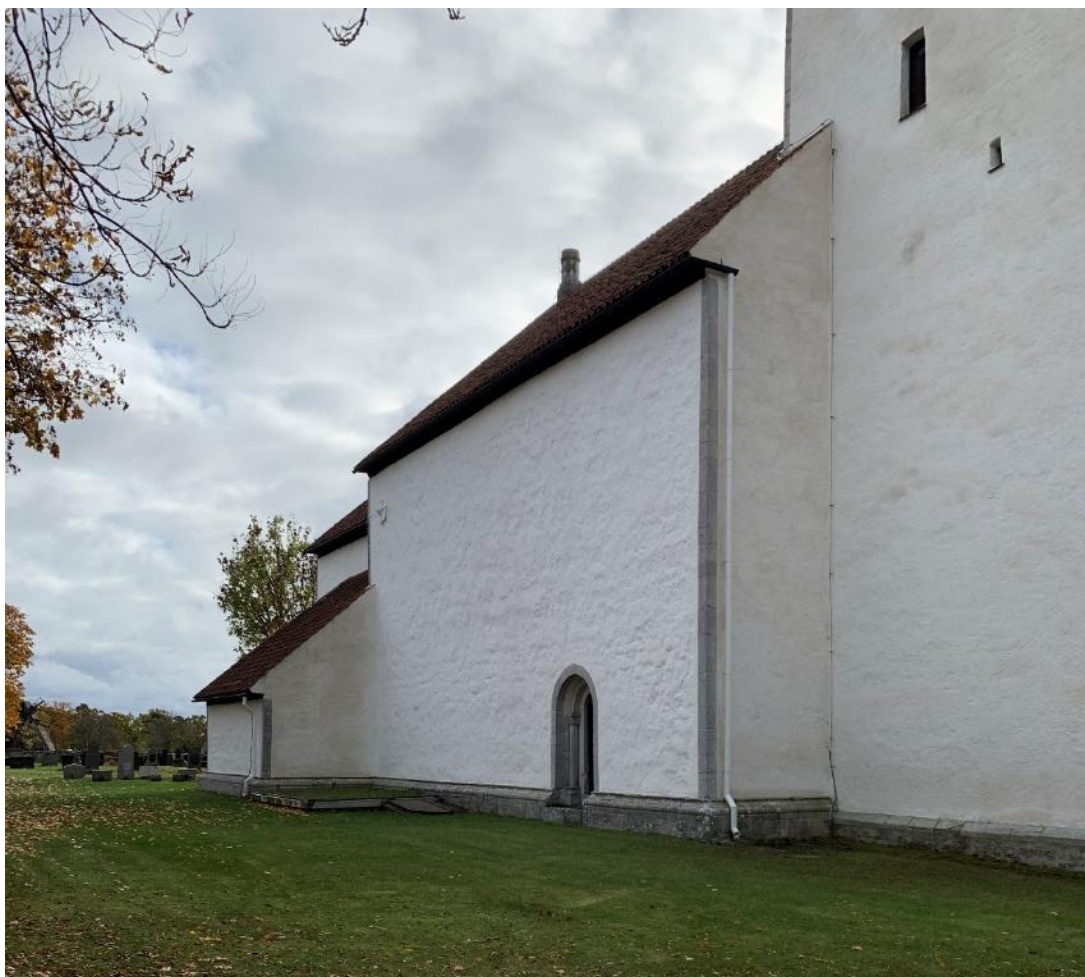
Långhusets norra fasad, sedd från nordväst. Foto JL 2021.
