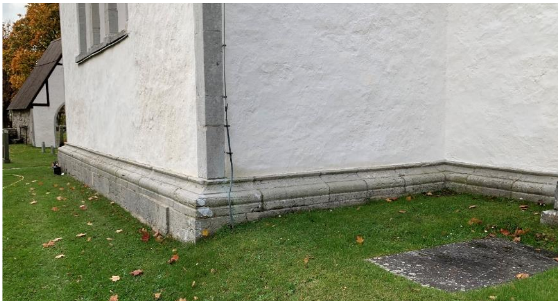
Sockeln i korets nordöstra hörn och i hörnet vid sakristian. Foto JL 2021.
