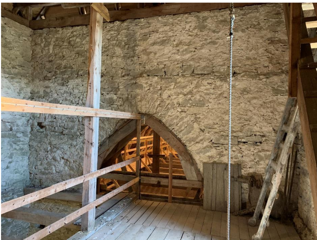
Tornets andra övervåning mot öster. Foto JL 2021.
