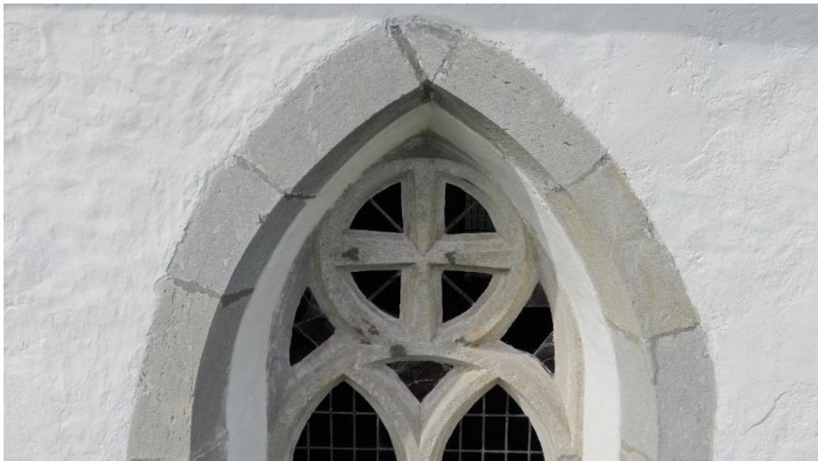
Södra långhusfönstrets Masverk, hugget i ett stycke. Foto Pär Malmros 2021, Visby stift.
