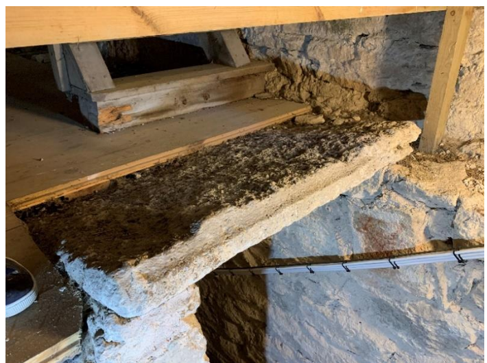
Murtrappans mynning i tornets första övervåning. Till höger trappmynningens täcksten, vars profil och inhuggna kors visar att den utgjort skiva till altare, sannolikt ett sidoaltare. Foto JL 2021.
