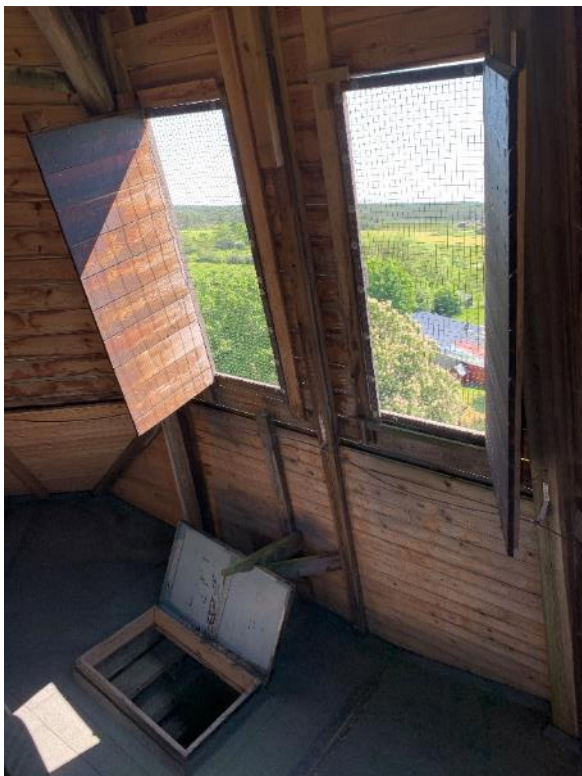
Klockvåningen i tornhuven sedd mot söder och väster. Före 2013-14 fanns luckförsedda ljudgluggar även mot tornets hörn, nu ersatta av panel och utvändiga blindgluggar. Foto JL 2021.
