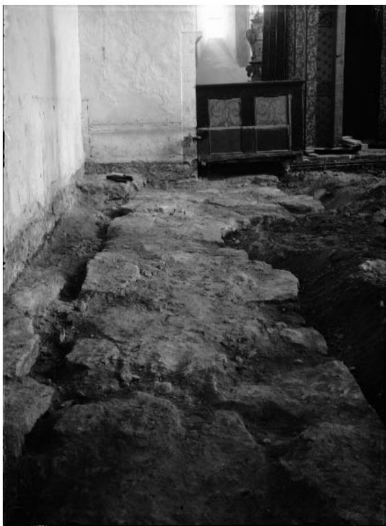
Grundmurar till det äldre långhuset, frilagda under restaureringen 1925-26, ovan norra och södra muren mot öster, nedan södra muren mot sydväst. Triumfbågsmuren synes tidigare ha legat väster om nuvarande triumfbågen. Foto Alfred Edle 1926 (oriktigt daterade 1932), ATA.
