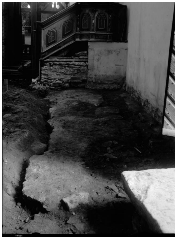
Grundmurar till det äldre långhuset, frilagda under restaureringen 1925-26, ovan norra och södra muren mot öster, nedan södra muren mot sydväst. Triumfbågsmuren synes tidigare ha legat väster om nuvarande triumfbågen. Foto Alfred Edle 1926 (oriktigt daterade 1932), ATA.
