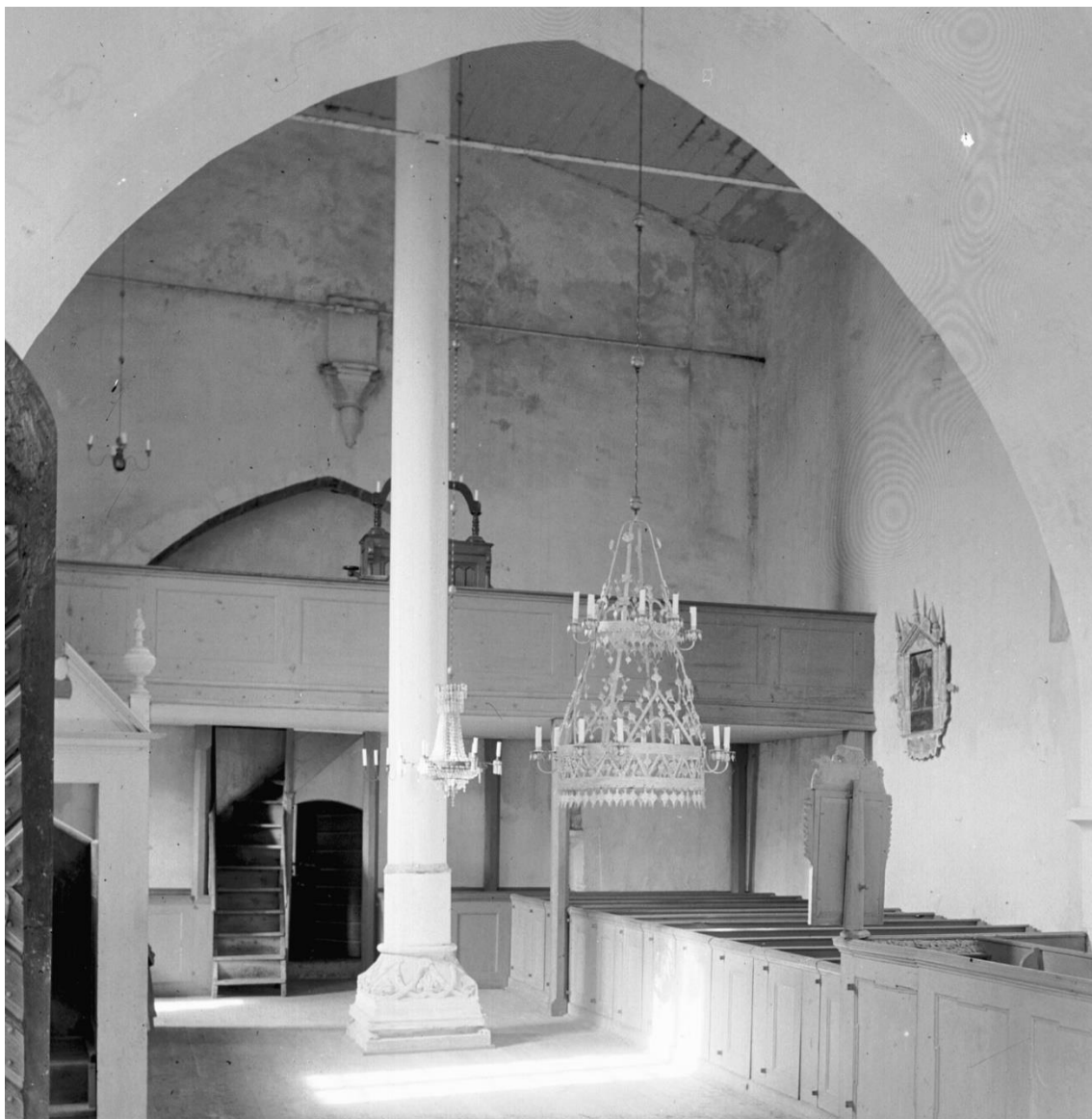
Interiör mot väster före restaureringen 1925-26. Nedan förstoring. Bilden visar det flacka trätunnvalv som på 1860-talet ersatte de rasade murade valven. Mittkolonnen är av trä. Läktaren tillkom vid samma tid liksom väggen i tornbågen. Läktaren ersatte en äldre, men att bänkinredningen och predikstolen bibehölls tyder på att valvraset främst drabbade långhusets västra del. Foto Anders Roland 1925, ATA.
