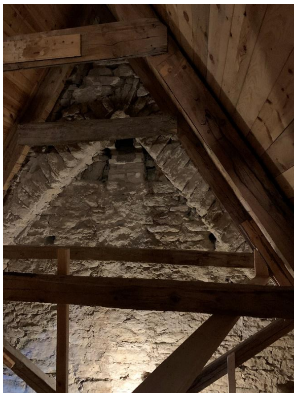
Passagen genom triumfbågsmuren, sedd från korets vind. Till höger triumfbågsmurens östra sida. Påmurningen visar att korets takvinkel ursprungligen var något lägre. Foto JL 2021.
