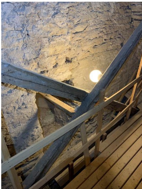
Passagen genom triumfbågsmuren, sedd från korets vind. Till höger triumfbågsmurens östra sida. Påmurningen visar att korets takvinkel ursprungligen var något lägre. Foto JL 2021.
