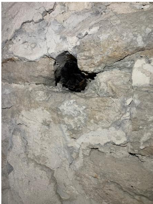
Avbränt ställningsvirke i triumfbågs-muren, kanske från den eldsvåda 1695, som omtalas på kyrkklockan. Till höger en av flera inskrifter på takstolen, denna från 1702 berättar om takbygge, kanske efter branden. Foto JL 2021.
