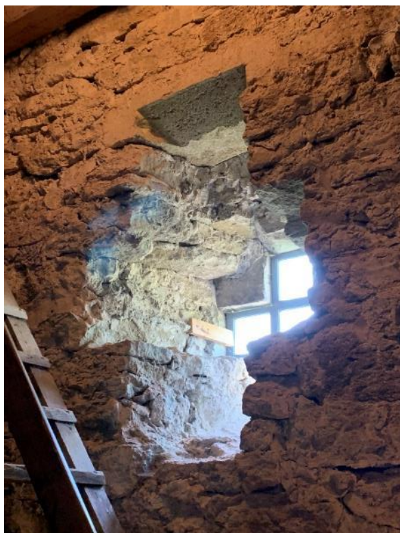
Korsformig glugg i tornets västra mur. De huggna stenarna kommer möjligen från en äldre korsformad öppning. Foto JL 2021.
