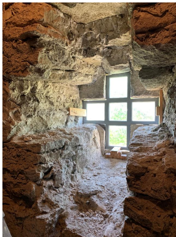
Korsformig glugg i tornets västra mur. De huggna stenarna kommer möjligen från en äldre korsformad öppning. Foto JL 2021.
