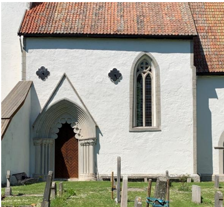
Långhusets södra fasad. Foto JL 2021.
