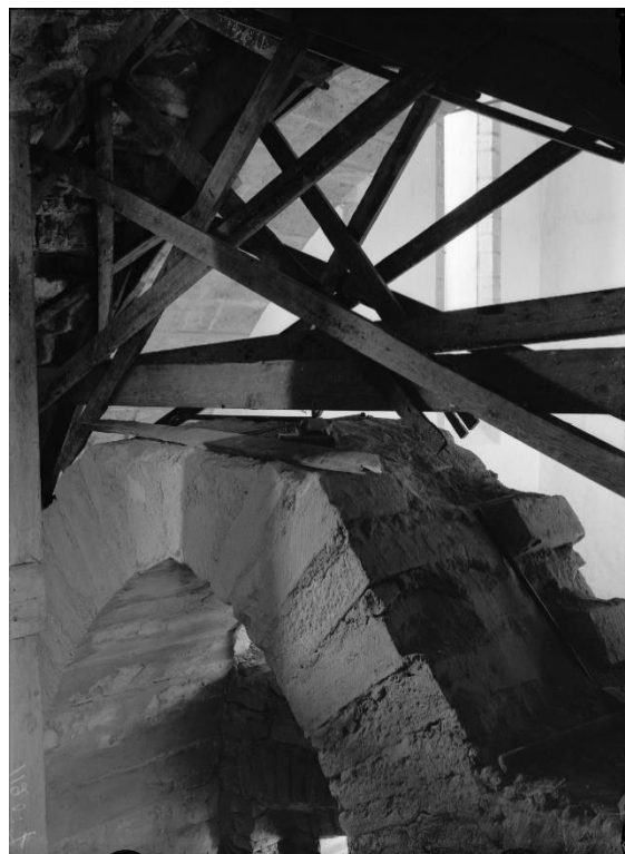
Ovan till vänster öppningen från ringkammaren till långhuset sedd från sydväst. Den stickbågiga dörren tillkom strax efter raset 1858. Den spetsiga avlastningsbågen från 1867 har ett utförande och en placering som gör att den möjligen skulle varit öppen mot kyrkorummet. Ovan till höger och nedan muren mot ringkammaren rivs 1926 sedan läktaren avlägsnats. Foto Alfred Edle 1926, ATA.
