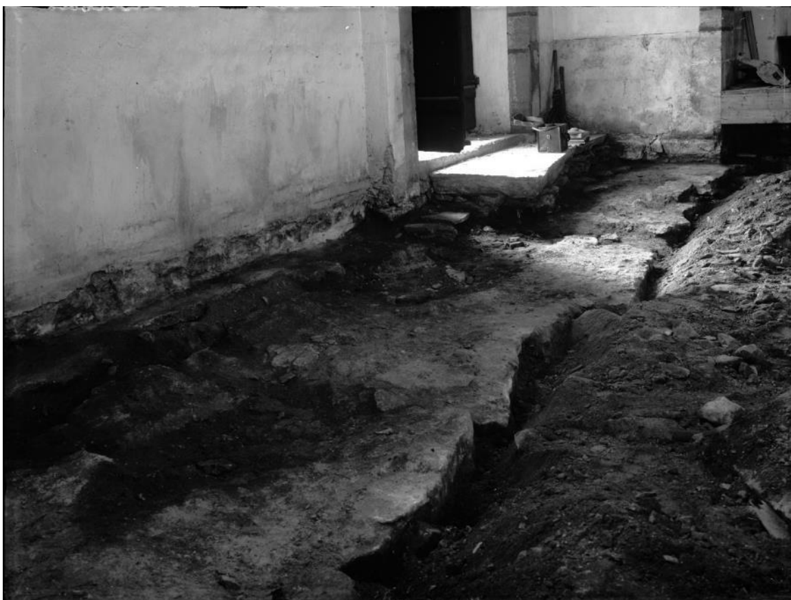
Grundmurar till det äldre långhuset, frilagda under restaureringen 1925-26, ovan norra och södra muren mot öster, nedan södra muren mot sydväst. Triumfbågsmuren synes tidigare ha legat väster om nuvarande triumfbågen. Foto Alfred Edle 1926 (oriktigt daterade 1932), ATA.
