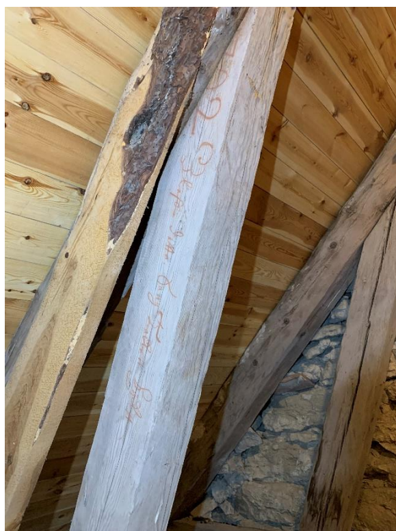
Avbränt ställningsvirke i triumfbågs-muren, kanske från den eldsvåda 1695, som omtalas på kyrkklockan. Till höger en av flera inskrifter på takstolen, denna från 1702 berättar om takbygge, kanske efter branden. Foto JL 2021.
