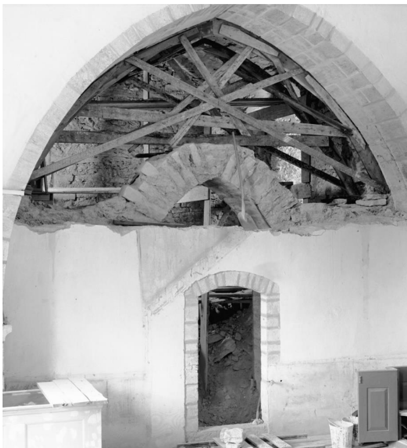
Ovan till vänster öppningen från ringkammaren till långhuset sedd från sydväst. Den stickbågiga dörren tillkom strax efter raset 1858. Den spetsiga avlastningsbågen från 1867 har ett utförande och en placering som gör att den möjligen skulle varit öppen mot kyrkorummet. Ovan till höger och nedan muren mot ringkammaren rivs 1926 sedan läktaren avlägsnats. Foto Alfred Edle 1926, ATA.
