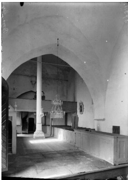
Interiör mot väster före restaureringen 1925-26. Nedan förstoring. Bilden visar det flacka trätunnvalv som på 1860-talet ersatte de rasade murade valven. Mittkolonnen är av trä. Läktaren tillkom vid samma tid liksom väggen i tornbågen. Läktaren ersatte en äldre, men att bänkinredningen och predikstolen bibehölls tyder på att valvraset främst drabbade långhusets västra del. Foto Anders Roland 1925, ATA.
