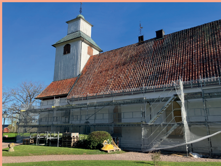
Götlunda kyrka får en yttre renoverings som förväntas pågå en bit in i juni.
