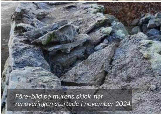
Thomas i fullt arbete med att sätta skolsten och skärv, för stabilitet i muren.
