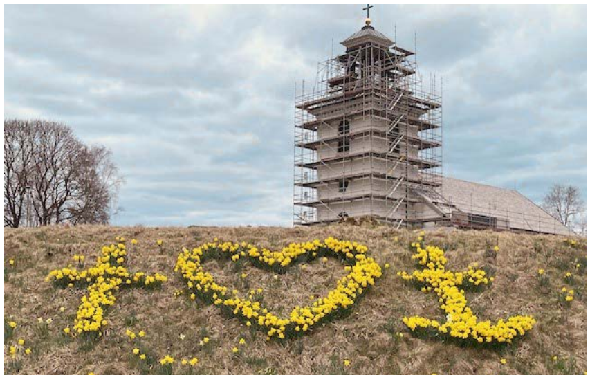
Rångedala kyrka har renoverats! Nylagt skiffertak, renoverad och ommålad port, målning av fönster och trädetaljer, ny puts och färg på fasaden.
