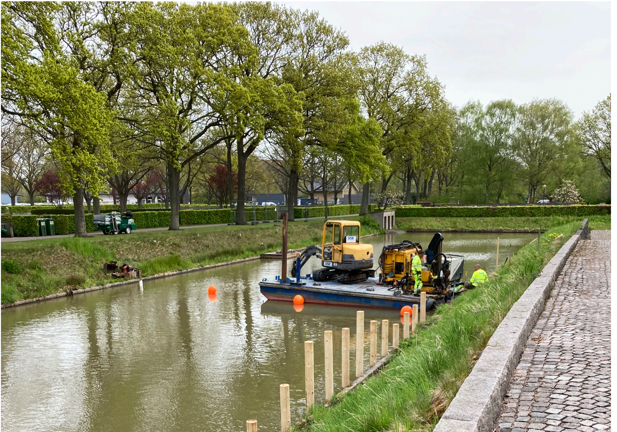
Renoveringen av krematoriets vallgrav fortsatte med etapp två under 2022. Arbetet syftade bland annat till att förstärka vallgravens släntskydd och kantskoning Fotograf: Fredrik Torstensson
