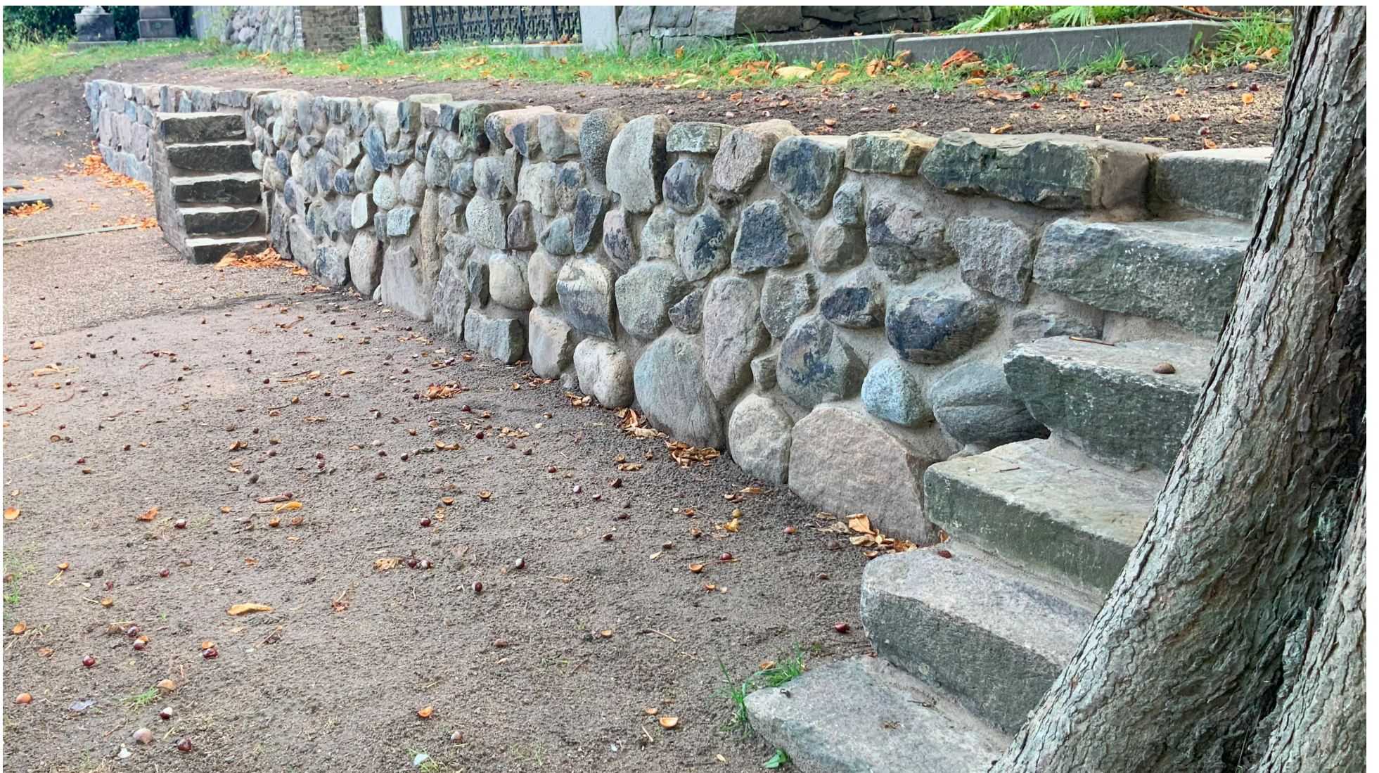
I centrum fortsatte arbetet med att renovera terrassmurarna och trappan upp från Gamla Kyrkogården. De gamla murarna har renoverats och försatts med en gjuten stödmur. Fotograf: Fredrik Torstensson
