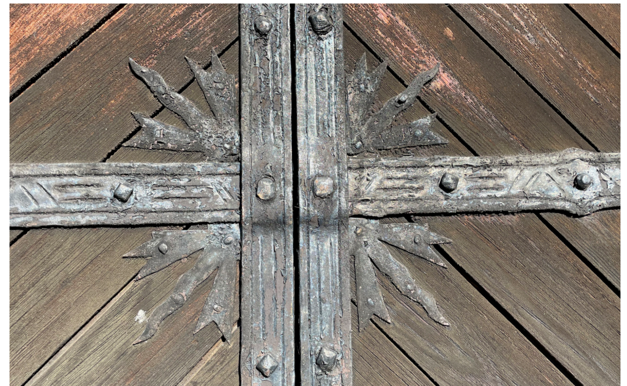
Detaljbild på smidesbeslagen på dubbelporten in till gravkapellet.
