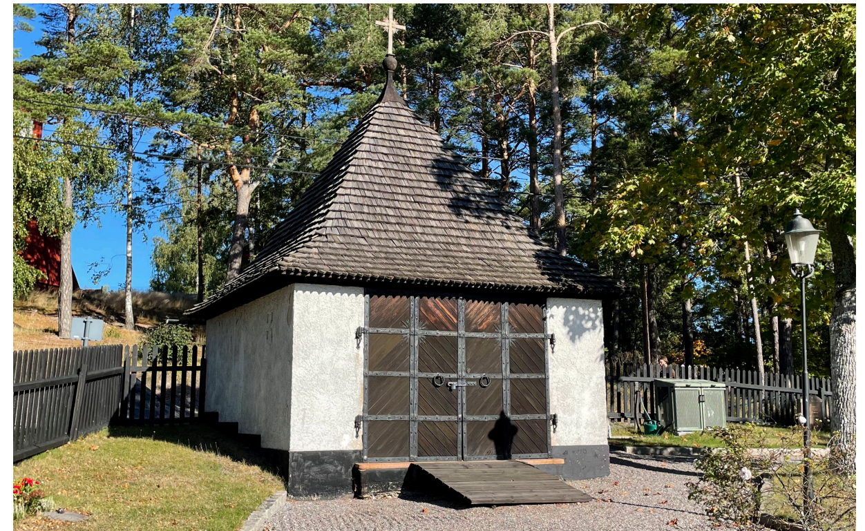
Gravkapellet med dess spånklädda tälttak och dubbelsidiga port, placerad i den norra delen av kyrkogården.
