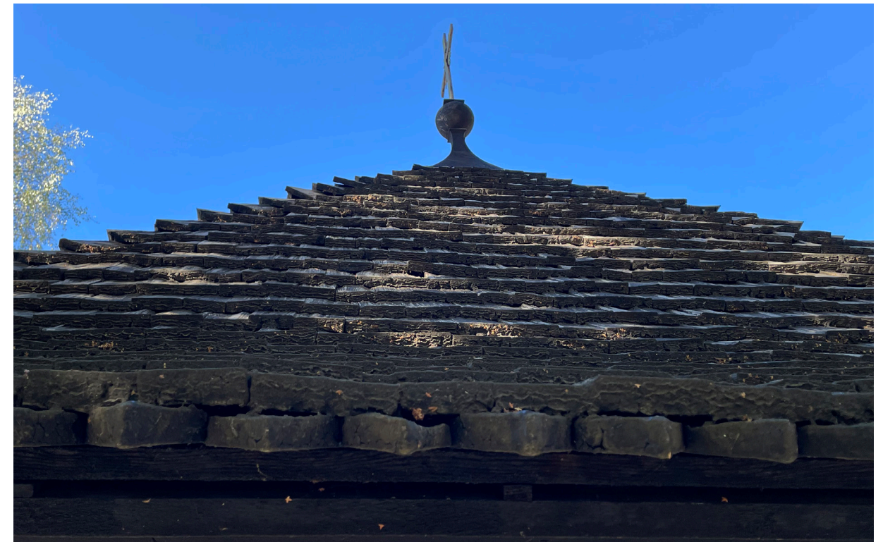
Spåntaket, med spån med ett spetsigt avslut i nederkant.
