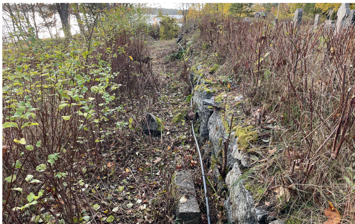
Bogårdsmurens östra sträckning mot söder.
