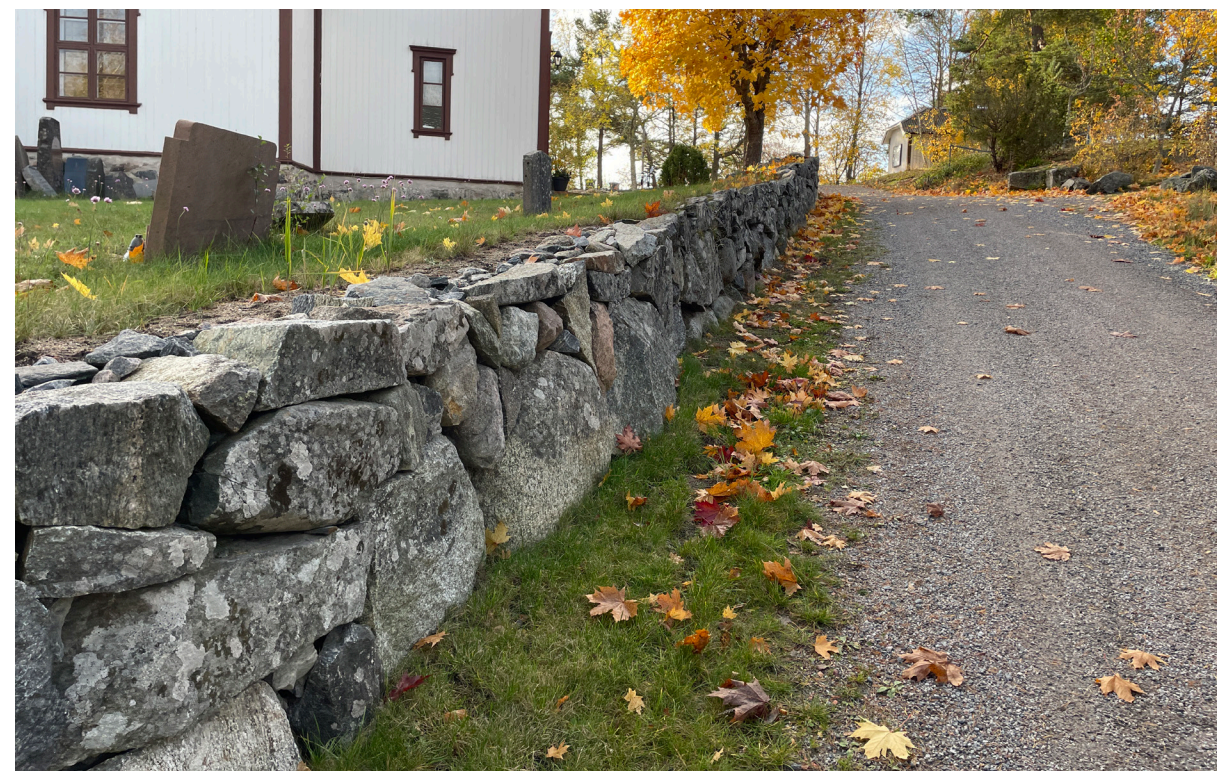
Den västra sträckningen av bogårdsmuren, bitvis omlagd under 2020-talet. I nordväst har jord har fyllts på upp till murens överkant.
