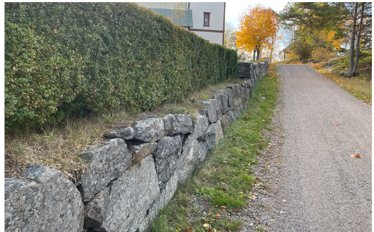
Bogårdsmurens norra sträckning av bogårdsmuren flankeras av buxbom. Buxbomshäcken fungerar som fallskydd. Häcken skulle kunna kompletteras och förlängas till de delar som har stor höjdskillnad, vilket särskilt gäller den södra delen av muren.
