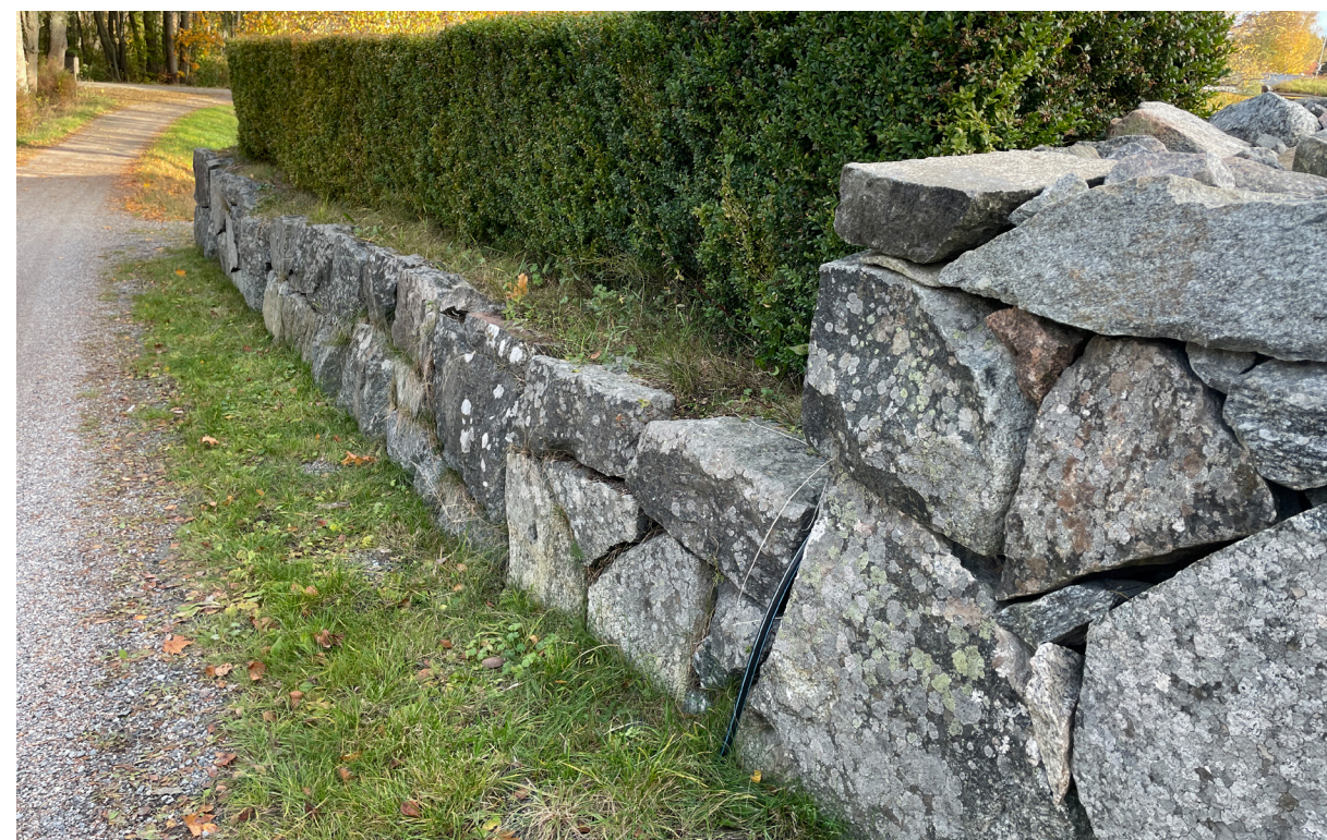
Bogårdsmurens västra sträckning mot norr med en högvuxen buxbomshäck.
