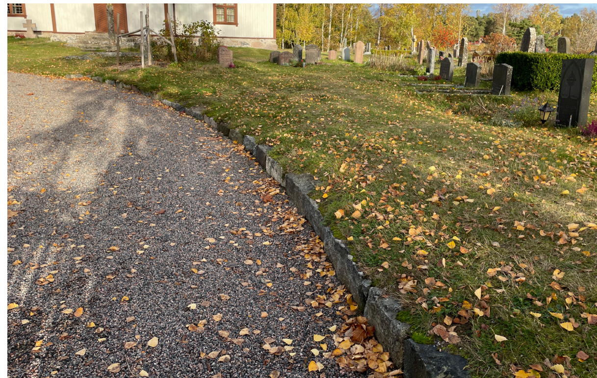
Längs med grusgången ligger varierande storlek på kantsten.
