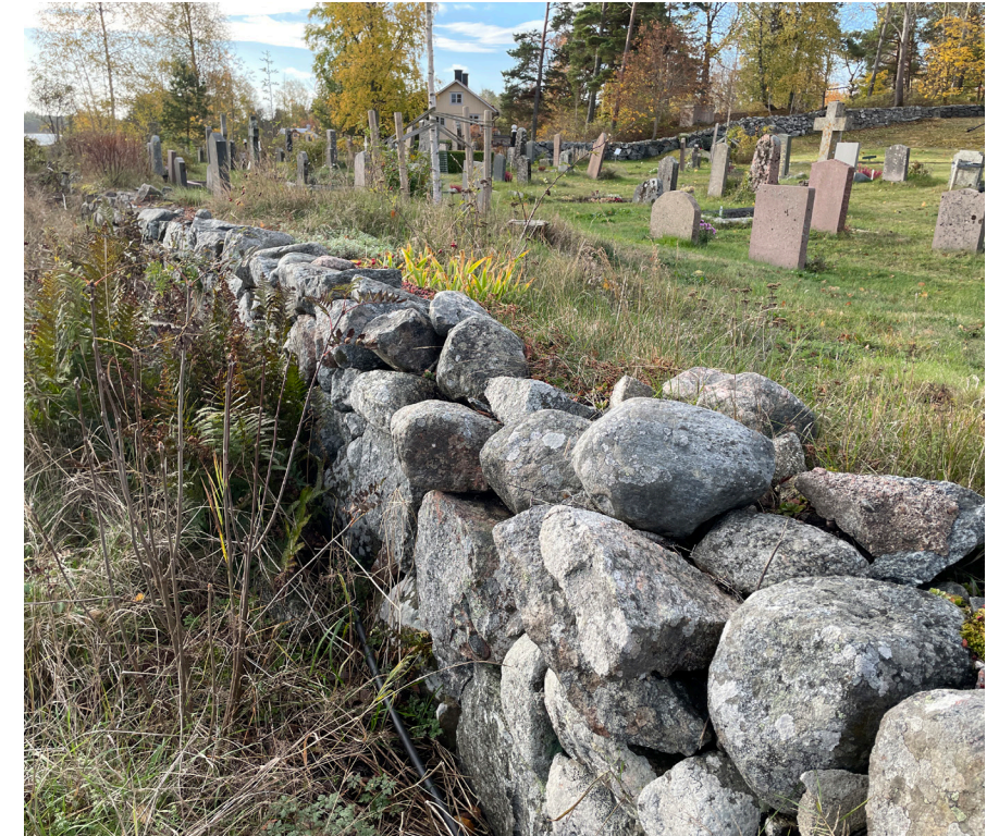
Bogårdsmurens östra sträckning med fältsten.
