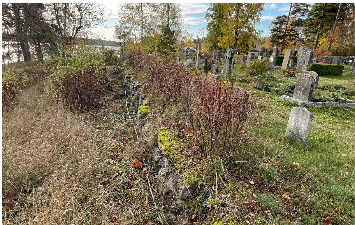
Bogårdsmurens östra sträckning flankeras av snöbärbuskar öster om mursträckningen och syrener väster om mursträckningen.
