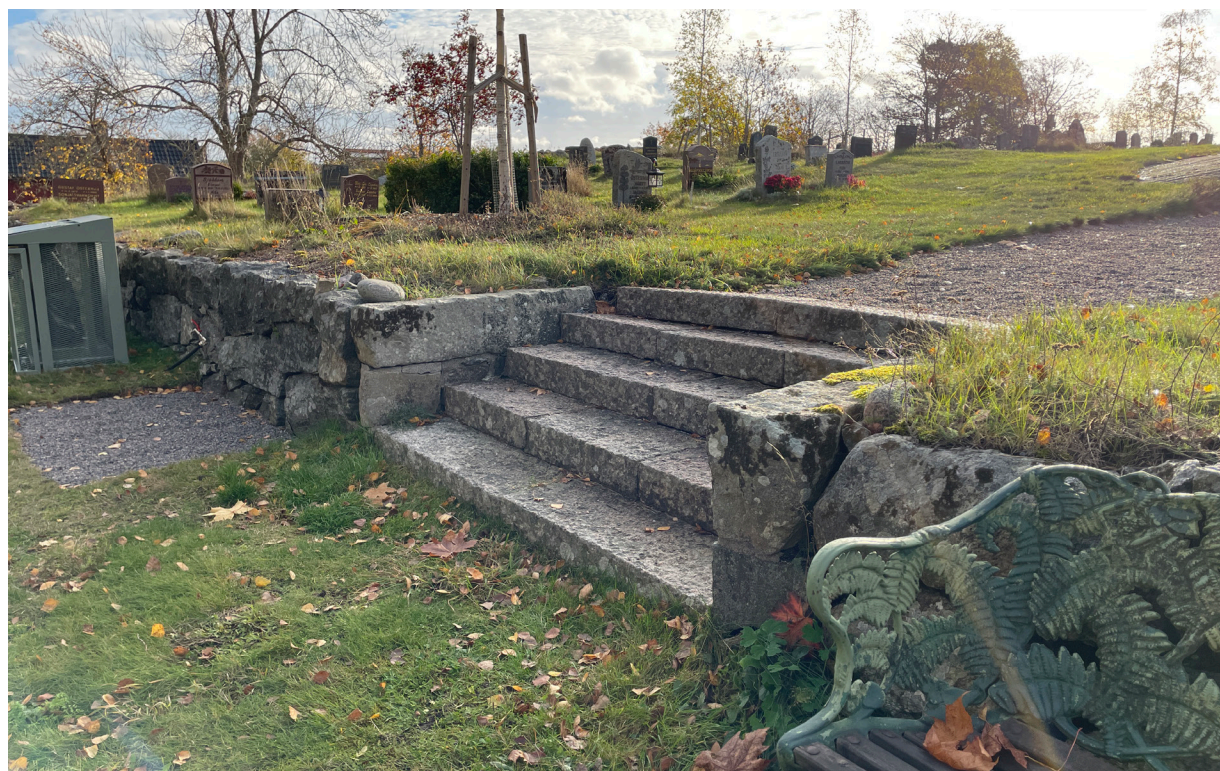
Stentrappan i terrassmuren mellan den norra delen och kvarteren direkt invid kyrkan.
