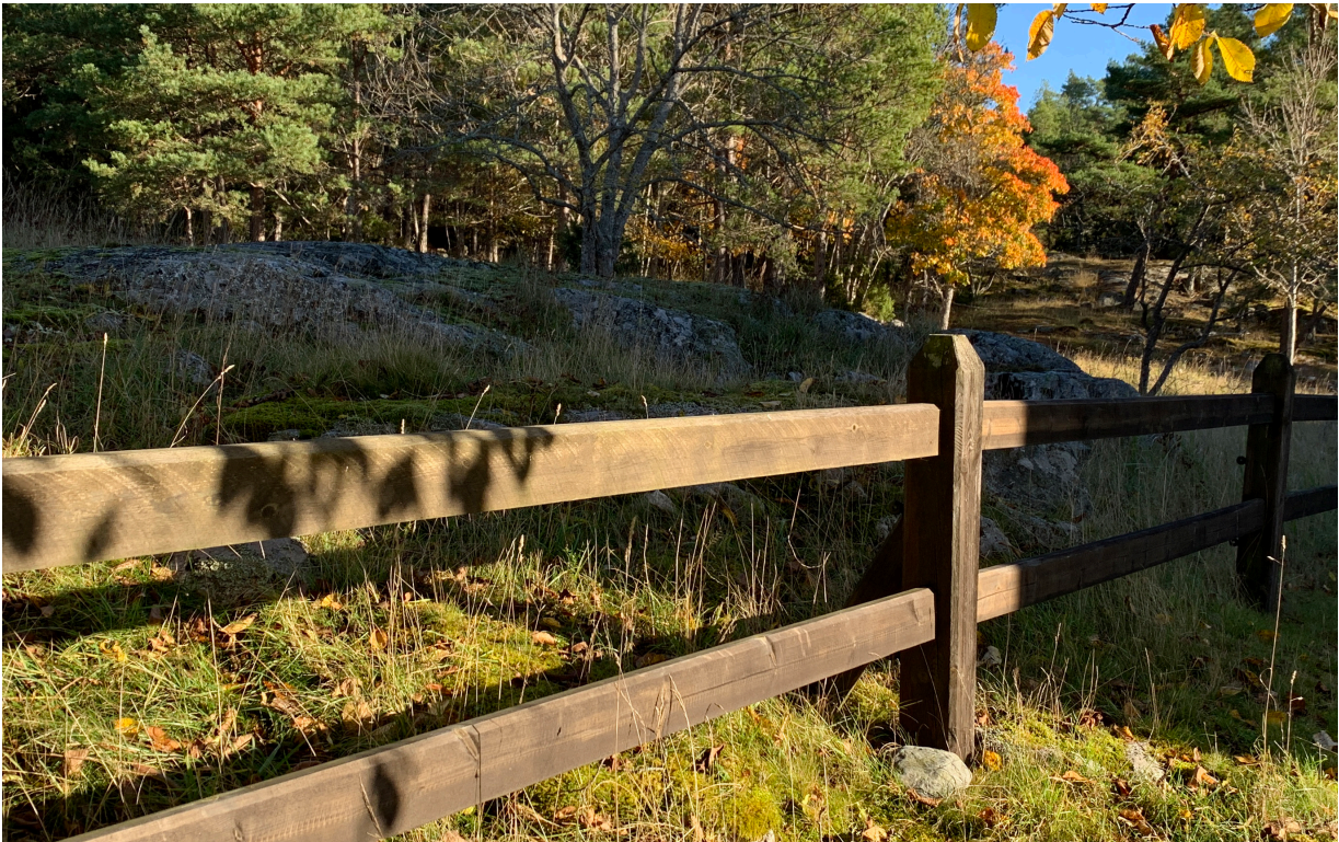
Omgärdande trästaket norr om kyrkan. Staketet renoverades till stora delar under 2021.
