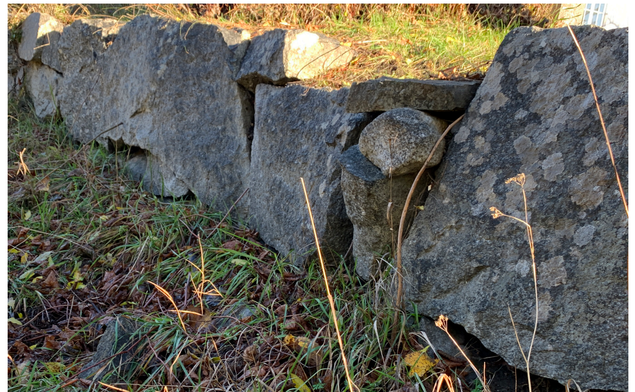
På bilden syns att krönsten har fallit ut längs murens västra sträckning.
