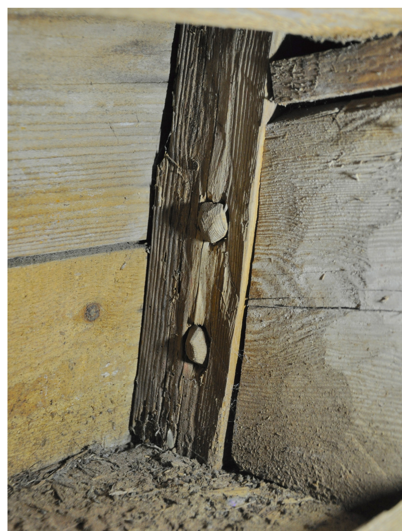
Fint arbetad takfotsknut med täljda skallar på dymlingarna.
