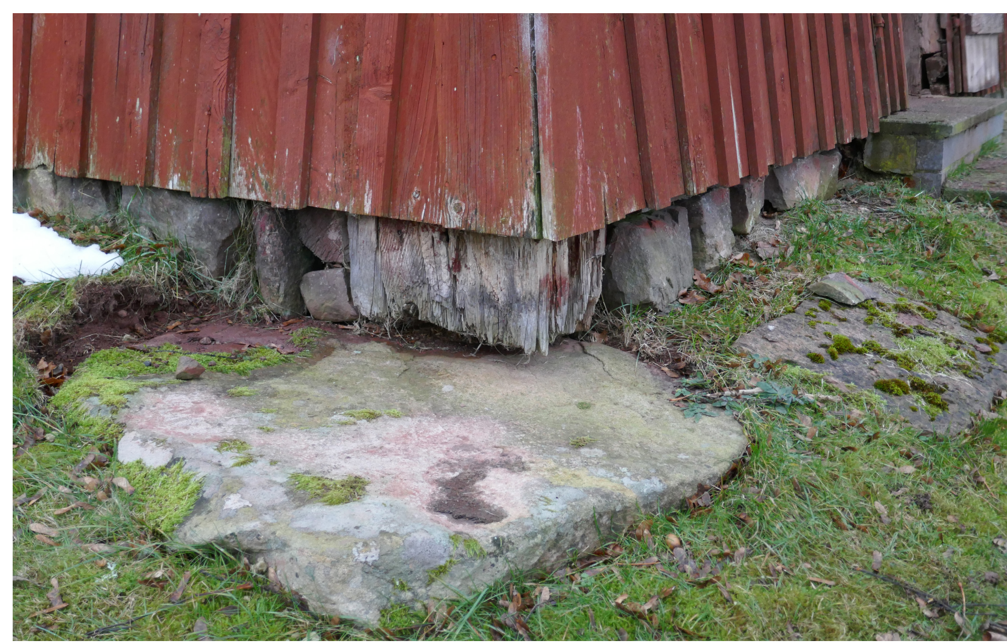
Stolparna står på stora stenhällar.
