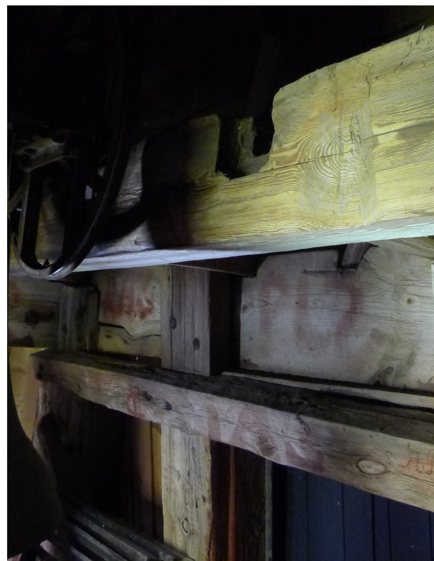
I takbjälkarna kan man se var klockorna från början hängt.
