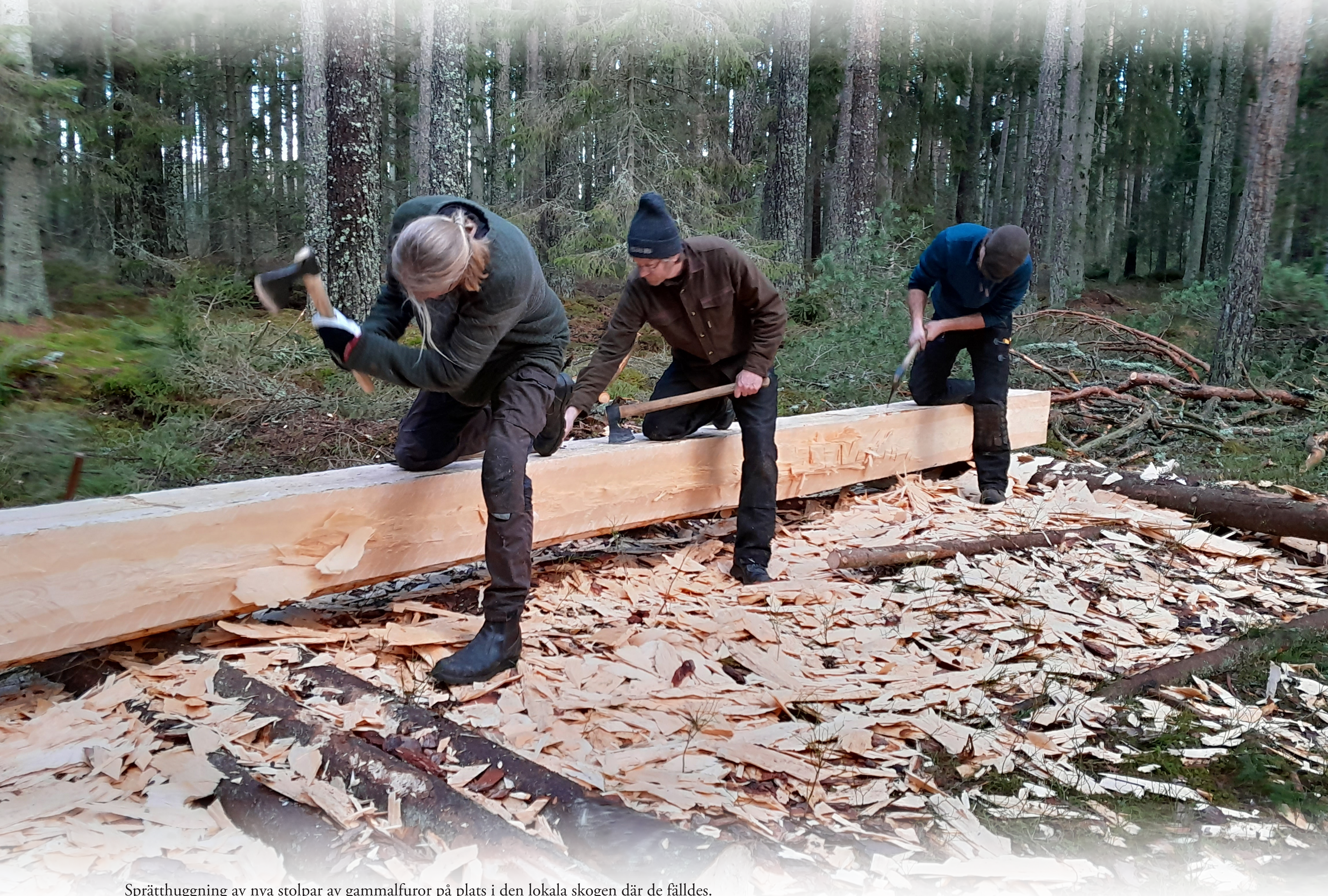
Sprätthuggning av nya stolpar av gammalfuror på plats i den lokala skogen där de fälldes.
