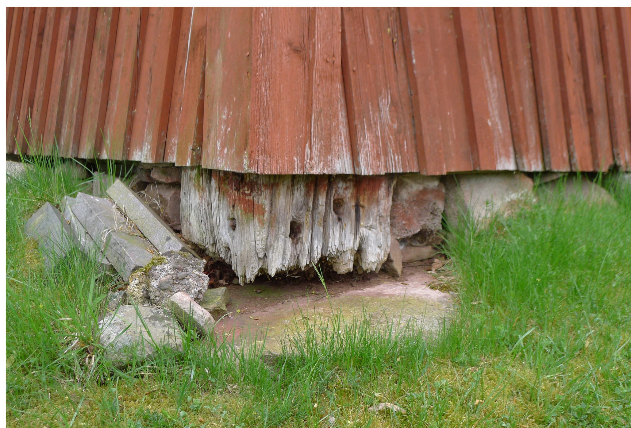
Avruttad hörnstolpe och överväxt stenhäll.
