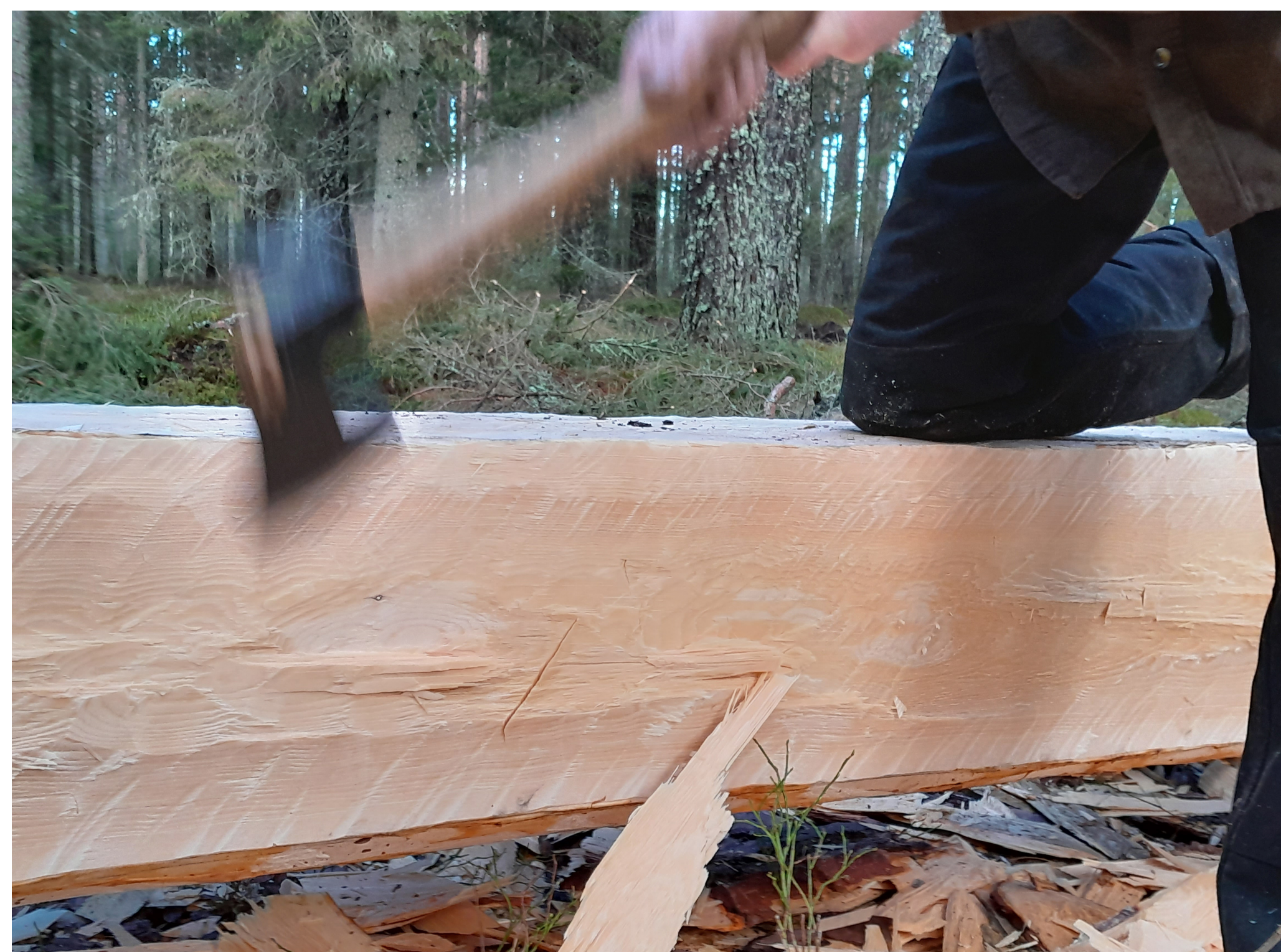
Närbild av sprätthuggning av ny stolpe.
