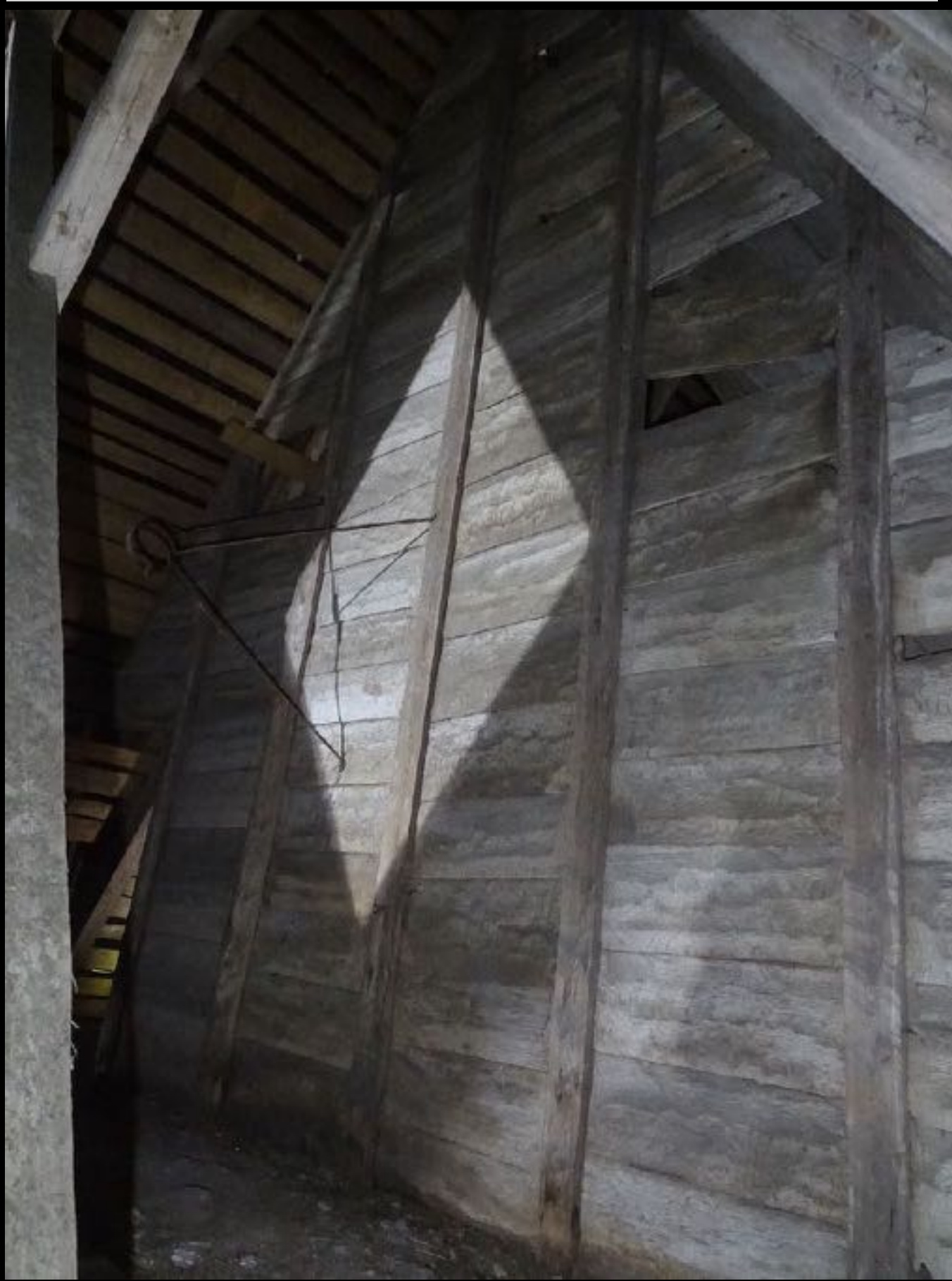
Jät ga kyrka med exponeringsvägg av skiftesverk 1200-tal. Vägglankorna liknar de vi hittat i Mortorp och Våthults kyrkvindar.
