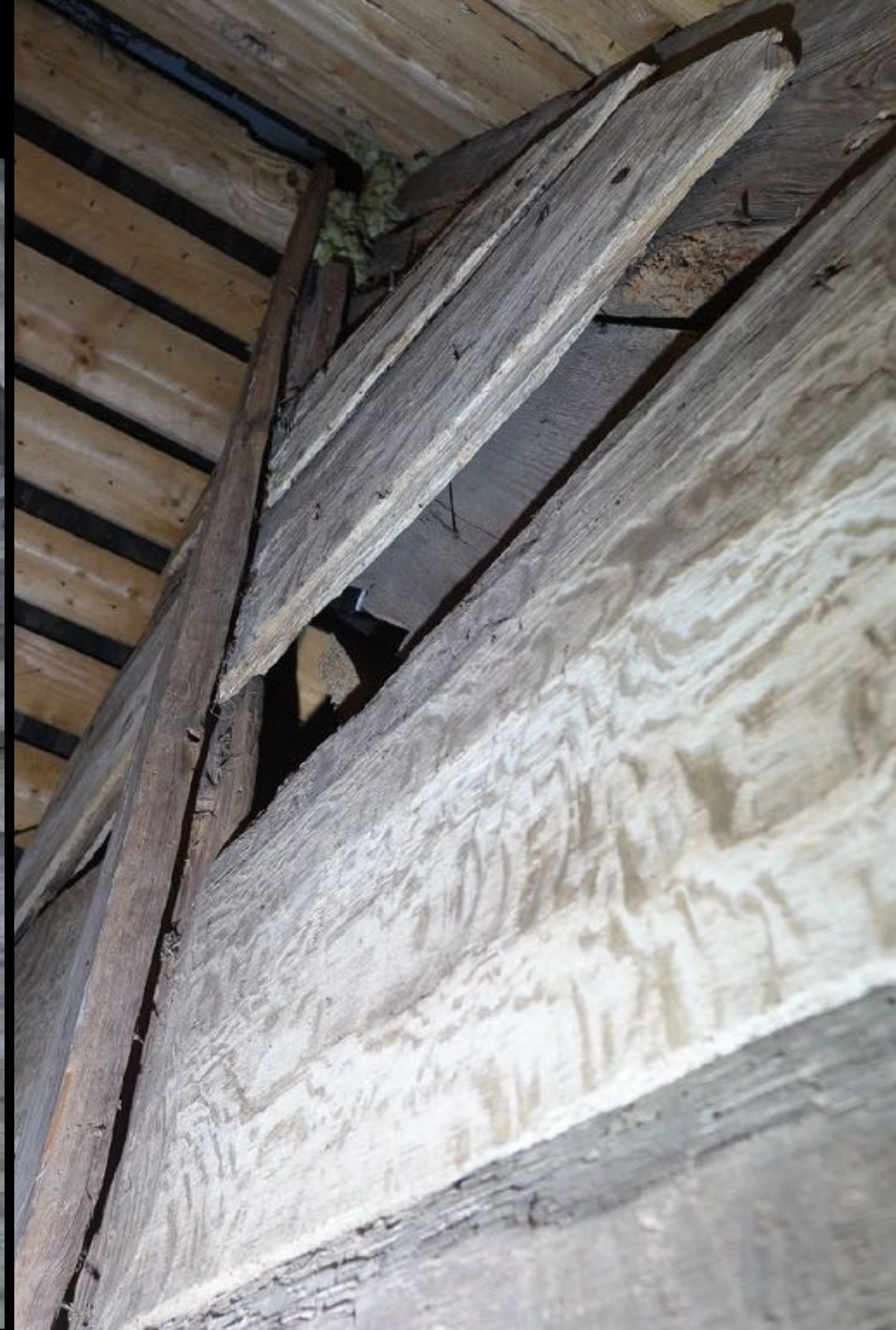
Jät ga kyrka med exponeringsvägg av skiftesverk 1200-tal. Vägglankorna liknar de vi hittat i Mortorp och Våthults kyrkvindar.
