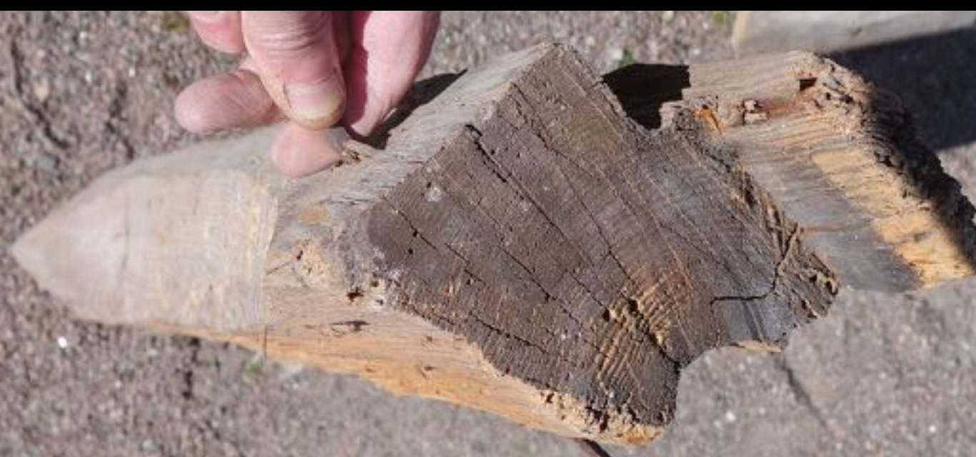
Koretsnockstyrbjälke med fals för taktro
