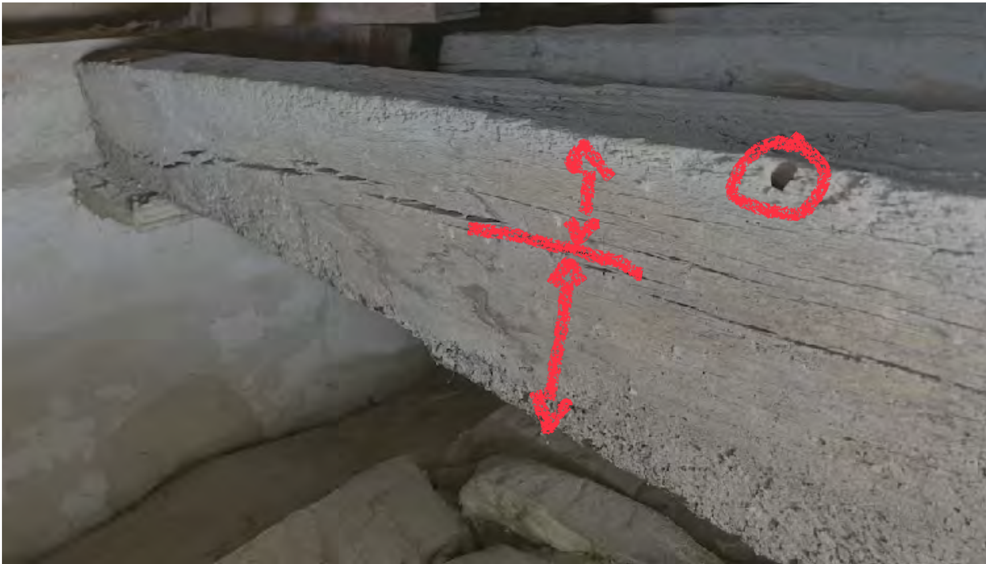
Resmo skepp konvex bindbjälke 13, dendroprov 58049 efter 993
