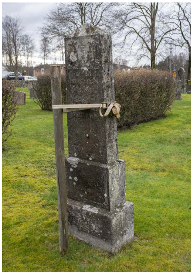
De vanligaste skadorna är påväxt av olika slag, samt instabilitet. Vården ovan har stabiliserats provisoriskt i stående läge. (13:68)
