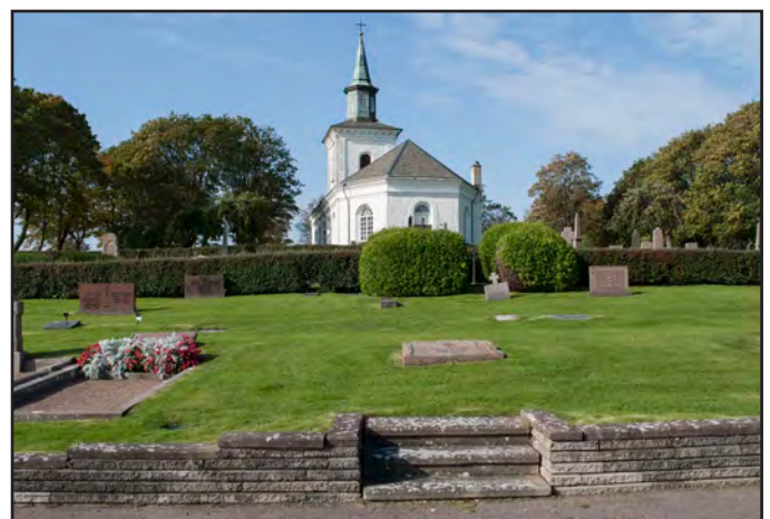
I den utvidgade delen av kyrkogården finns trappor och stödmurar i kalkcementsten från 1980-talet.
