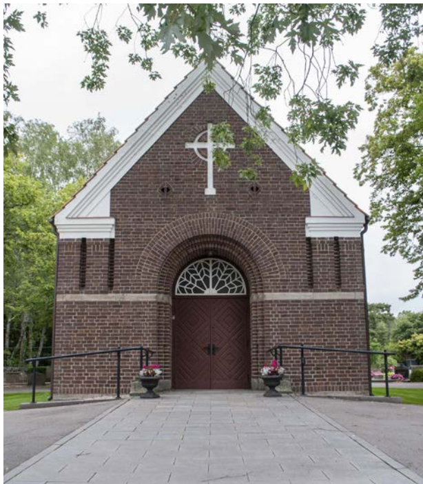
Gången fram till kapellet har byggts upp som en ramp.
