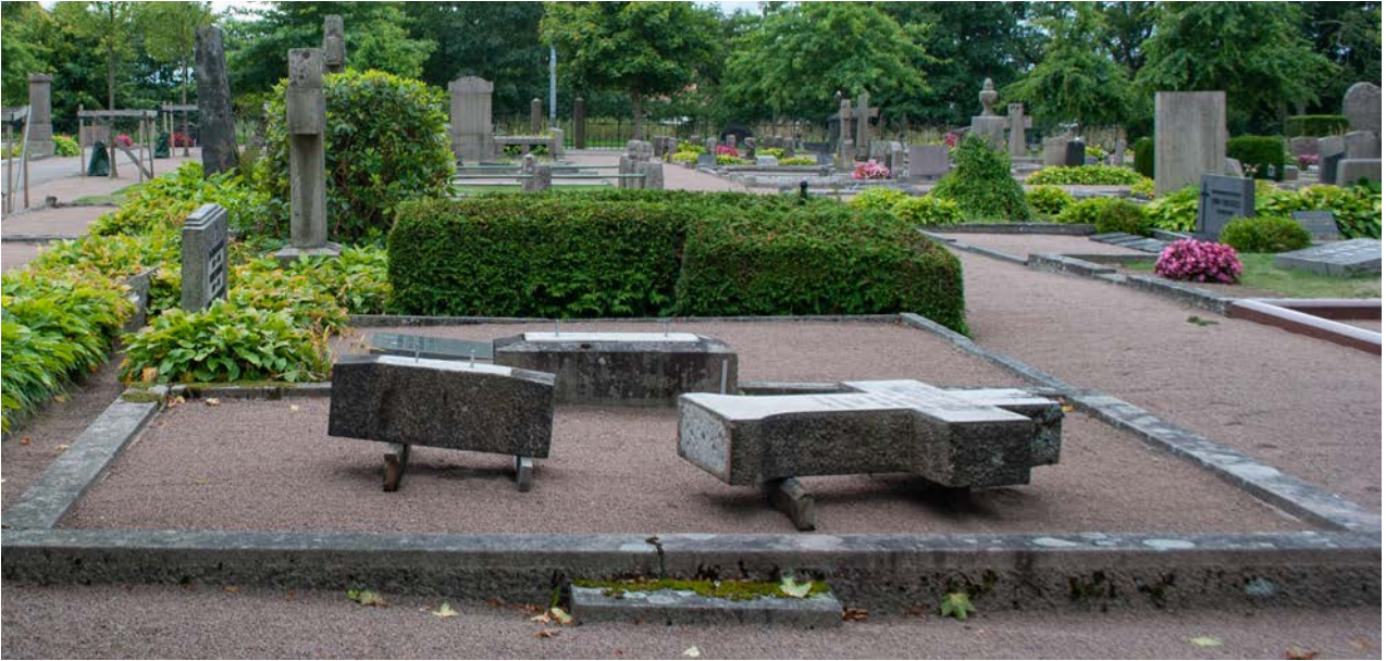
Några gravvårdar har fått läggas ned på grund av instabilitet. Här ett stort stenkors på fundament över Philibert (1855-1923), Wahlborg Nyman (1862-1918) och Eira (1888-1947). (14:1)
