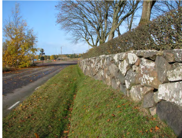
Kallmuren i söder, äldre kyrkogårdsdelen.
