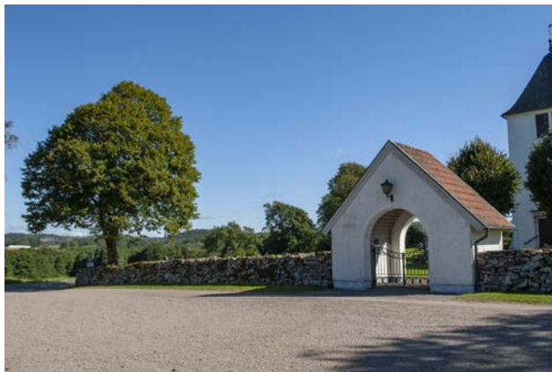
Stigluckan och muren mot väster.
