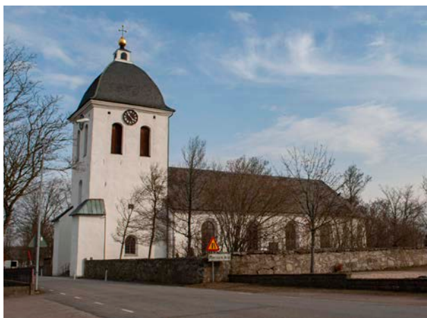
Muren runt den äldsta delen av kyrkan.
