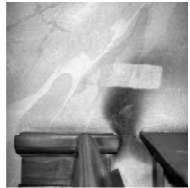
Hur smutsen avsatts på ytan avslöjar här ett elements placering. Den rena rutan är ett rengöringsprov. Hedvig Eleonora kyrka. Foto: I. Hemgren.
