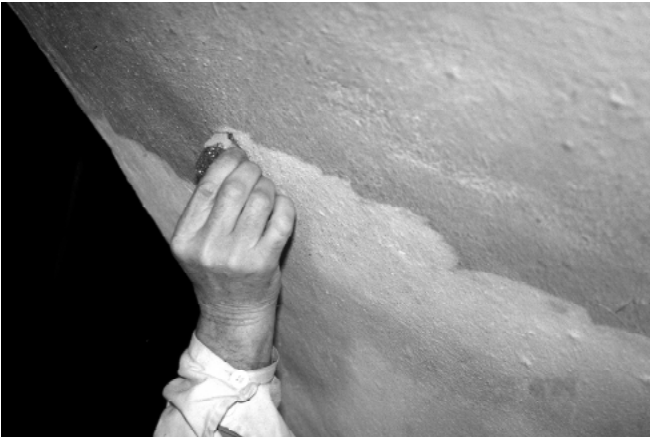
Den viktigaste åtgärden för kalkmålningarnas del inför en längre periods avstängning av värmen är att ytsmutsen avlägsnas. Här ett exempel på torrensöring. En metod som är lämplig för porösa ytor. Foto: I. Hemgren.
