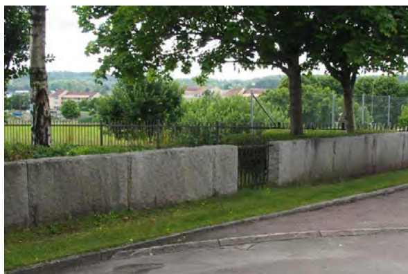
Planerad grindöppning, idag med staket i dess ställe. Nära ekonomiytan i nordväst.
