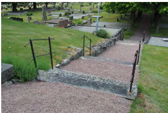
Terrängtrappor norr om kyrkan. Trapporna har olika typer av smidesräcken. Den nedersta trappan har ett räcke med formgjutna stolpar i gjutjärn.
