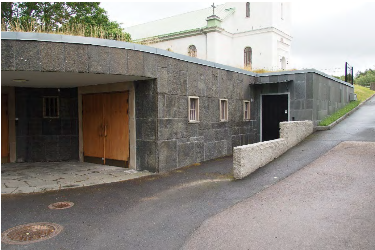
Även åt sydväst har byggnaden byggts till. Här är dörren målad i svart.
