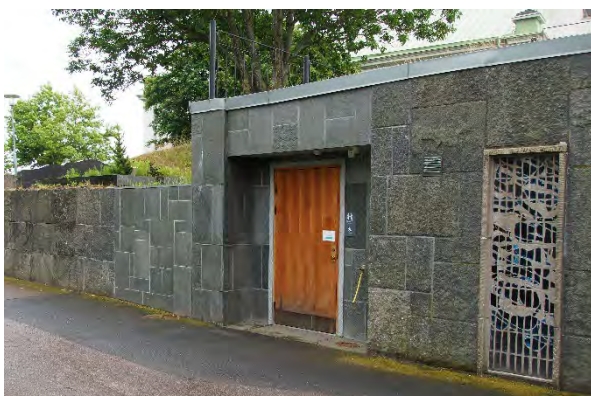
Den på 2000-talet tillbyggda delen med RWC skiljer sig något i uttryck från den ursprungliga byggnaden.
