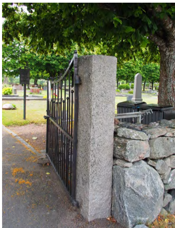
Den östra pargrinden är också äldre och utformad likt den södra, men har två sentida, grovt huggna grindstolpar med kilmärken. Grindbladen står vanligtvis uppställda.
