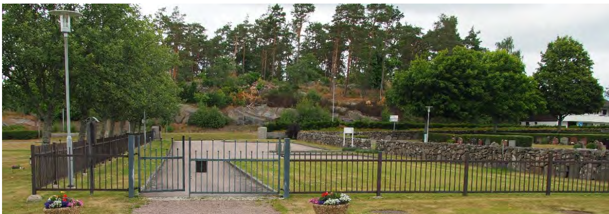
Smidesstaket med körgrind vid parkering i norr. Grinden är utformad med inspiration från de äldre grindarna.
