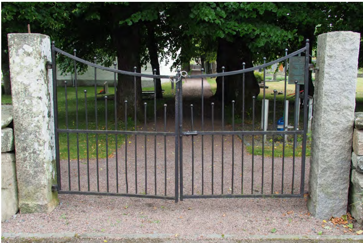
En av kyrkogårdens äldsta pargrindar, placerad i mittaxeln, norr om det Sahlgrenska gravkoret. Den östra (vänstra) grindstolpen är äldre, pikhuggen slät. Den västra (högra) grindstolpen är sentida, grovt huggen.
