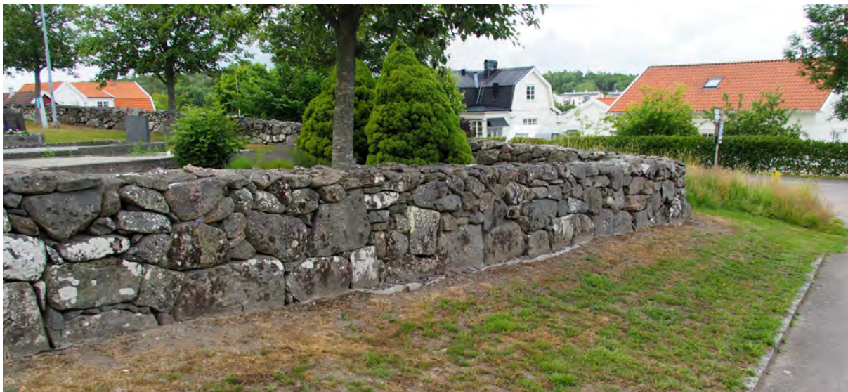
Kallmur kring kvarteren runt kyrkobyggnaden. Exempel från det sydöstra hörnet.
