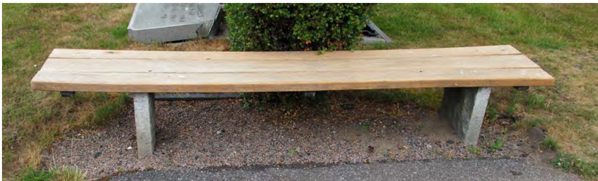
Exempel på bänk med sittbräda i ek och fundament i granit. Sannolik ursprunglig gestaltning för gravområde Akleja och i sådant fall design Axel Forssén.
