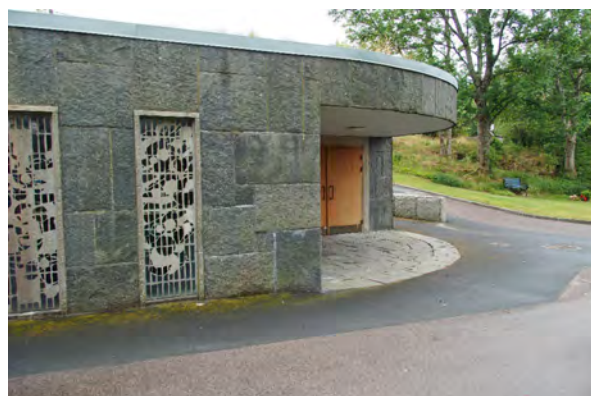
De dekorativa betongglasfönstren är formgivna av Gunnar Larsson, Gustavsberg.
