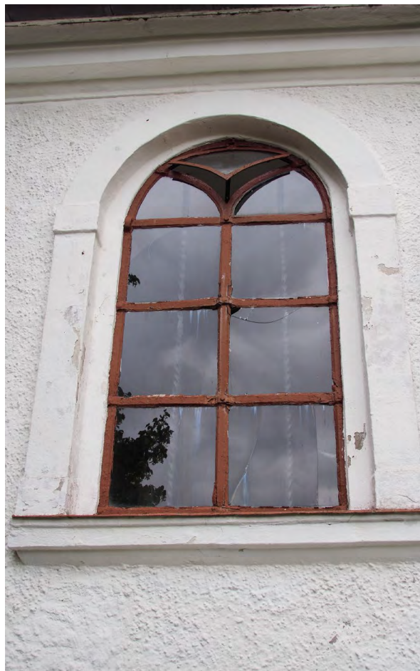
Gravkorets fönster är av järn och är upptill öppningsbar.
