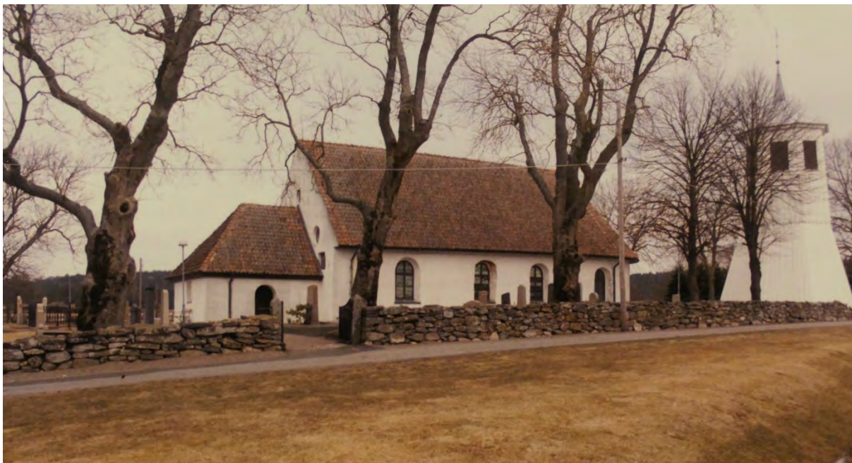
Fotografi från år 1986. Från antikvarisk rapport upprättad i samband med interiöra åtgärder. Rapport och fotograf: Arne Tollbom, DEFYRA Byggnadsvårdskonsult AB. Källa: Älvsåkers kyrkoarkiv/Landsarkivet i Lund.
