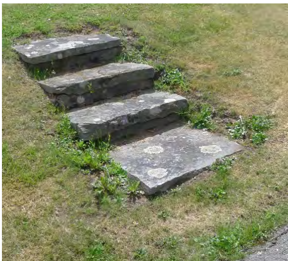
Naturstenstrappa i den norra delen av kvarter B.
