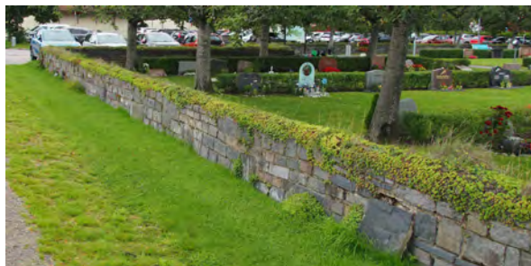
Södra stenmuren, åt väster.
