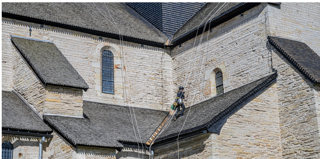
↑ Taket på Varnhems klosterkyrka har fått ny tjärbeläggning under våren.
