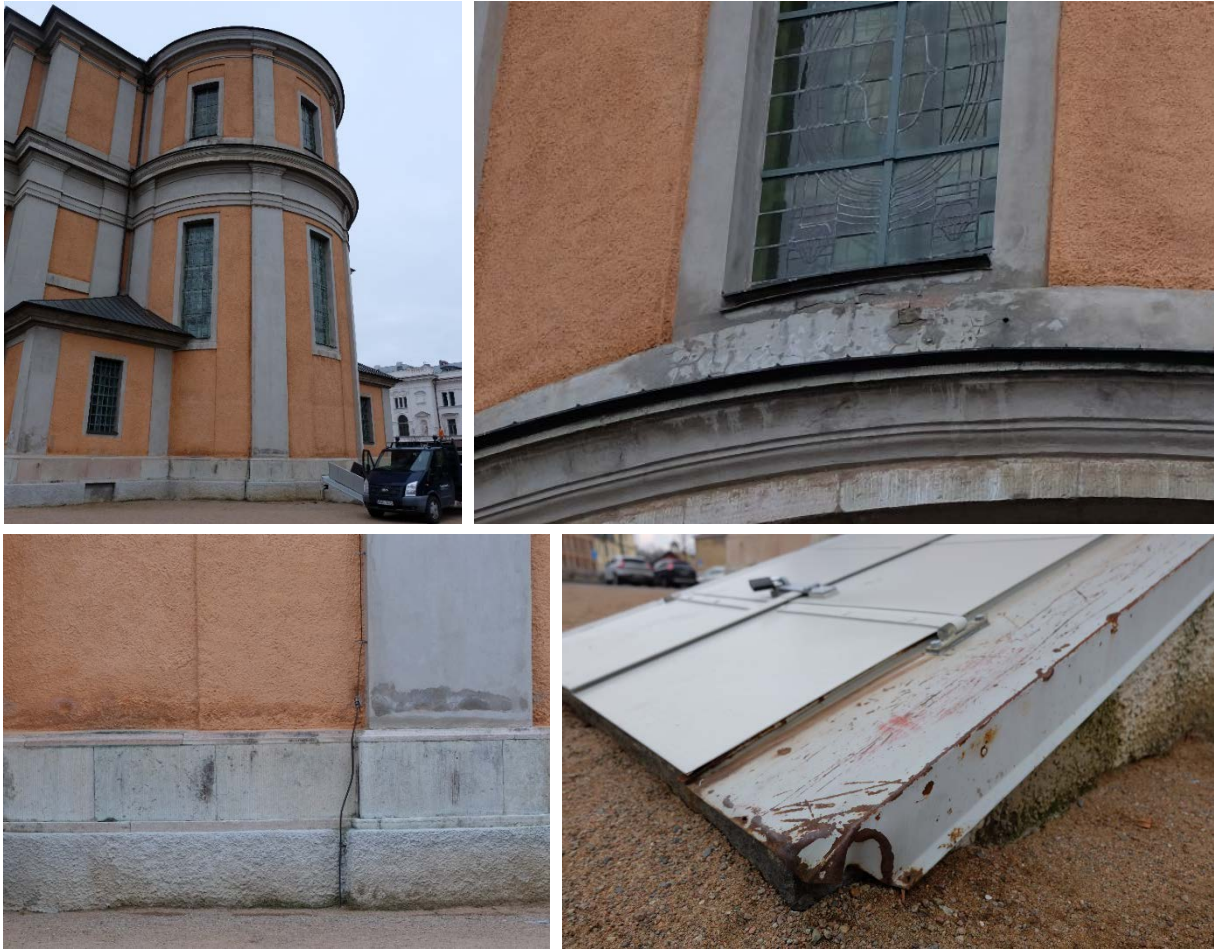
Figur 7 - Överst fr. v: Översiktsbild på absiden. Gördelgesimsen har sprickor/färgbortfall. Fuktfläckar på fasad och pilaster. Plättäckningen bredvid luckan är bucklig och har sliten bemålning.
