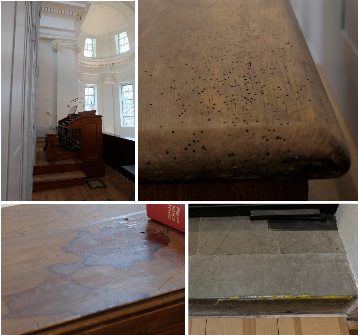
Figur 23 - Överst fr. v: Översiktsbild på den norra läktaren. Angrepp av strimmig trägnagare i spelbordets sittbänk. Underst fr. v: Fläckar på läktarbarriären. Gammal kontrastejpp på kalkstenskant.
