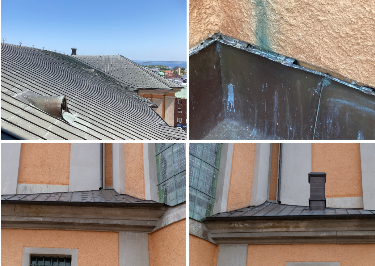
Figur 10 - Överst fr. v: Översiktsbild över det södra takfallet. Fogbortfall över ståndskiva. Underst fr. v: Översiktsbild över konsistorierummets tak. Översiktsbild över sakristians tak.
