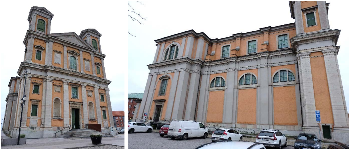
Figur 2 - Fr. v: Fredrikskyrkan sedd från väst. Fredrikskyrkan sedd från norr.
