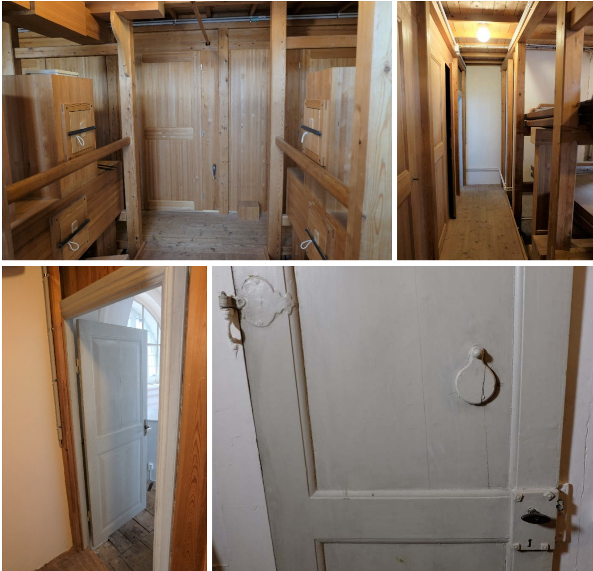
Figur 28 - Överst fr. v: Översiktsbilder över det undre planet av läktarens bakre del. Underst fr. v: En av dörrarna som leder ut till den västra läktaren. Dörren ut till trapphuset har mindre sprickor i bemålningen och enstaka färgflagning.
